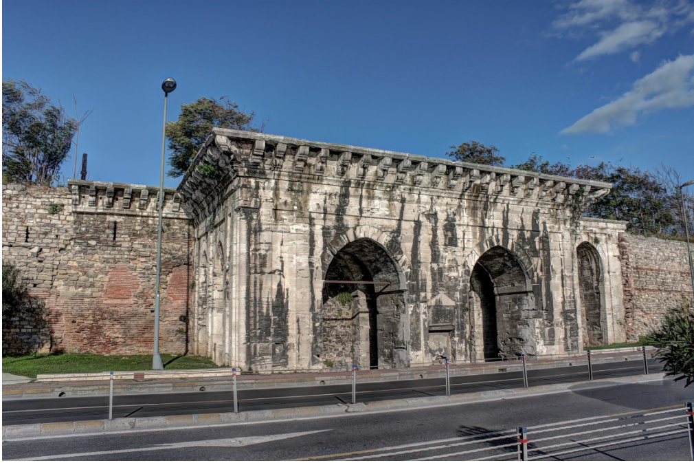
Şekil 2.4: Yapının günümüze kalan kısmı (b)
