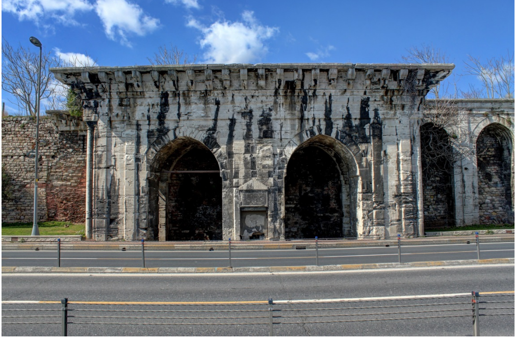
Şekil 2.3: Yapının günümüze kalan kısmı (a)
