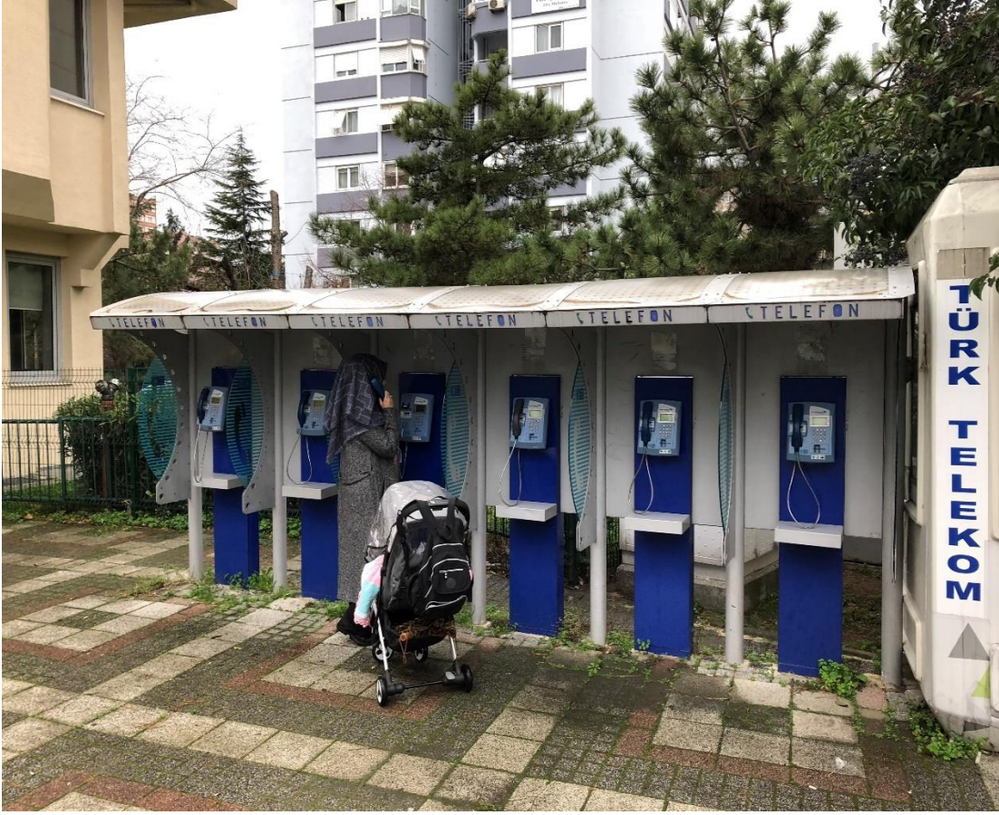
Şekil 3.27: Ataköy Mahallesi telefon kulübeleri (Yasir Gündüz, Aralık 2018)
