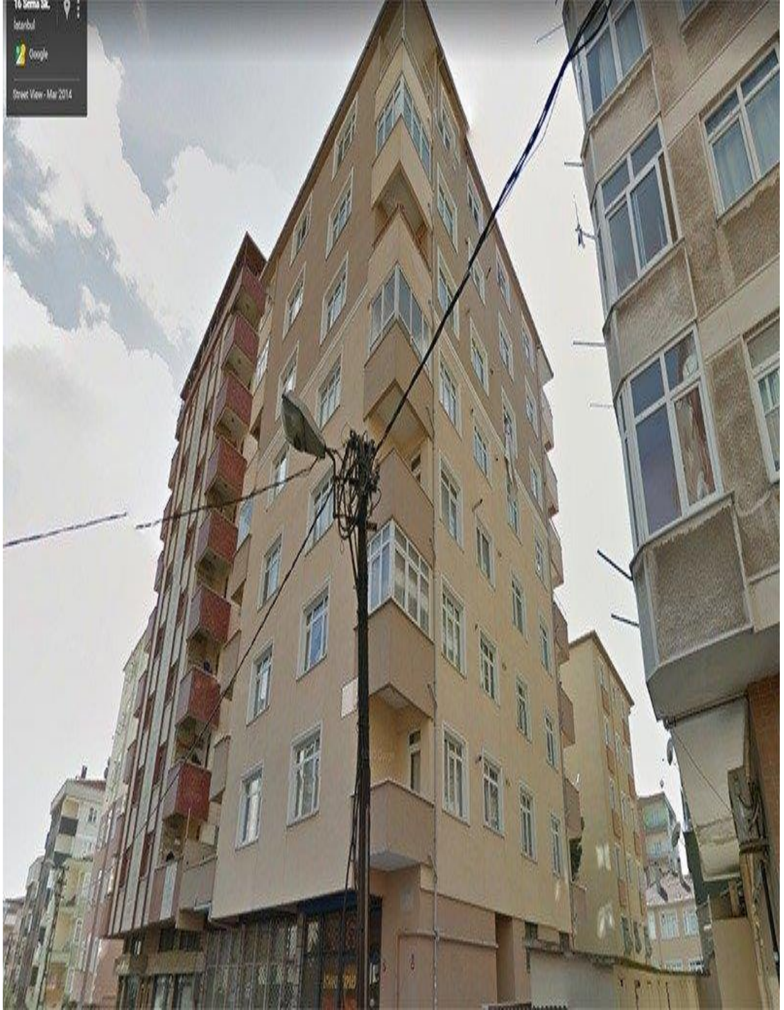
Şekil 36: Yeşilyurt Apartmanı Çökmeden Önceki Durumu
