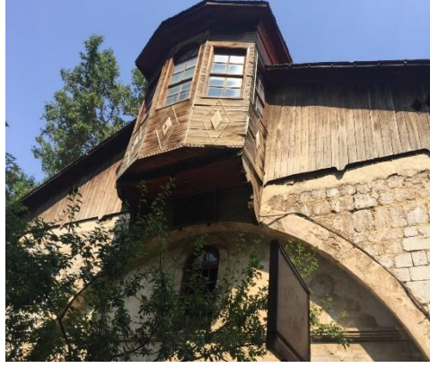
Şekil 52. Kemaliye Evlerinin Başoda Çıkıntısı
