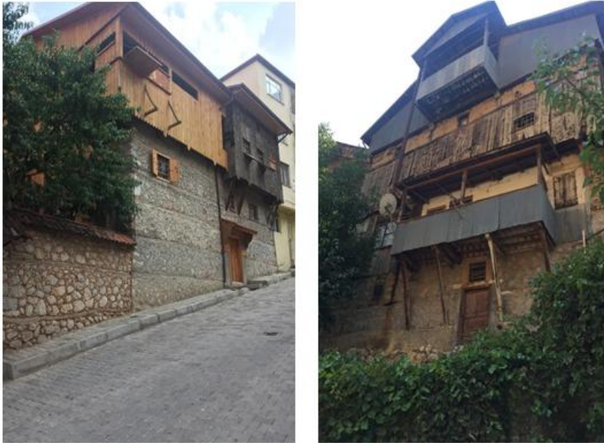
Şekil 40. Avluya Açılan Giriş Kapıları
