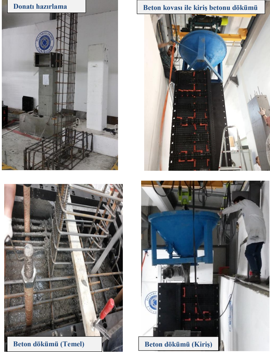
Şekil 2.8: KY 03-6.0 deney elemanına ait imalat aşamaları fotoğrafları
