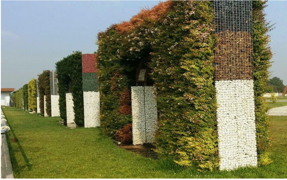
Şekil 3.17: Dikey bahçede metal çit bitkilendirme sistemine örnek [URL17]
