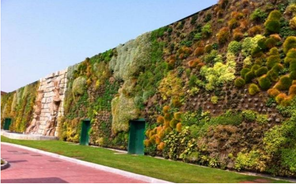
Şekil 3.16: Dikey bahçede metal çit bitkilendirme sistemine örnek [URL16]
