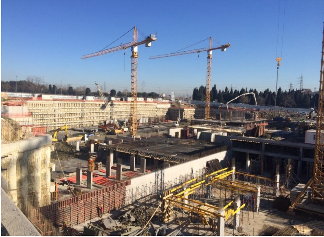
Şekil 4.2: Esenler İlçesi Kentsel Dönüşüm Yapım Aşaması Fotoğraf
