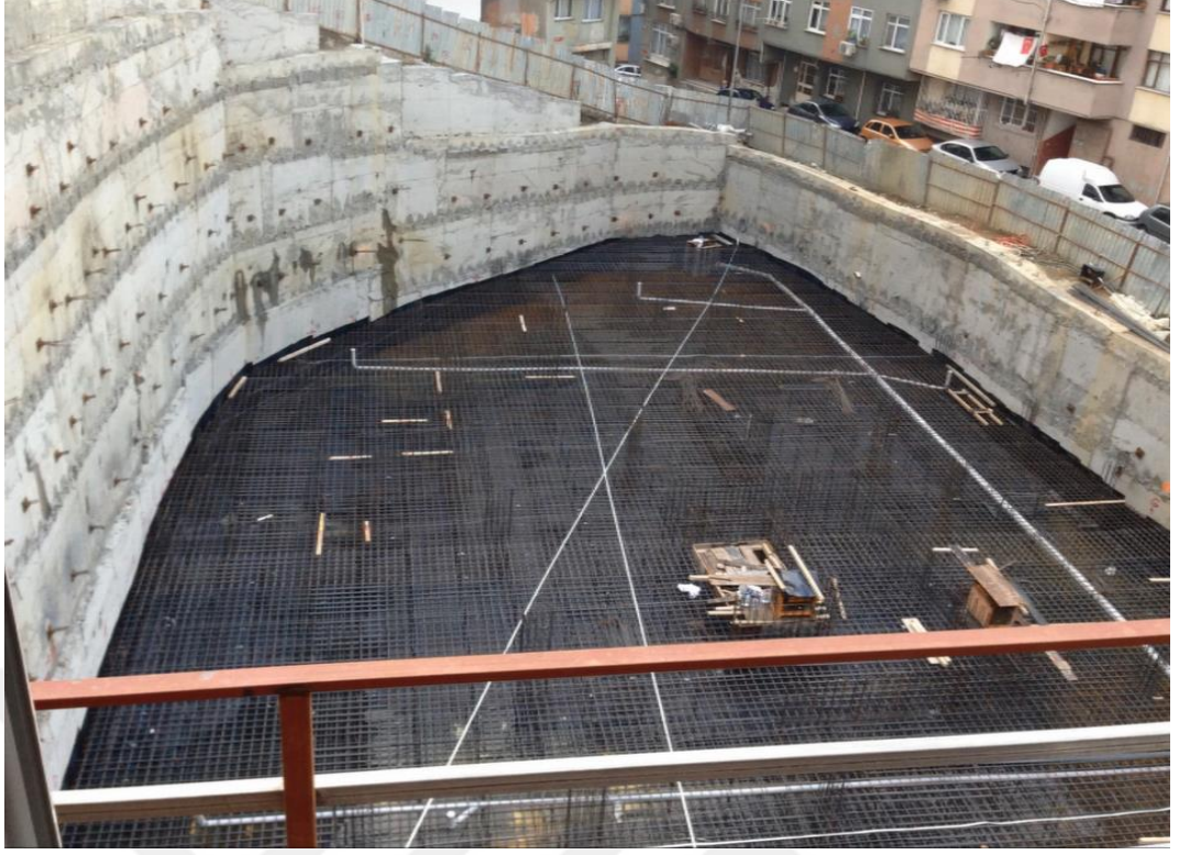
Şekil 4.8: Kağıthane Kentsel Dönüşüm Ada Tepe Teras Temel İnşaatı
