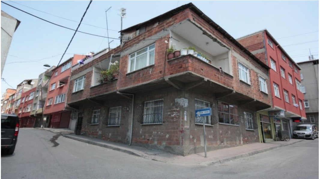
Şekil 4.1: Esenler İlçesi Kentsel Dönüşüm Yıkım Öncesi Örnek Fotoğraf
