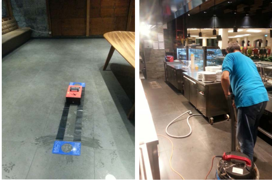
Şekil 5.1: İşletme zeminine antislip malzeme uygulanması
