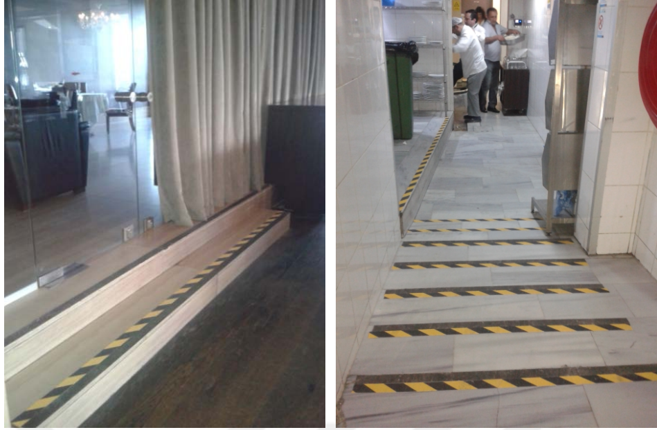
Şekil 5.3: Basamak ve rampalarda kaydırmaz bant uygulaması
