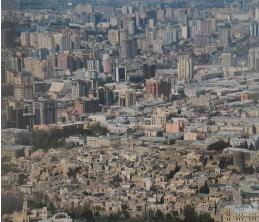
Şekil 3.14: Bakü kent merkezinde yeni yapılar (Nağıyev ve Hüseyinov, 2013).
