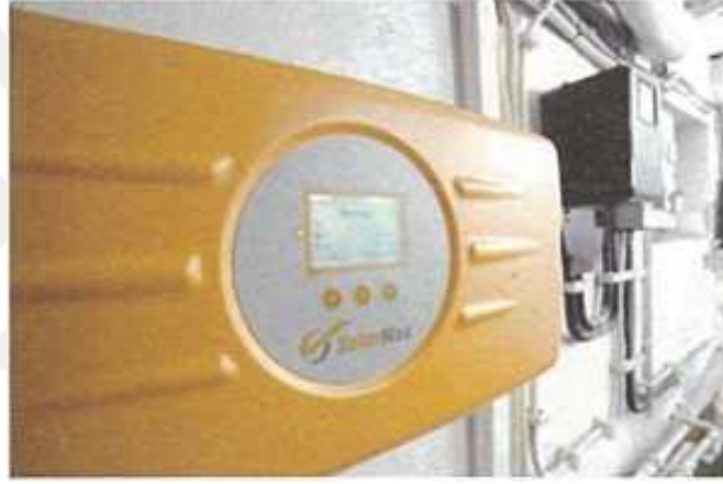
Şekil 3.9: Evirici için genelde en uygun kurulum yeri bodrumdur
