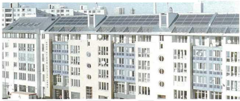
Şekil 3.7: Berlin'de modül eviricilerine sahip ön cepheye entegre FV tesisi
