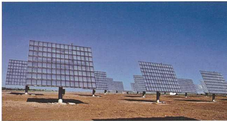
Şekil 1.22: İspanya'da, odaklayıcı FV hücreli, 500 kW kapasiteli santral [Concentrix]
