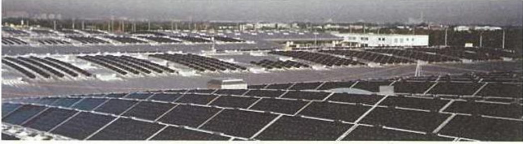
Şekil 3.2: Münih fuar binasının 1 MW FV tesisi [Siemens]
