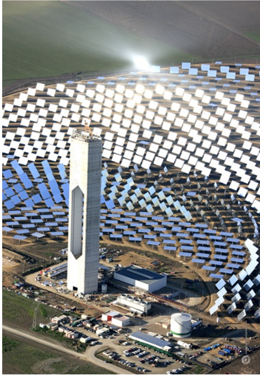
Şekil 40. Merkezi Alıcılı Güneş Isıl Elektrik Santrali [28]
