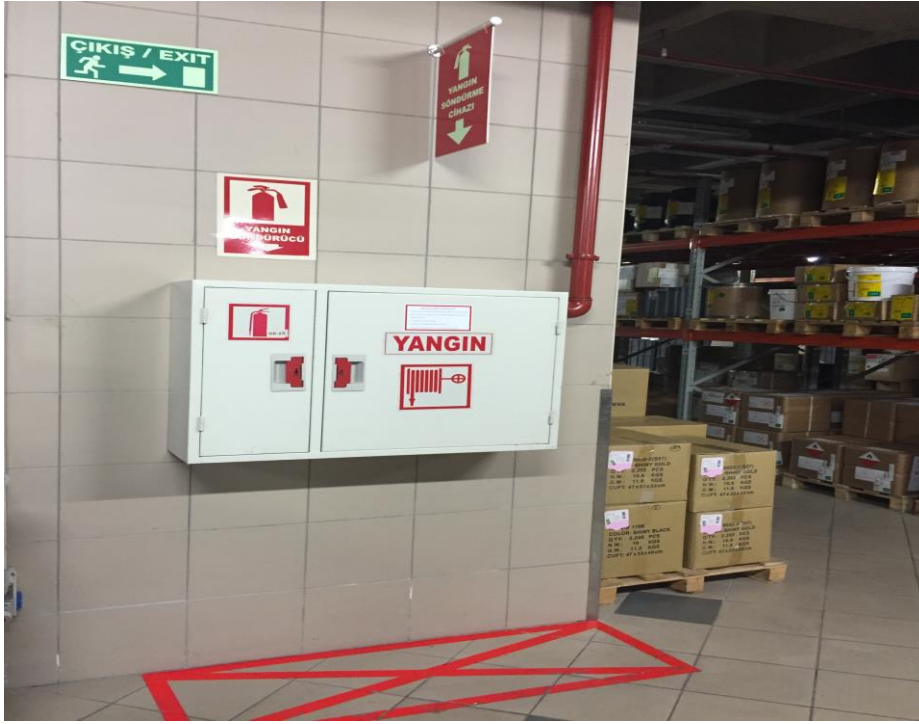
Şekil 5.9: Yangın dolapları
