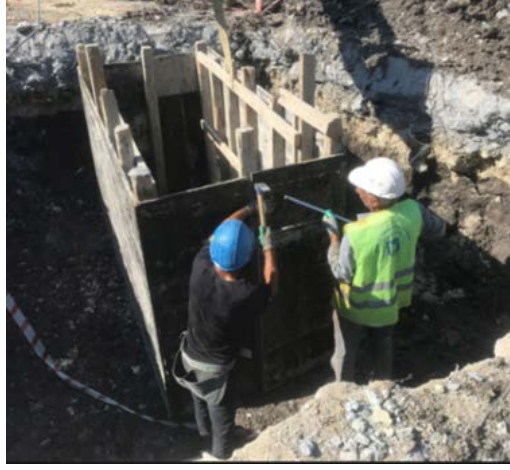
Şekil 12. Dış kalıp çakılması
