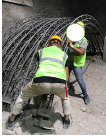
Şekil 26. Montaj yapılması için iksa taşınması
