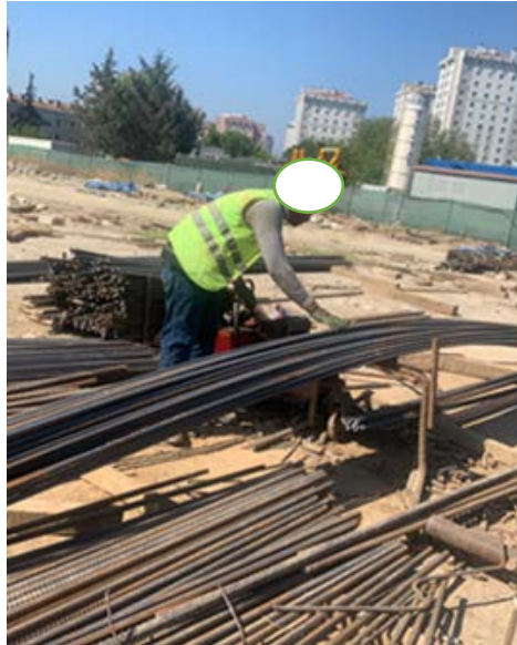
Şekil 15. Uzun demirlerin kesilmesi
