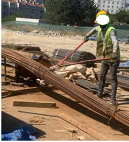
Şekil 14. Hareketli demir makası ile demirlerin bağ tellerinin kesilmesi
