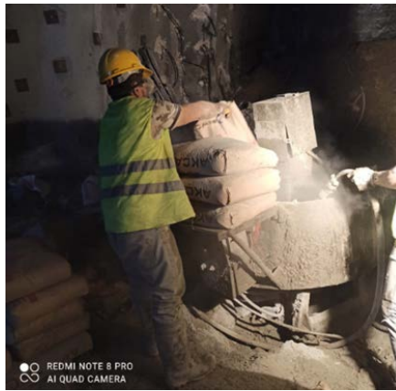
Şekil 28. Manuel çimento harcı hazırlanması
