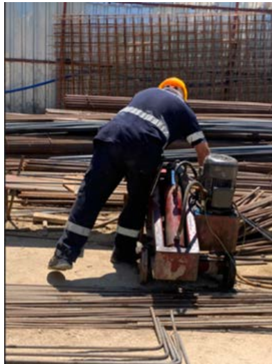
Şekil 21. 20 mm çaplı demirin bükülmesi
