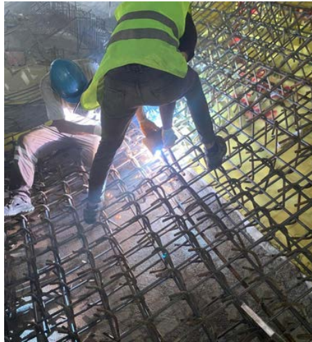
Şekil 19. İç taraftan kaynak yapımı
