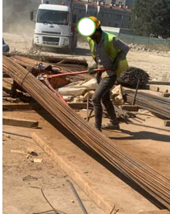
Şekil 13. Sabitlenmiş demir makası ile demirlerin bağ tellerinin kesilmesi
