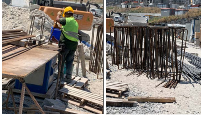
Şekil 24. Temel sehbası demiri bükülmesi
