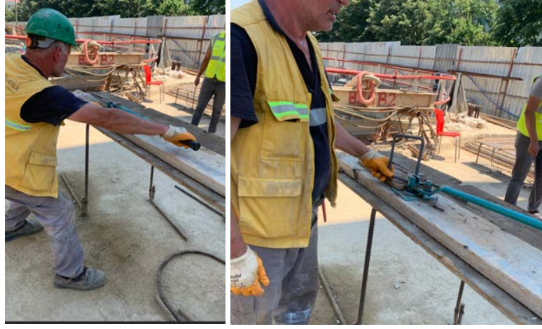
Şekil 22. 16 mm çaplı demirin bükülmesi
