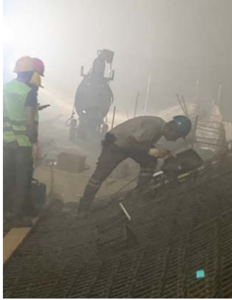
Şekil 18. Dış taraftan kaynak yapımı
