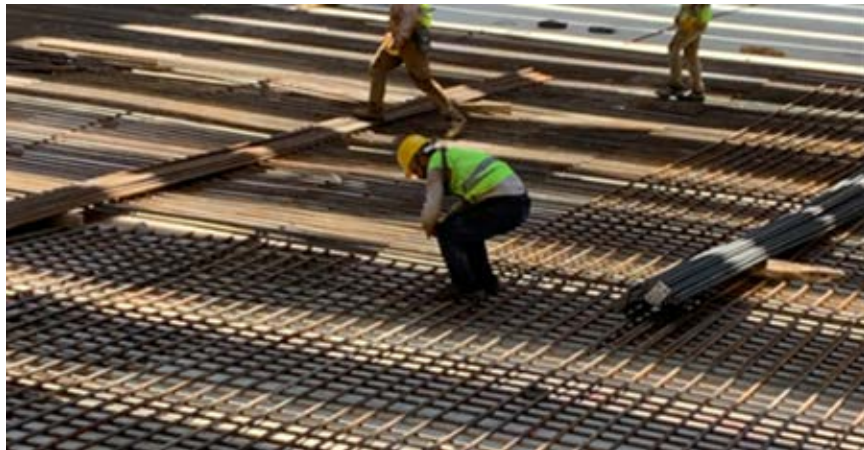
Şekil 17. İstasyon döşeme demirinin tellerle bağlanması- orta alan
