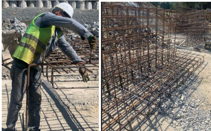
Şekil 25. Gidaj perdesi etriye demiri bağlanması
