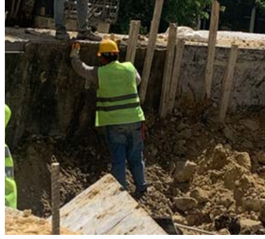
Şekil 11. İç kalıp çakılması
