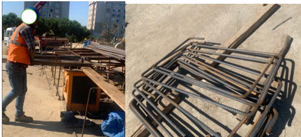
Şekil 23. Diyafram perde etriyemeri bükülmesi
