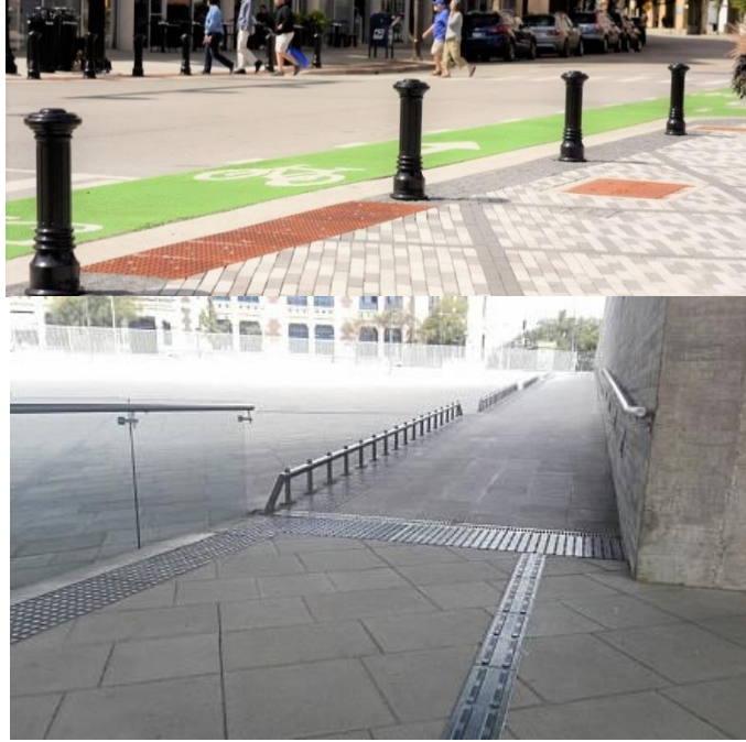
Şekil 79. Üst: Dökme demir hissedilebilir uyarı levhalarındaki ızgara modeli, caddedeki araç tehlikelerine karşı uyarır (Reliance Foundry, 2023) ; alt: Yol kenarı sınırlamasının önünde hissedilebilir yüzey kullanımı
