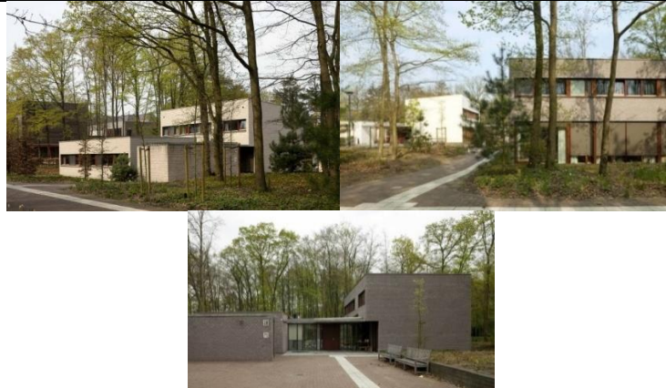
Şekil 22. Görme engelli evleri /70F architecture, Fotoğraf: Luuk Kramer
