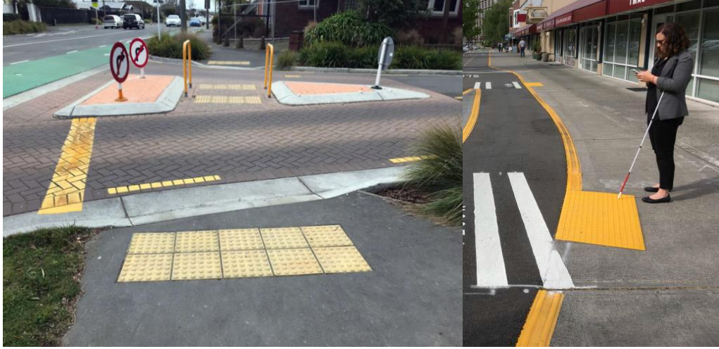
Şekil 46. Hissedilebilir uyarıcı yüzeyler, Guidance surfaces delineating bicycle and pedestrian areas and crossings in Seattle
