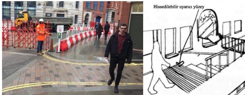
Şekil 19. Sol: Akordeon kapılar, daha fazla görsel uyarı görevi gören, yanıp sönen bir işaret ve tabela ile desteklenmiş çalışma alanı (Mace Group, 2023); sağ: beklenmeyen zemin değişimlerinin ikazı
