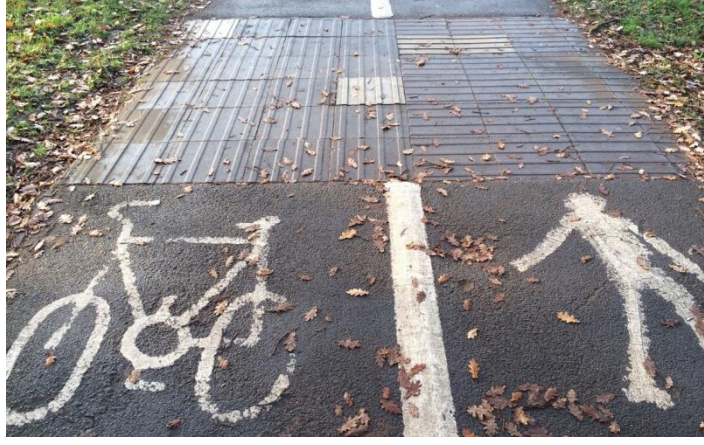
Şekil 60. Hem enine hem de boyuna şeritlerin bir arada kullanımı, genellikle iki tür yolun birlikte döşendiği durumlarda kullanılır. Bu yollardan biri yayalar için, diğer taraf ise örneğin bisikletler için olacaktır
