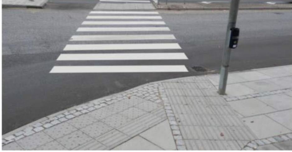
Şekil 50. Danimarka, Viborg'da sinyalize bir kavşakta örnek yönlendirme ve uyarı yüzeyleri. Yönlendirme yüzeyinin sol tarafındaki küçük finişer çizgisi standart değildir, Danimarka Yol Müdürlüğü (2017)
