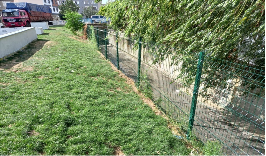
Şekil 9. İkitelli Mahallesi - Dere Yatağı
