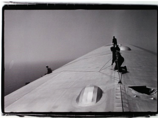
Resim 6: Alfred Eisenstaedt, Atlantik Üzerindeki Uçuş Sırasında Graf Zeppelin Gövdesinin Onarımı, 1934
