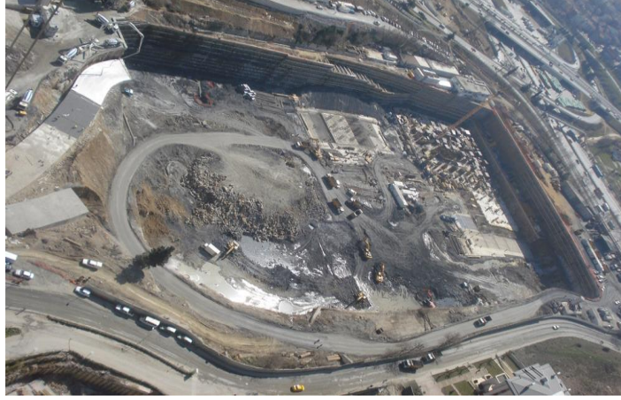
Şekil 5.41 : Akasya Acıbadem arazisi inşaat görüntüsü
