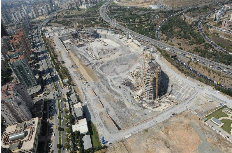
Şekil 5.63 : Metropol İstanbul arazisi inşaat görüntüsü
