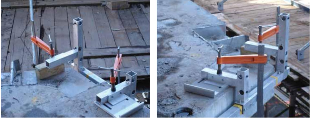
Şekil 5.14: IAC Binası Montaj Yöntemi [51]
