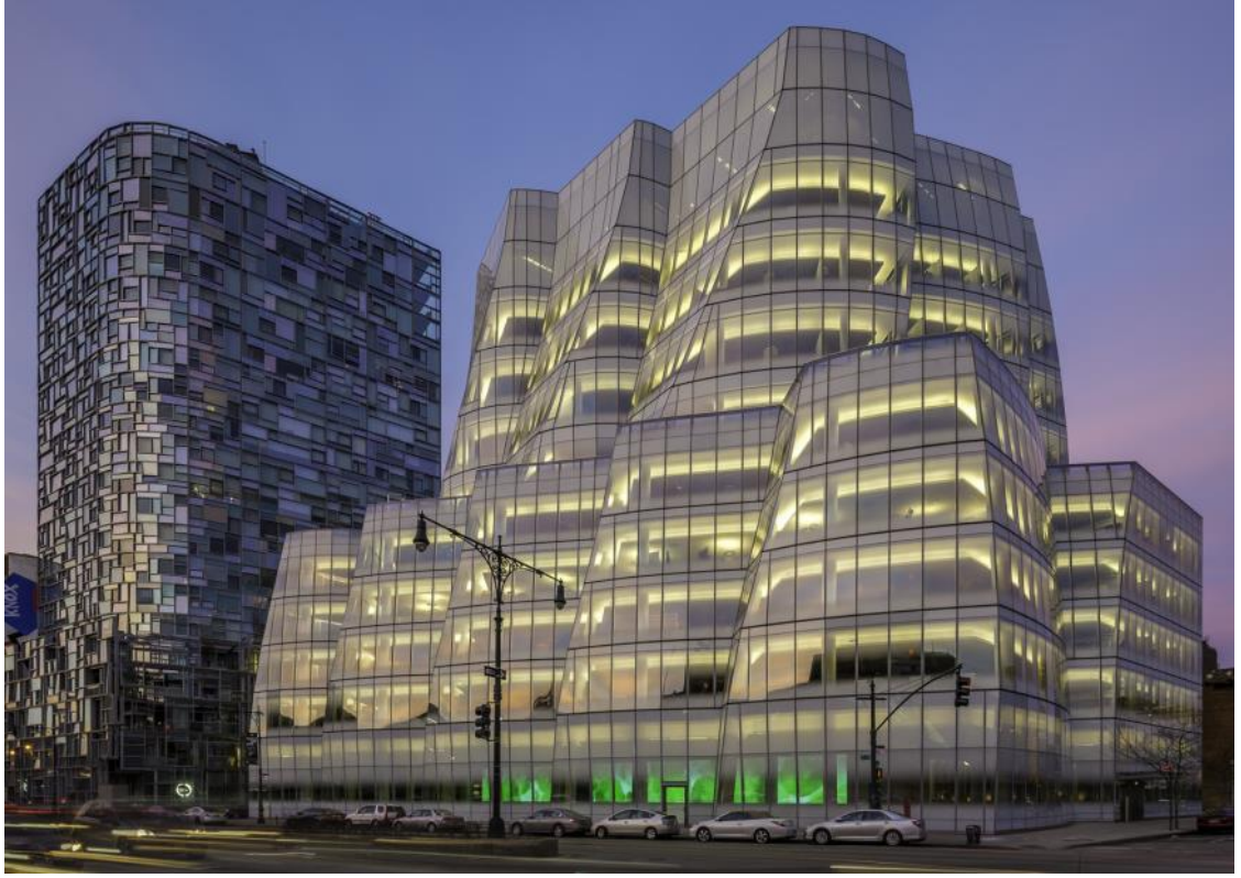
Şekil 5.8: IAC Ana Merkez Binası [43]
