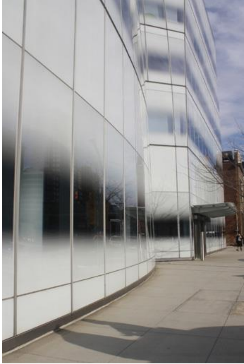
Şekil 5.12: IAC Binası Cam Yüzey Görünüşü [50]
