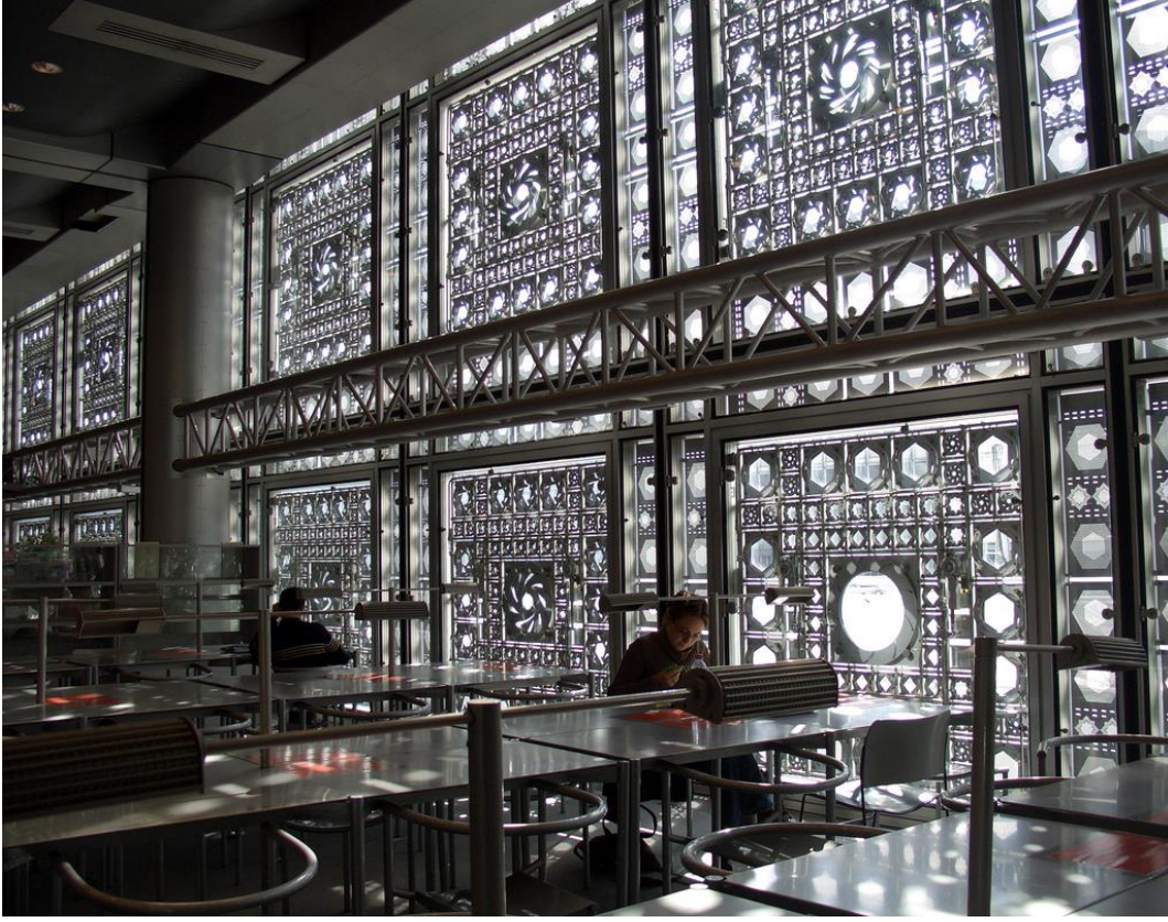
Şekil 5.5: Dış Etkilere Uyum Sağlayarak Form Değiştiren Cephe Lensleri Açıklıklarının İç Mekandaki Etkileri [39]
