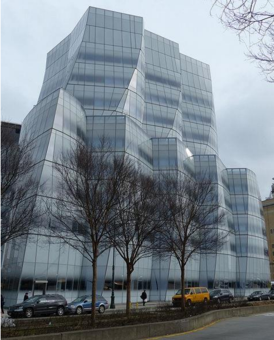
Şekil 5.13: IAC Binası Yan Cephe
