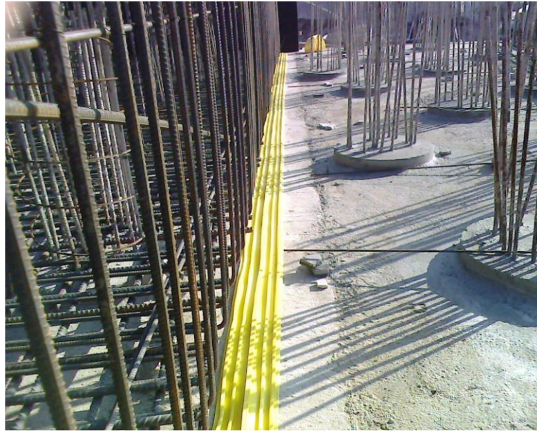
Şekil 29. Pvc su tutucu bant
