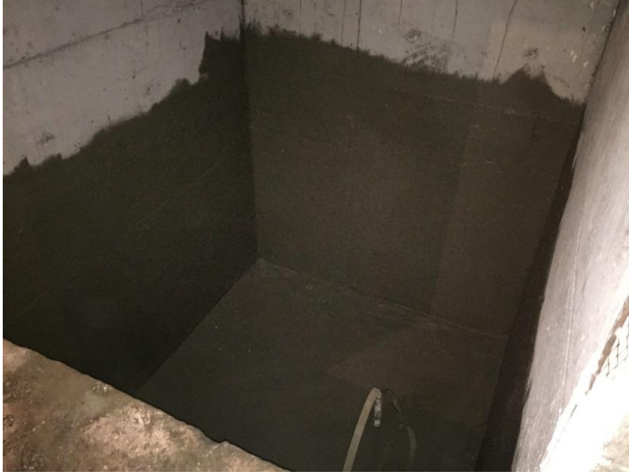
Şekil 68: Asansör kuyusu kristalize sürme uygulaması
