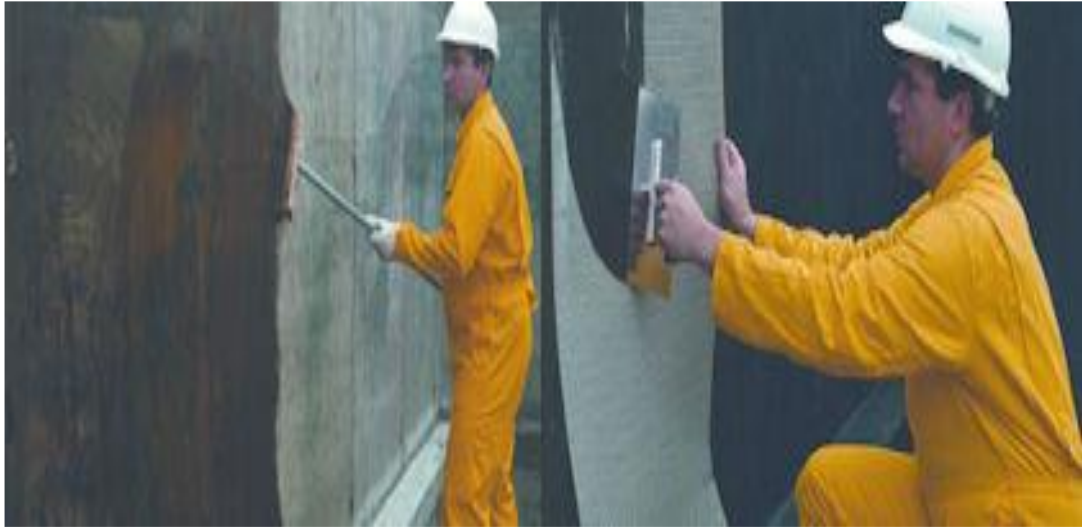
Şekil 25. Bitüm esaslı sürme tip su yalıtım malzemesi (kalın).
