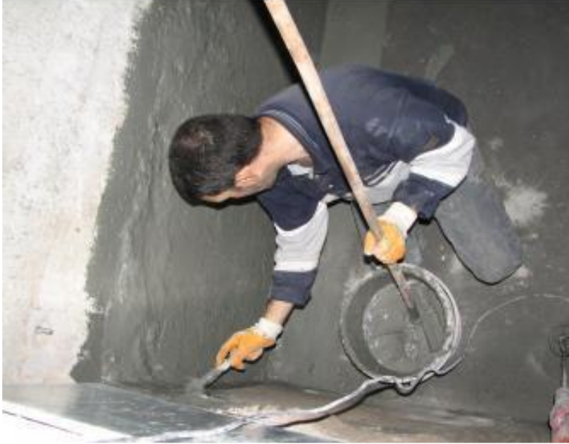
Şekil A.16: Asansör kuyusu yalıtım uygulaması
