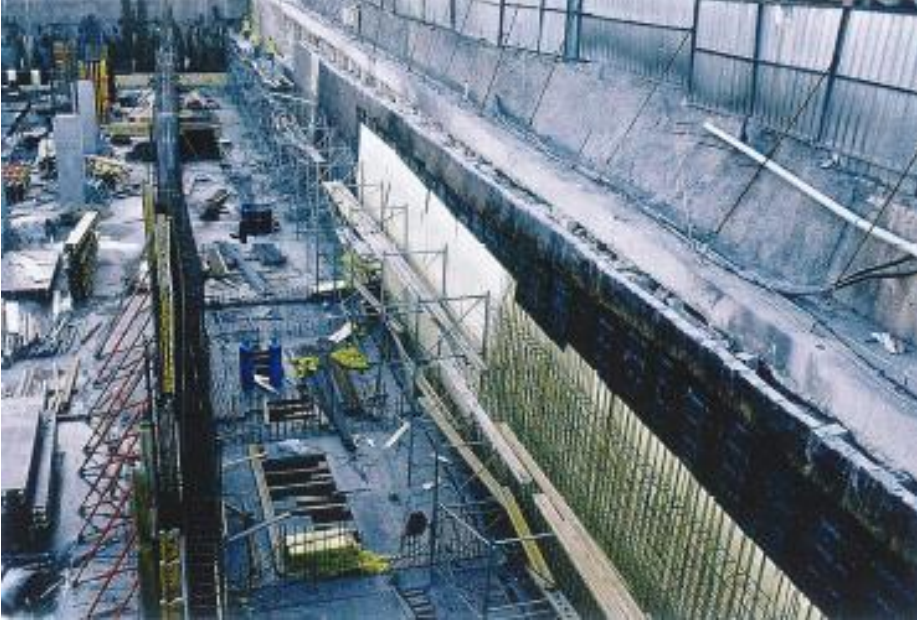
Şekil 47. İçten bohçalama, doğru uygulama.
