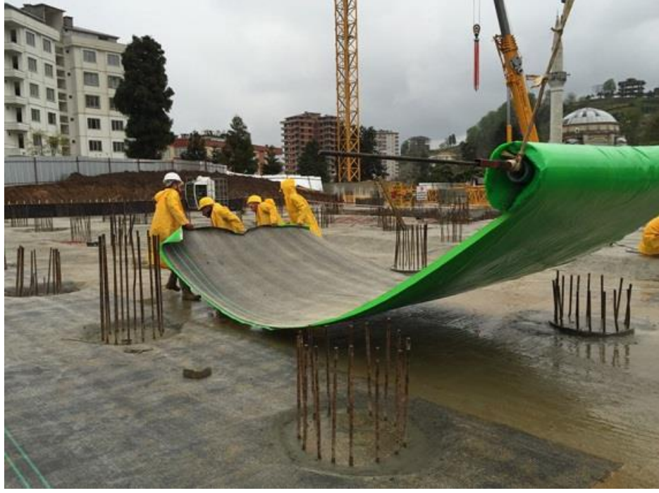
Şekil 28. Bentonit şilte uygulaması.
