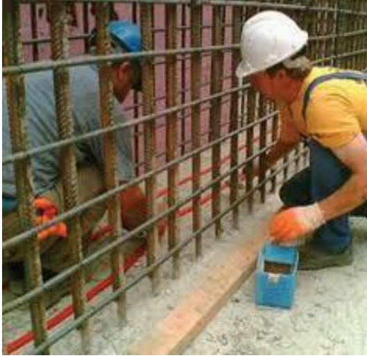
Şekil 30. Su ile şişen bant
