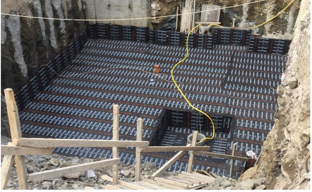
Şekil 64: Temel altı membran uygulaması
