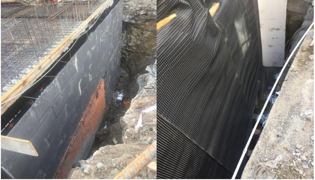
Şekil 65: Membran koruması
