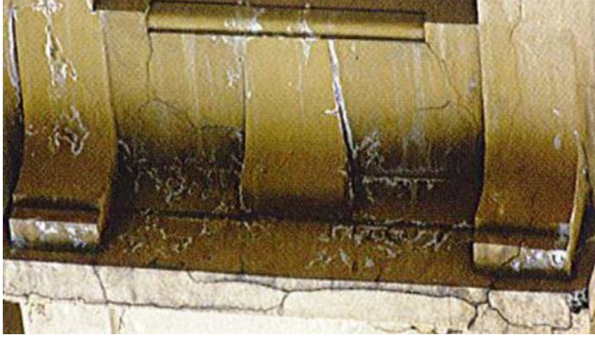
Şekil 13. Dış cephede çipekleme.
