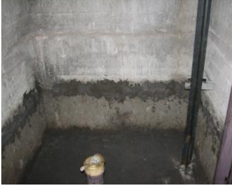
Şekil A.15: Asansör kuyusu derz ve pah uygulaması
