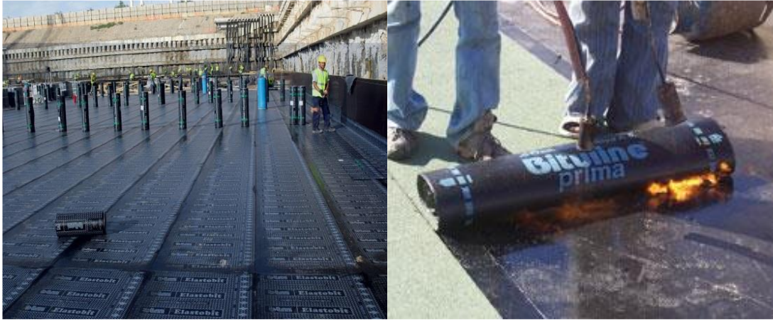
Şekil 26. Polimer bitümlü örtülerin uygulaması
