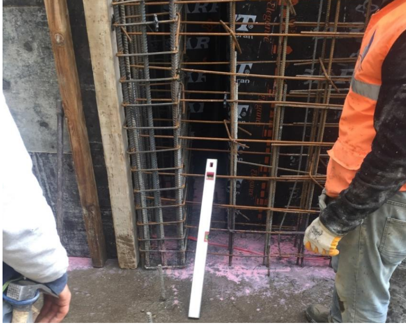
Şekil 66: Şişen bant ve aderans arttırıcı
