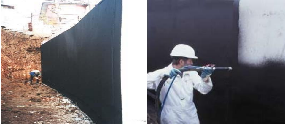
Şekil 23. Asfalt emülsiyon uygulamaları.
