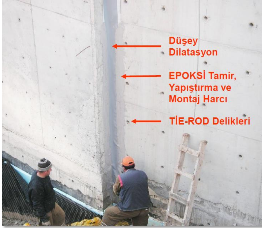
Şekil A.10: Düşey dilatasyon detayı
