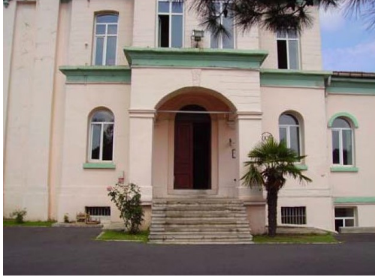
Şekil 4.54:Orhaniye Kışla Camii, Hünkâr dairesi girişi, güneybatı cephesi, 2008
