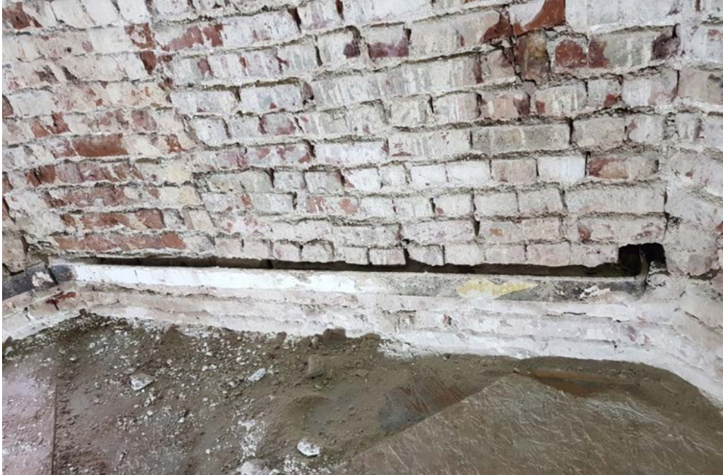
Şekil 5.56: Çıkmanın duvar sisteminin rijtliğini sağlamak için zemin kotunda uygulanan çift yönlü köşe demir gergi
