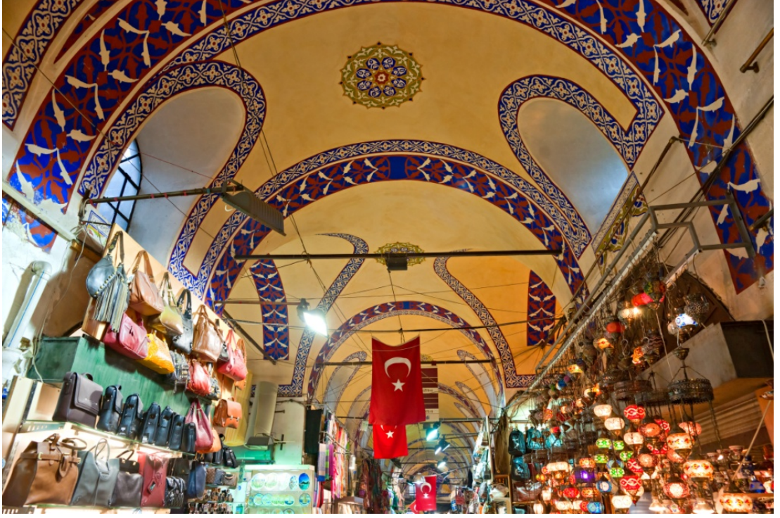
Şekil 3.44:Kapalıçarşı tonozlarının açıklık gergileri
