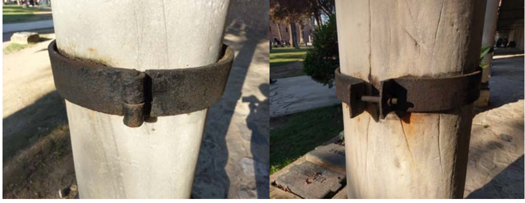
Şekil 3.20: Topkapı Sarayı, Matbah-ı Amire sütun bileziği (halka kelepçe), 2019
