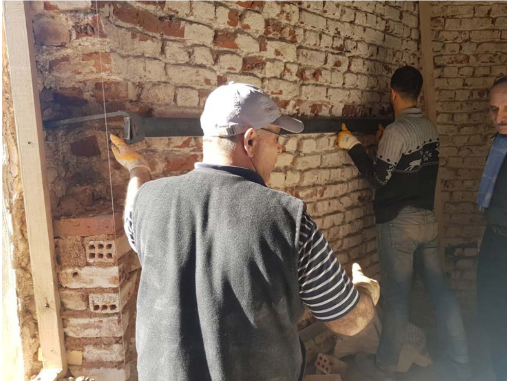
Şekil 5.60: Konservasyonu yapılan mahfil katının duvar gergilerinin yerine yerleştirilmesi
