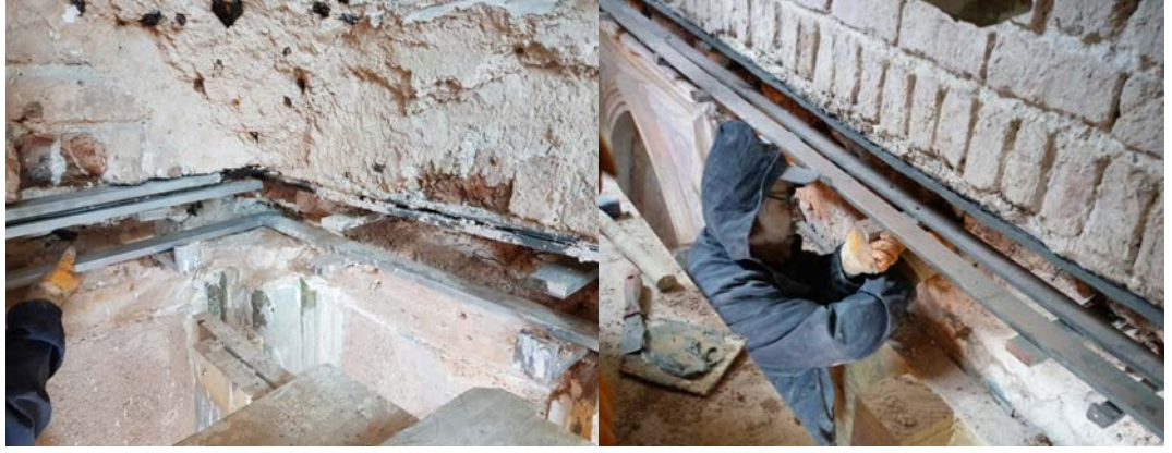
Şekil 5.37: Silme kuşağı altında ortaya çıkarılan demir gergilerin konservasyon sonrası yerine yerleştirilmeleri
