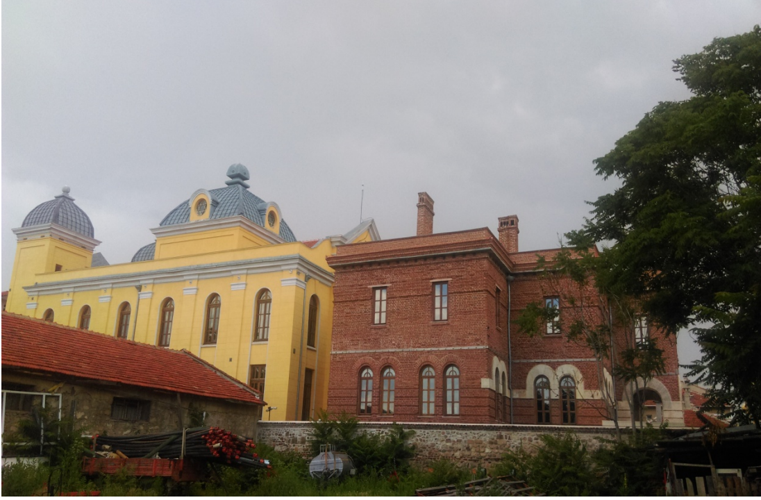
Şekil 2.16: Edirne Büyük Sinegogu, taş örgü kâgir ana yapı ve tuğla örgü ek yapı
