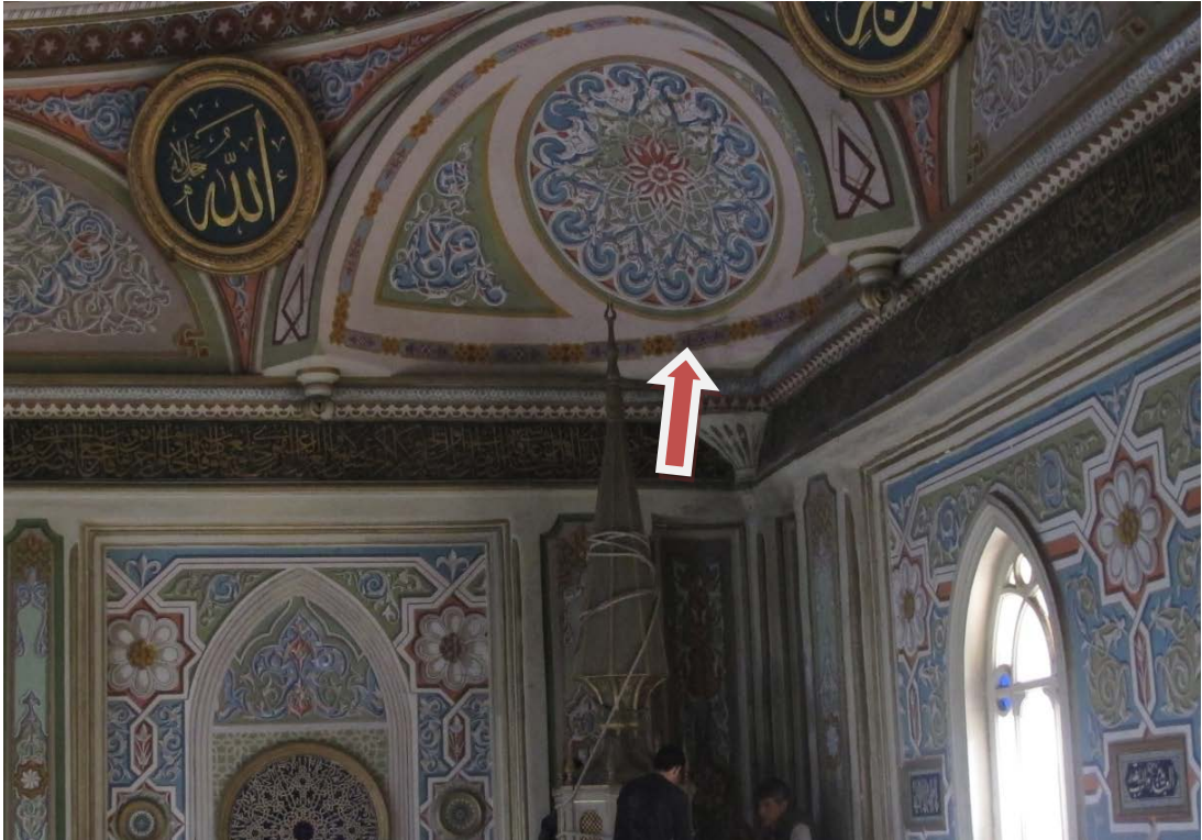
Şekil 5.10:Orhaniye Kışla Cami, köşe trompları, restorasyon öncesi 2014
