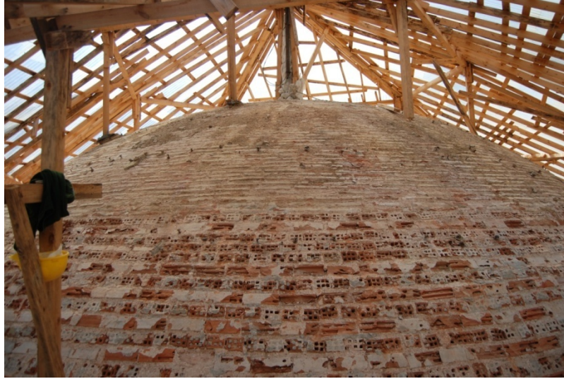
Şekil 4.51:Orhaniye Kışla Camii, ana kubbe, restorasyon sırasında, 2014
