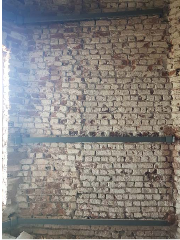
Şekil 5.58: Mahfıl katı çıkmasında yer alan duvar gergileri
