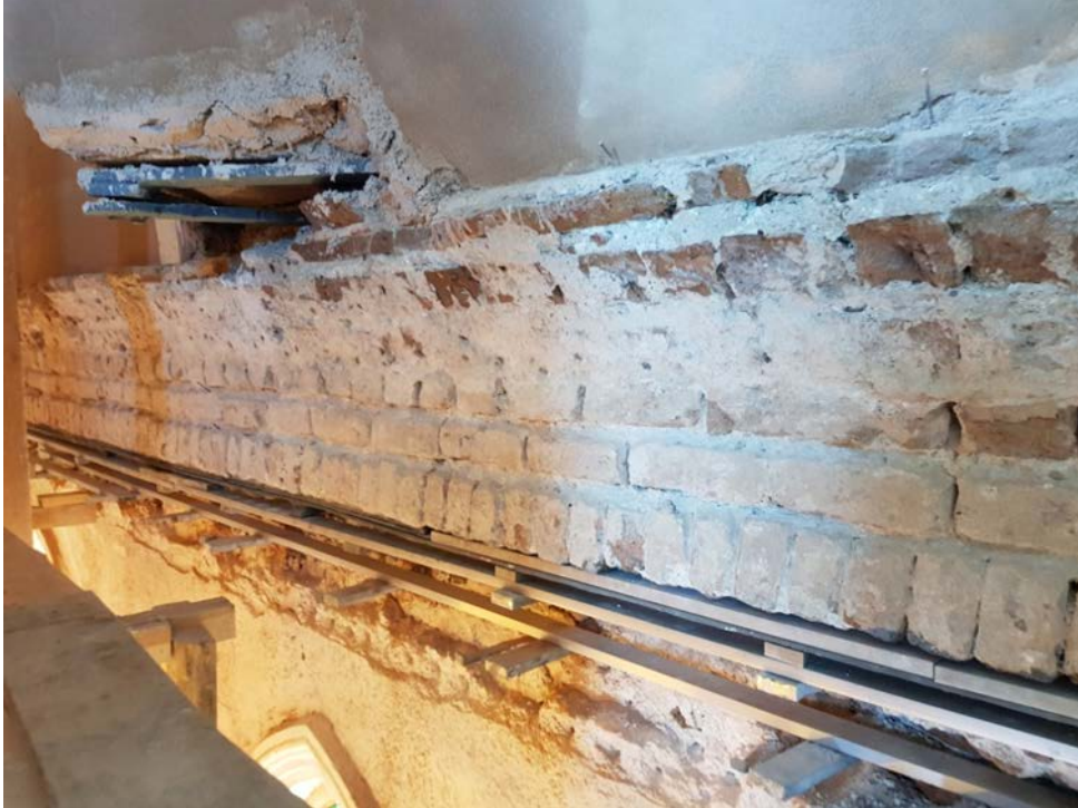
Şekil 5.9: Orhaniye Kışla Cami, taş blok altındaki demir lamaların konservasyonu, Taksim Yapı Mimarlık,2019
