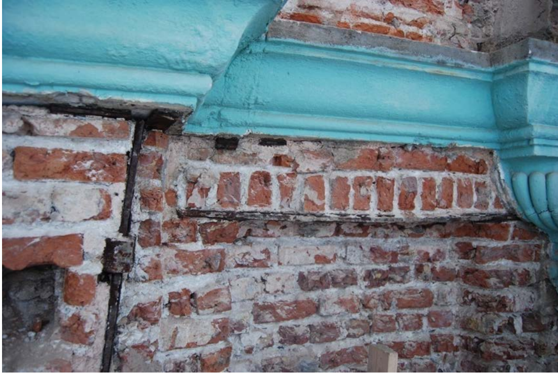
Şekil 5.40: Harim dış cephesinde üst kotta görülen kılıçla mesnetleme, 2014
