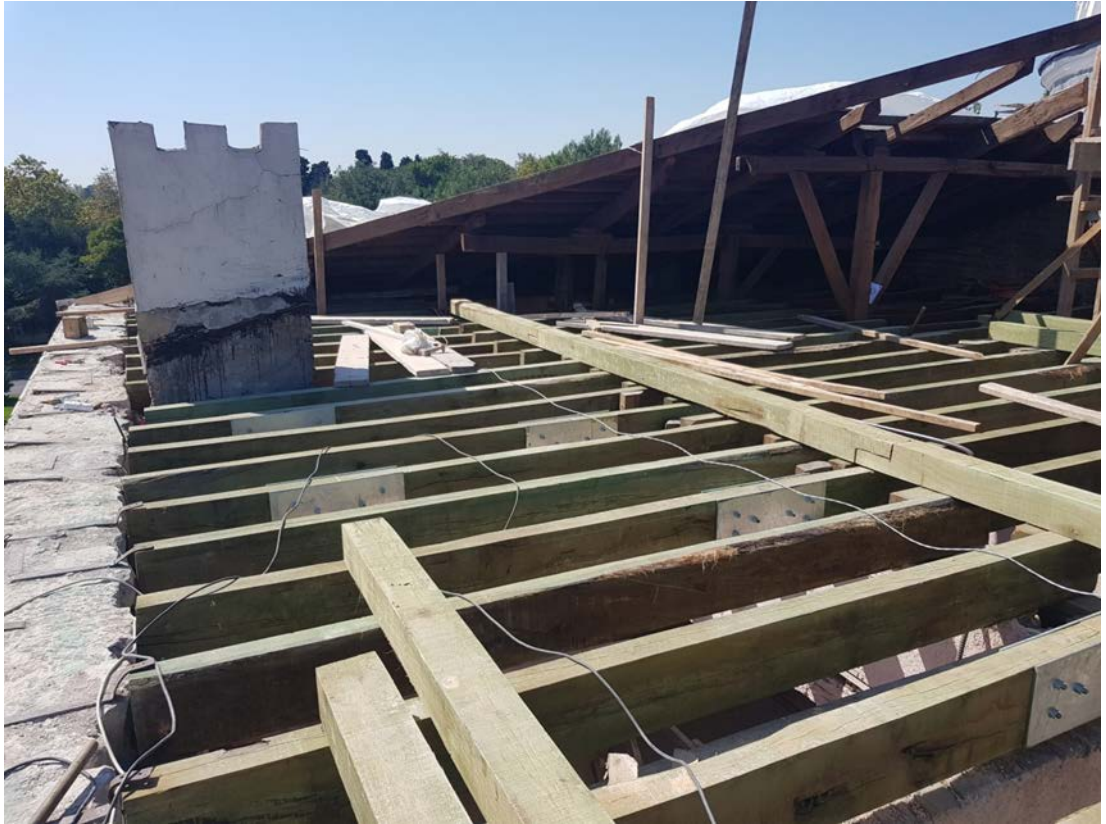
Şekil 5.88: Ahşap döşeme kirişleri restorasyon sırasında
