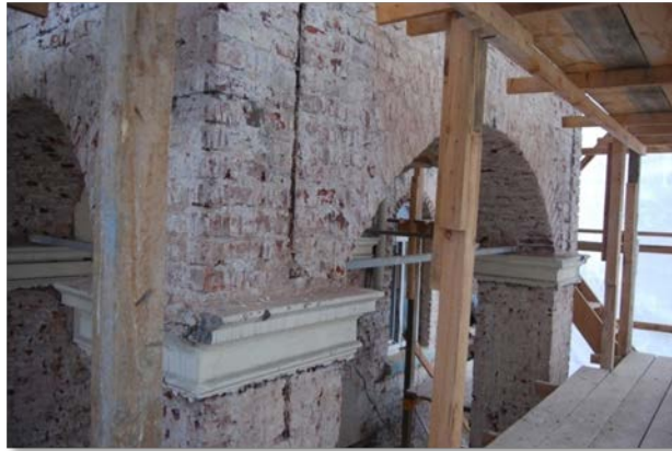
Şekil 4.48: Mahfil katının çıkmasının altında, zemin katta yer alan kemerli giriş bölümü raspa sonrası, güneybatı cephesi, 2014
