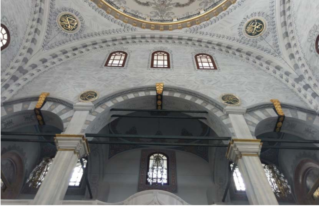
Şekil 3.28: Nusretiye Cami, kadınlar mahfili, iki kemer arası çift sıra gergi ve bir sütun bir duvar arası kemer, 2019
