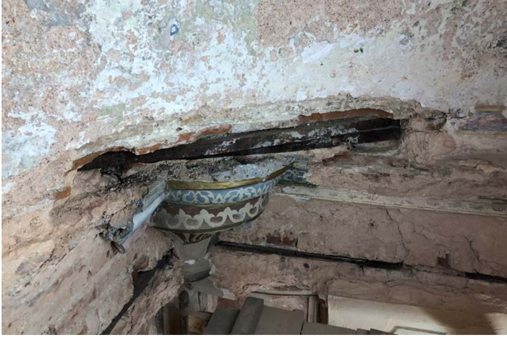
Şekil 5.11:Orhaniye Kışla Cami, tromplarının altında raspa sonrası açığa çıkan metal elemanlar, 2017
