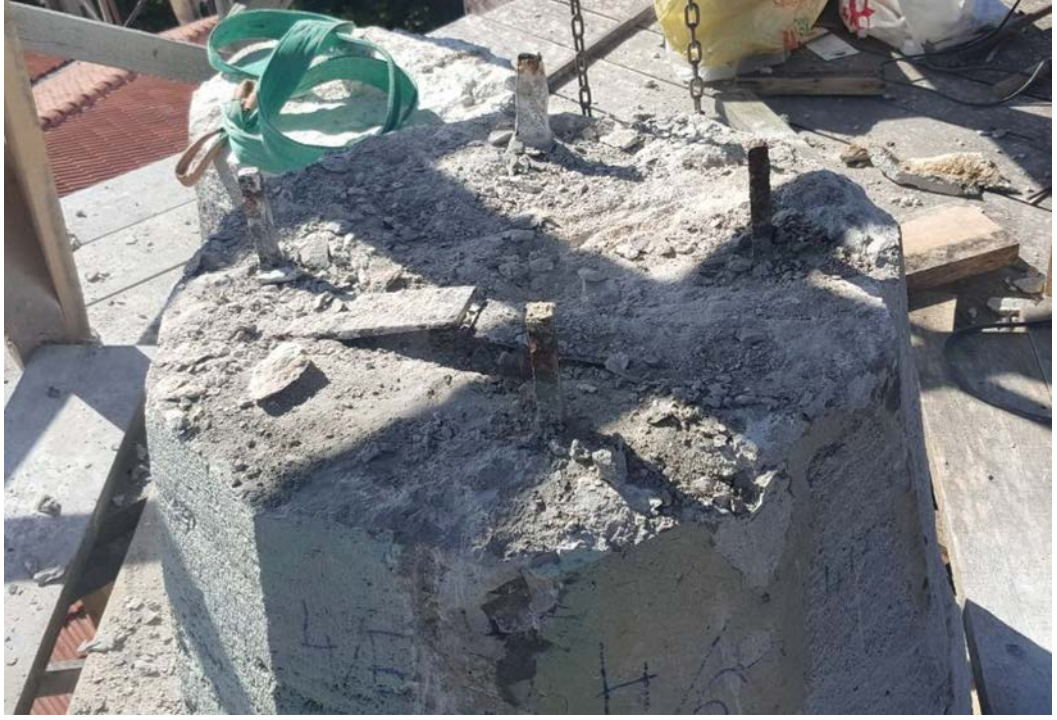
Şekil 5.94:Minare taşlarını birleştirmek için kullanılan zıvanalar (saplama)
