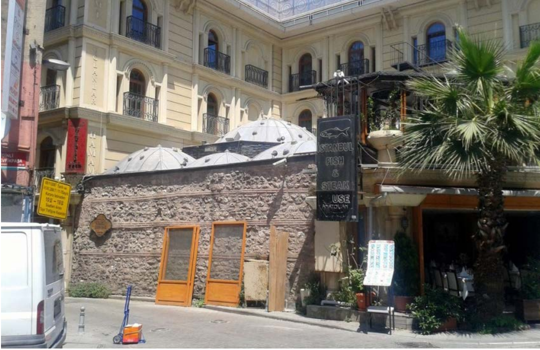
Şekil 4.10: Acemi oğlanlar Hamamı'nın bir bölümü, Vezneciler, 2016
