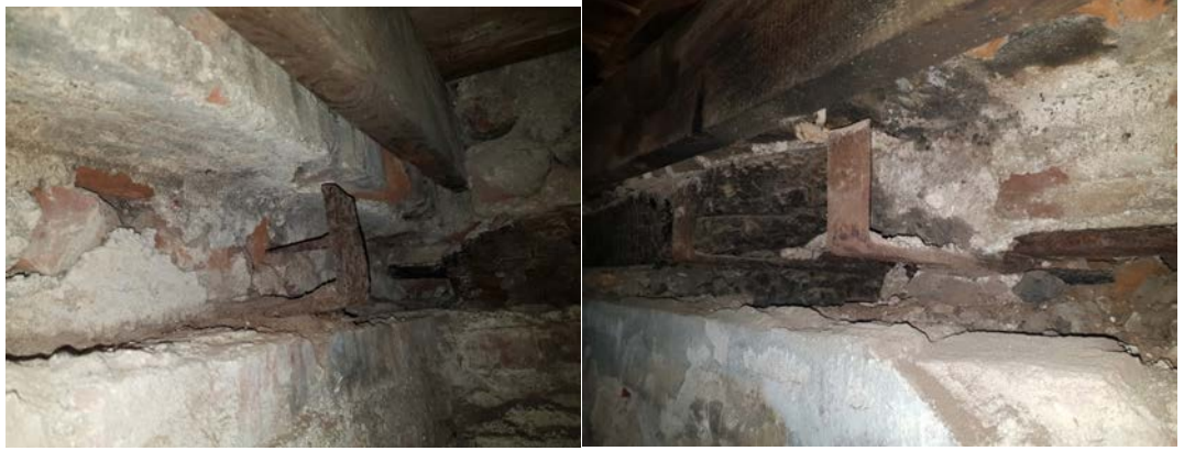
Şekil 5.83: U tipi kenetin kısa yüzeyinde mihla yapılan mesnetleme
