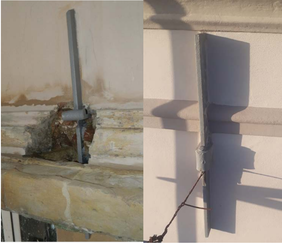
Şekil 5.46:Cephelerdeki metal elemanlara Mekânîk temizlik sonrası koruyucu antipas sürülmesi
