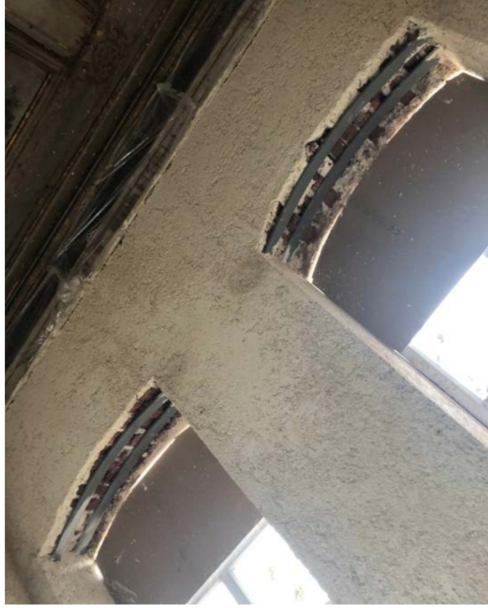
Şekil 5.73: Pencere kemer altı lentoları, konservasyon sonrası
