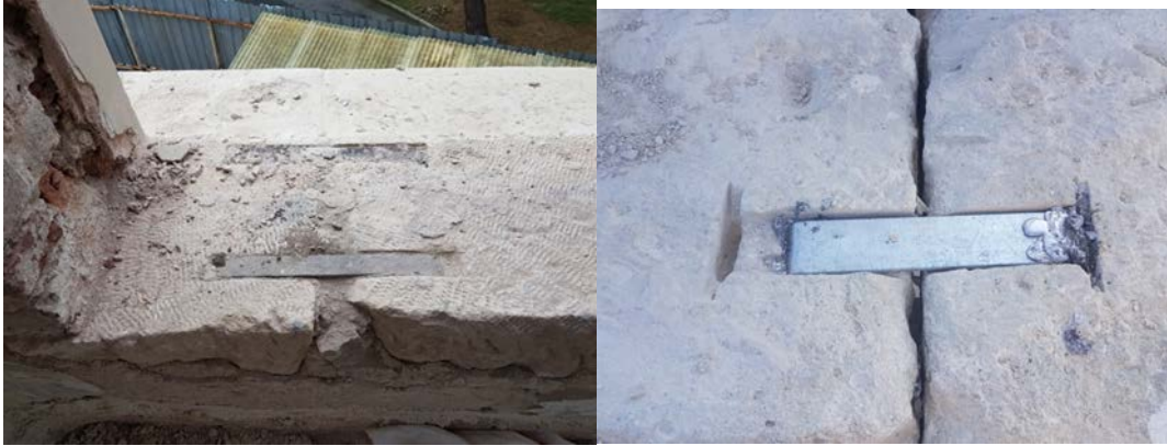
Şekil 5.76: Pencere sövesinde taşları birbirine bağlayan metal kenetler ve konservasyonu
