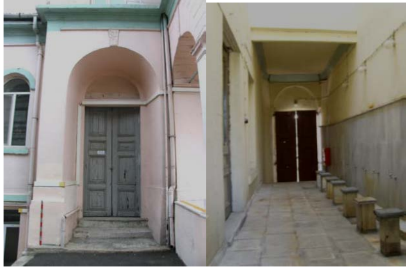
Şekil 4.46: Orhaniye Kışla Cami, güneybatı cephesi, abdesthane giriş kapısı ve abdesthane genel görünüm, 2008
