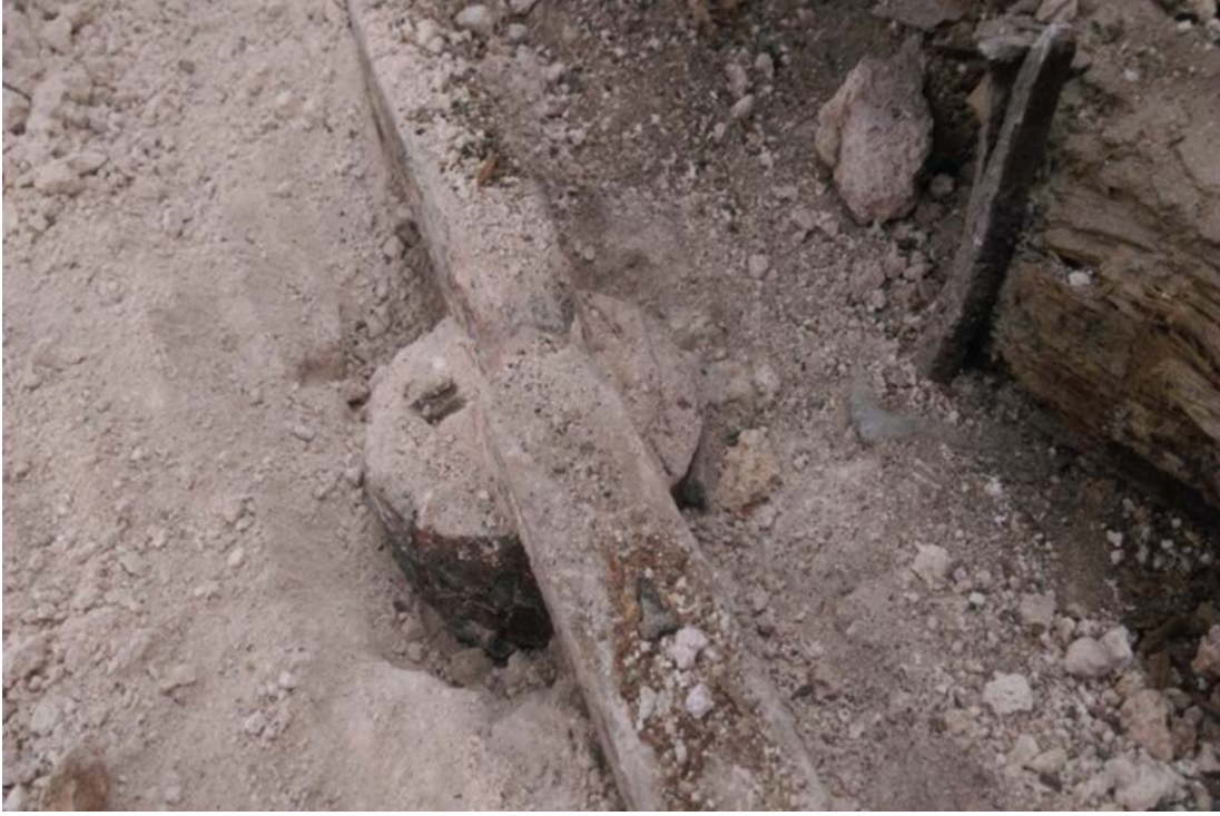
Şekil 3.38: Kariye Camii kubbe eteğinde simitli mesnetleme, 2015
