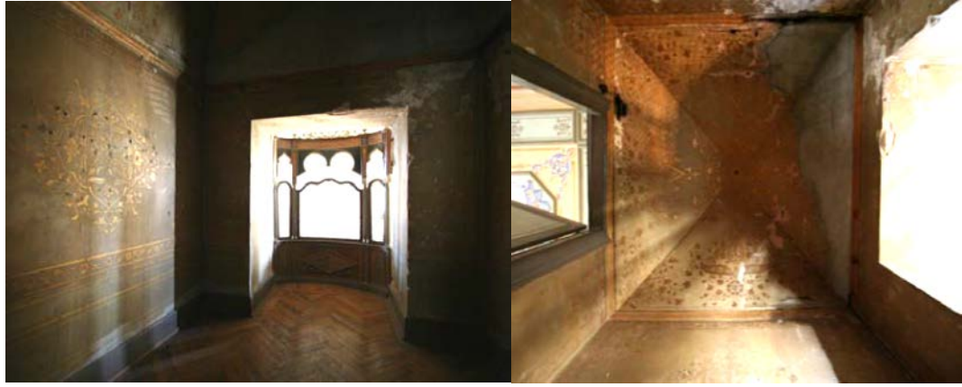
Şekil 4.73:1. Kata harime bakan cumbalı Hünkâr mahfili ve tavan bezemesi, 2008
