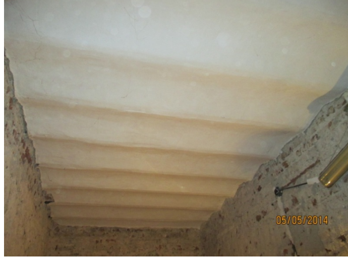
Şekil 5.78: Bodrum katta ıslak hacimlerin volta döşeme tavanı, raspa öncesi
