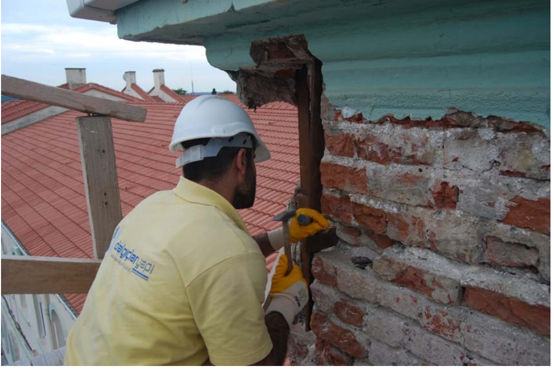
Şekil 5.44:Cephelerdeki yarı gizli kılıçlama mesnetin raspa sonrası açığa çıkarılması
