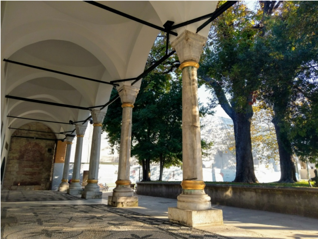
Şekil 3.29: Topkapı Sarayı, iki kemer arası çift sıra gergi ve bir sütun bir duvar arası kemer, 2019
