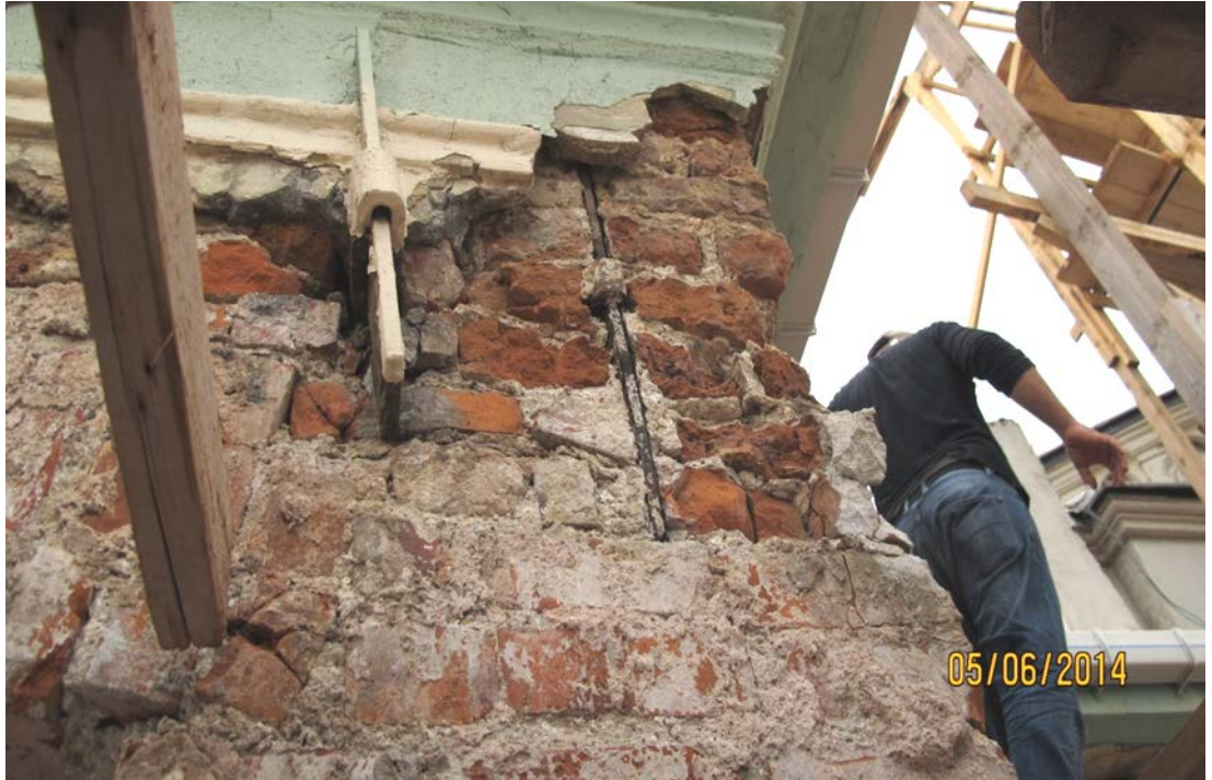
Şekil 5.42: Mahfil Katı dış cephedeki açık ve yarı gizli kılıç mesnetleme, 2014
