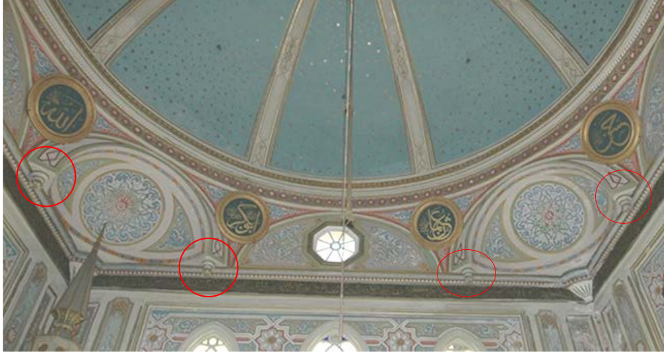
Şekil 5.1: Orhaniye Kışla Camii, köşe tromp düzenlemesi, 2015
