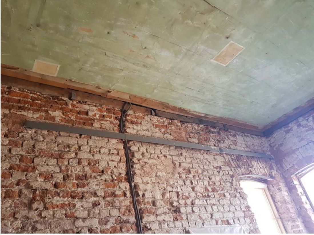
Şekil 5.63:Hünkârdairesi, konservasyonsonrasıduvar gergileri
