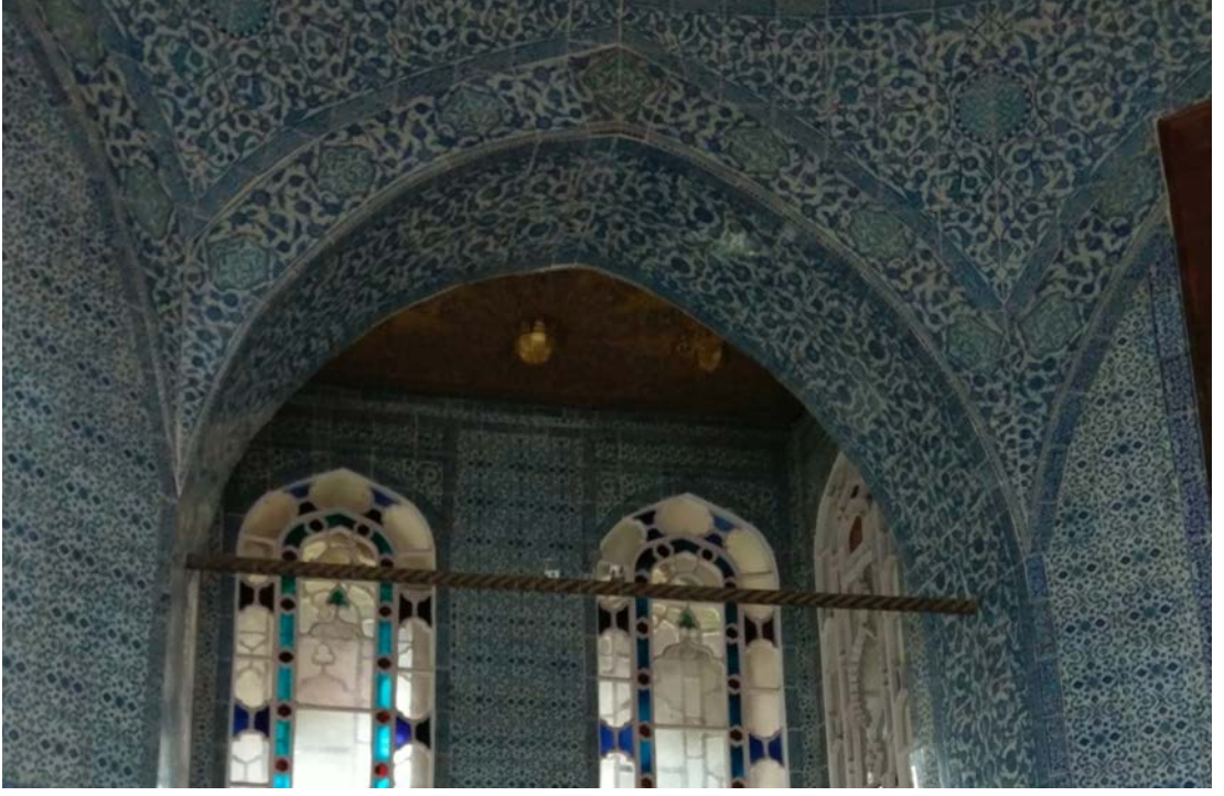
Şekil 3.30:Topkapı sarayı, Bağdat Köşkü eyvan kemerlerinin demir gergileri, 2019
