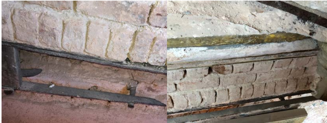
Şekil 5.28: Raspa sonrası açığa çıkartılan kuşaklama sistemi, 2017
