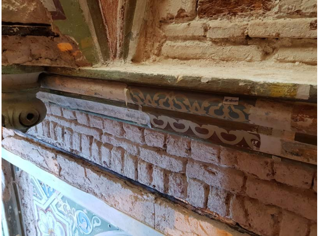
Şekil 5.34: Silme kuşağı altında ortaya çıkarılan demir kuşaklama, restorasyon sırasında, 2015
