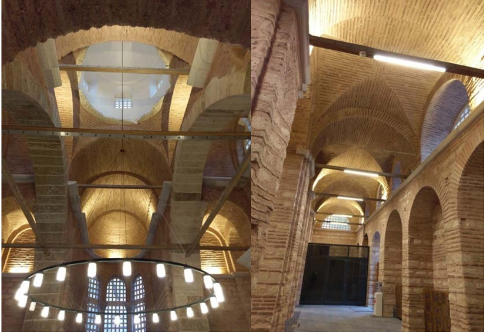
Şekil 3.31:Molla Fenari İsa Cami, kemer açıklık gergileri,2019
