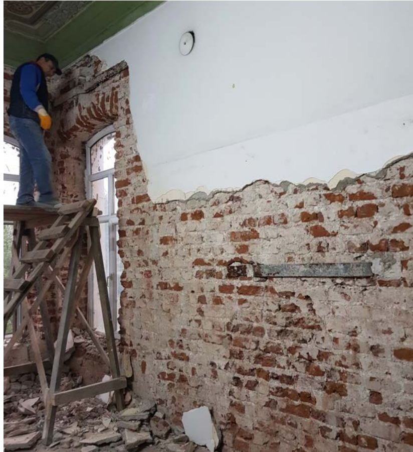
Şekil 5.54: Harim dairesinde, uygulanan parça duvar gergisi
