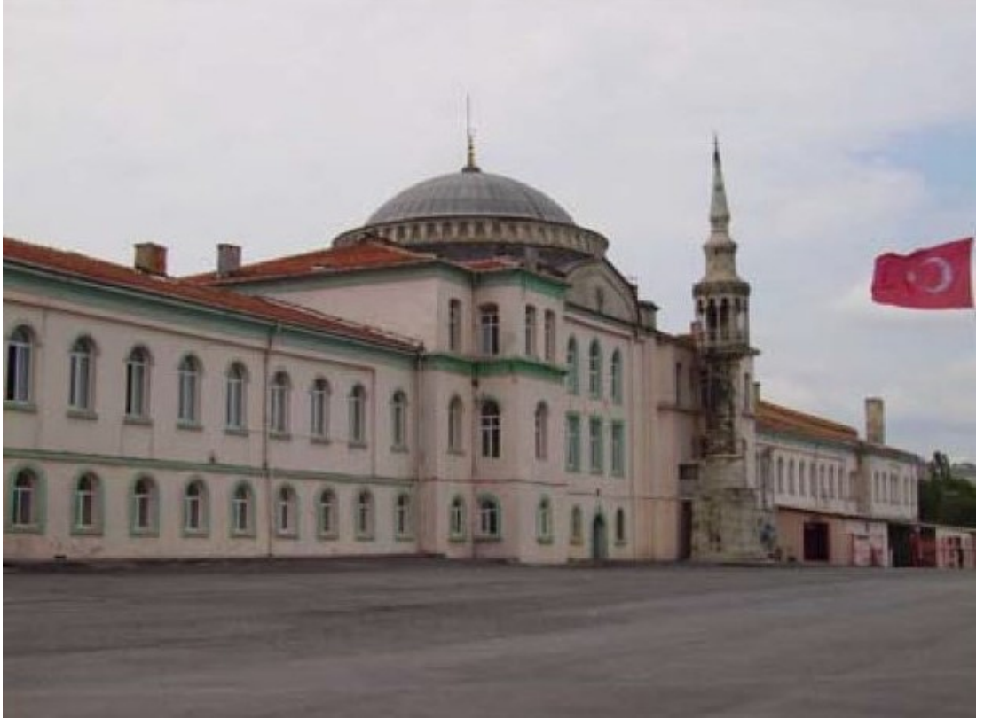
Şekil 4.57:Orhaniye Kışla Cami, kuzeydoğu cephesi genel görünüm, 2013
