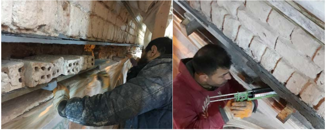
Şekil 5.38: Demir lama ve gergilerin yerlerine yerleştirilmesi
