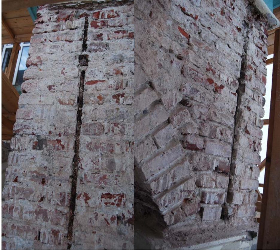
Şekil 5.65:Çıkma ayaklarında yer alan düşey duvar gergileri
