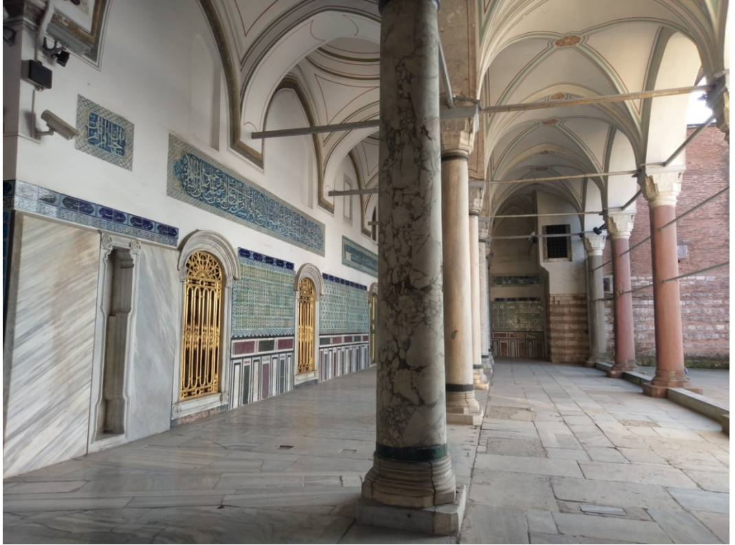
Şekil 3.35:Topkapı Sarayı kemer gergileri, 2019
