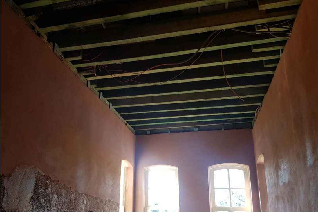
Şekil 5.84: Ahşap döşemelerin ve metal elemanların konservasyonu sonrası
