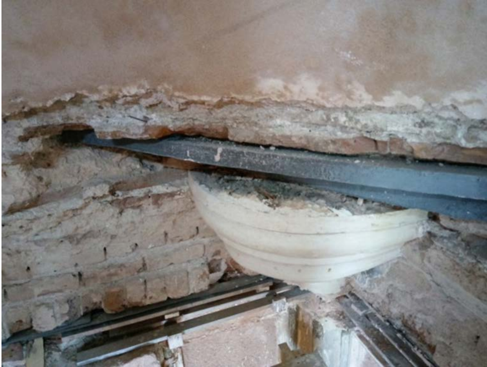
Şekil 5.20: Orhaniye Kışla Cami, tromp altı metal aksamı, konservasyon sonrası,2018
