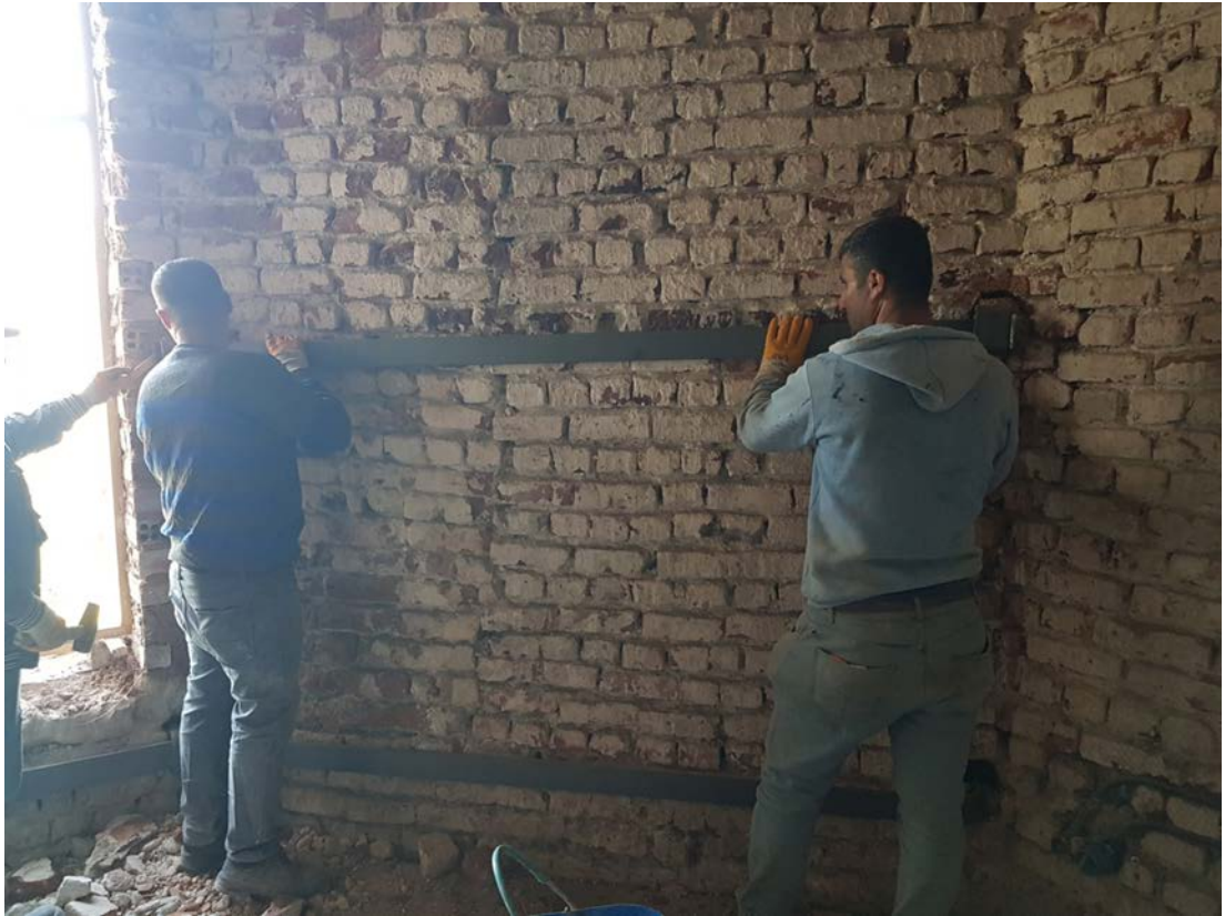
Şekil 5.62: Konservasyon sonrası duvar gergilei
