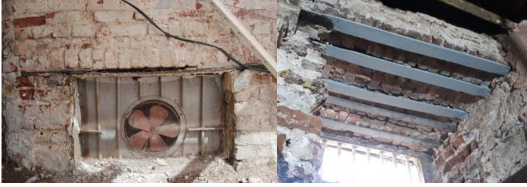
Şekil 5.75: Bodrum kat penceresi demir lentoları, konservasyon öncesi ve sonrası
