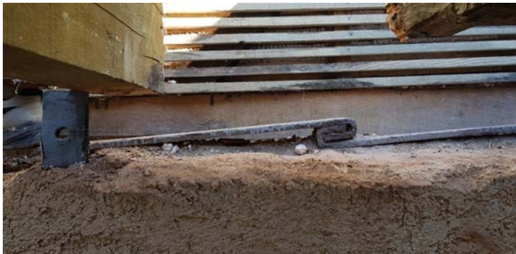
Şekil 5.86: Ahşap kirişlerin altında ortaya çıkan duvar gergisi
