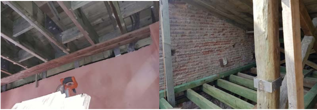
Şekil 5.85: Ahşap döşemelerin metal kenet, kelepçe ve paslanmaz levhalar ile güçlendirilmesi
