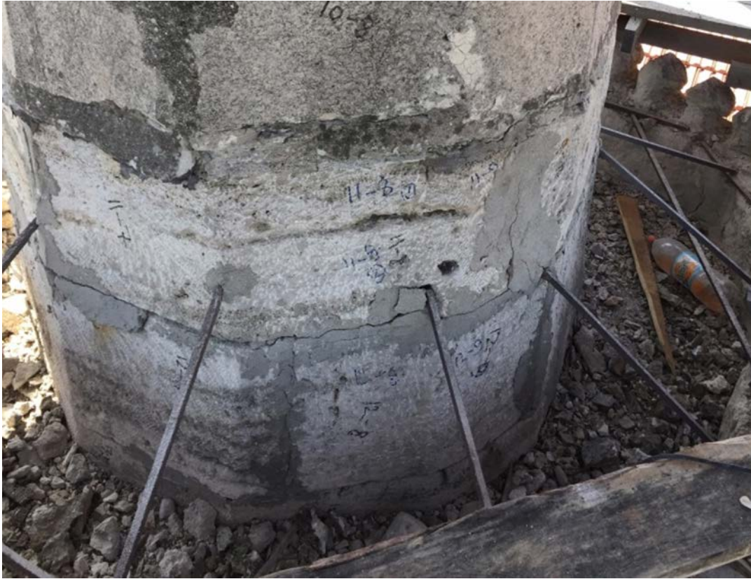
Şekil 5.93:Şerefenin köşk balkonun üzerinde bulunan demir çubuklarla yapılan ikinci bir çemberleme sistemi
