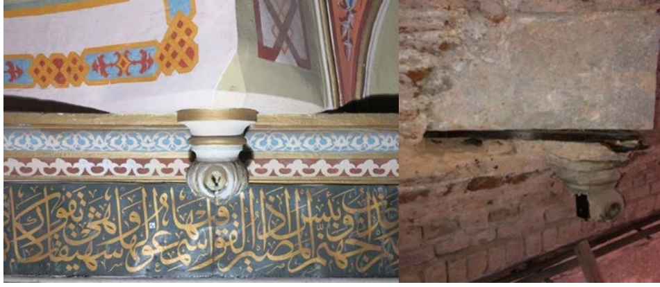
Şekil 5.2:Orhaniye Kışla Cami, harim tromp kemerlerinin oturduğu taş ve altındaki sarkıt, raspa öncesi ve sonrası, 2014-2018
