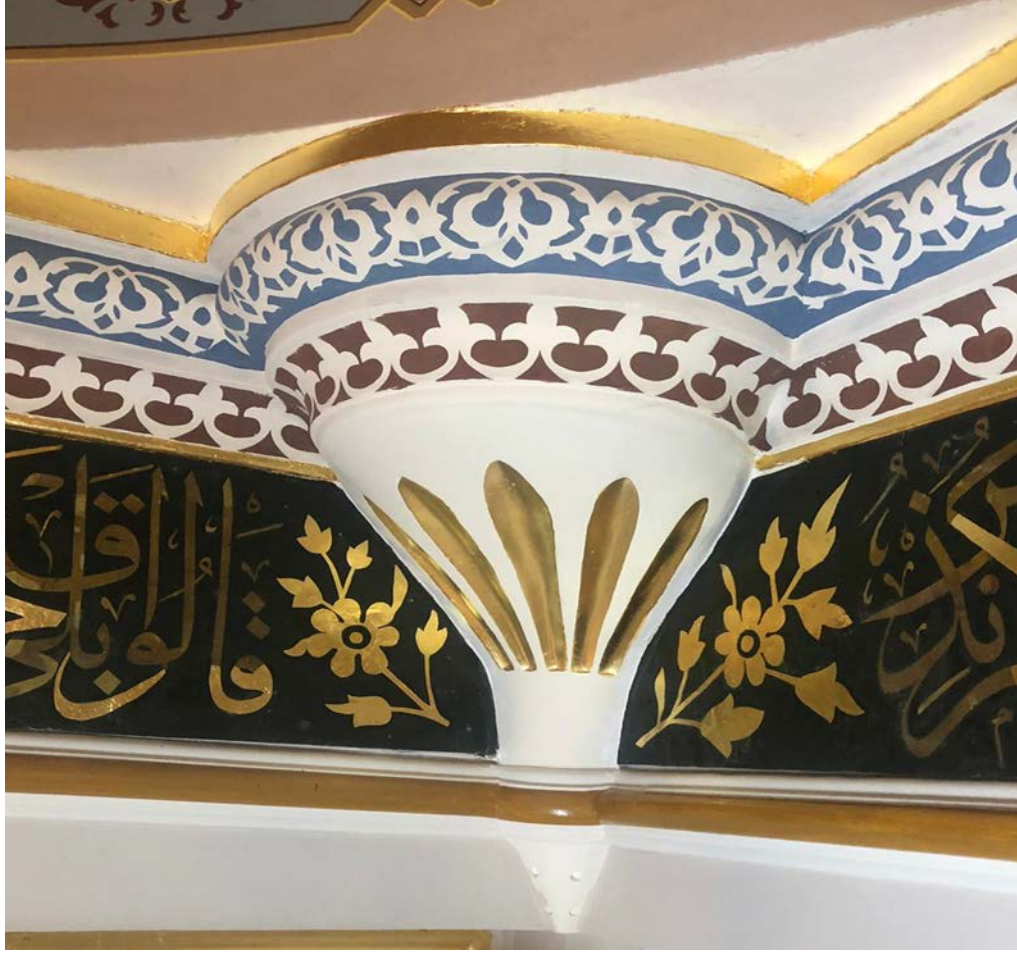
Şekil 5.21:Orhaniye Kışla Cami, tromp altı köşe sarkıtı, restorasyon sonrası, 2019
