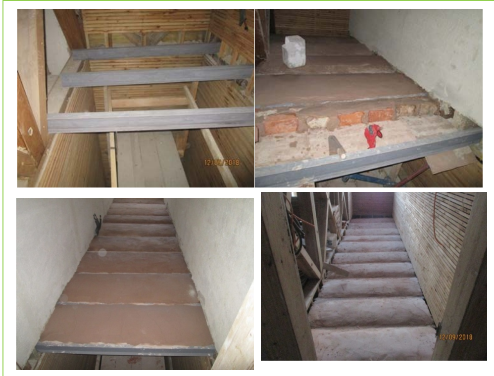
Şekil 3.50: Volta döşeme yapılması, (Kadioğlu-2018)
