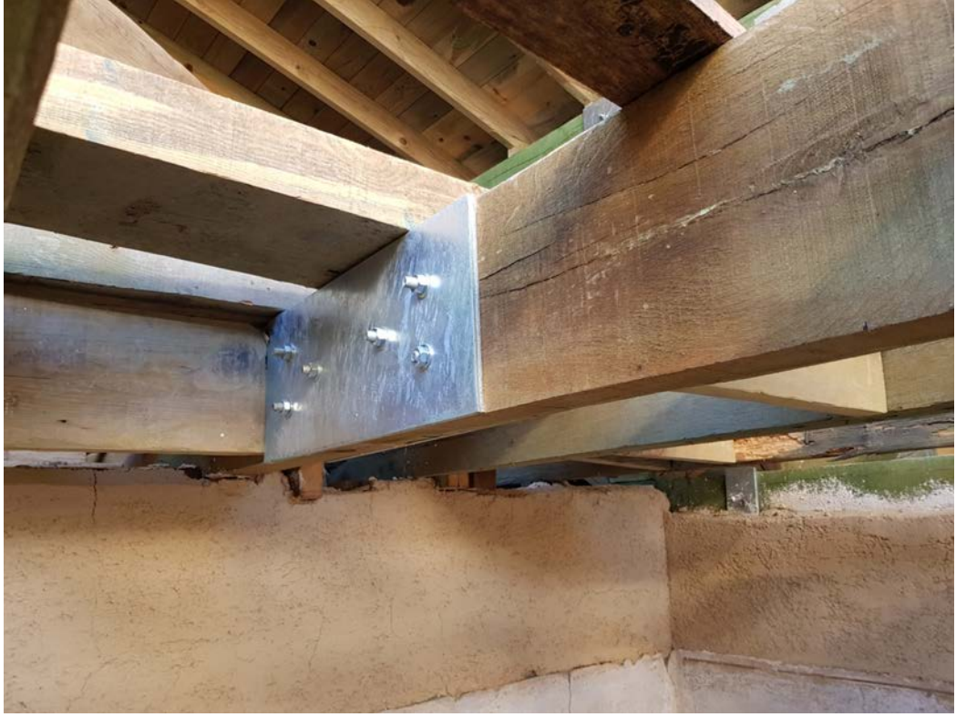
Şekil 5.87: Ahşap döşemelerin paslanmaz levhalar ile güçlendirilmesi
