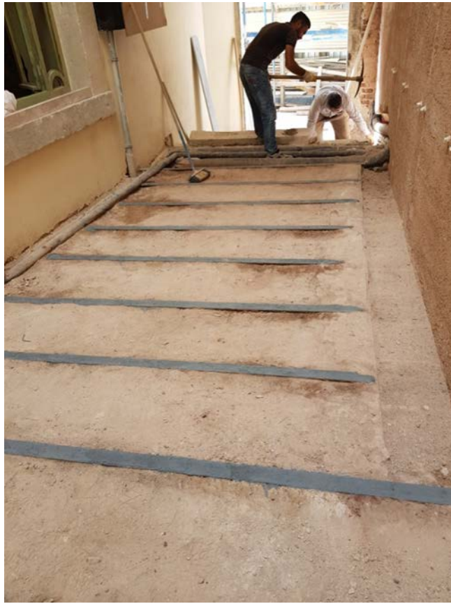
Şekil 5.81: Volta döşeme; onarım ve konservasyon sırasında
