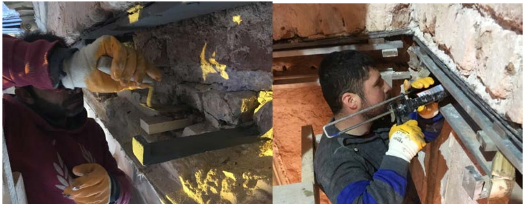
Şekil 5.39: Harimin duvar gergileri ve demir lamaların yerleştirilmesi,restorasyon sırasında
