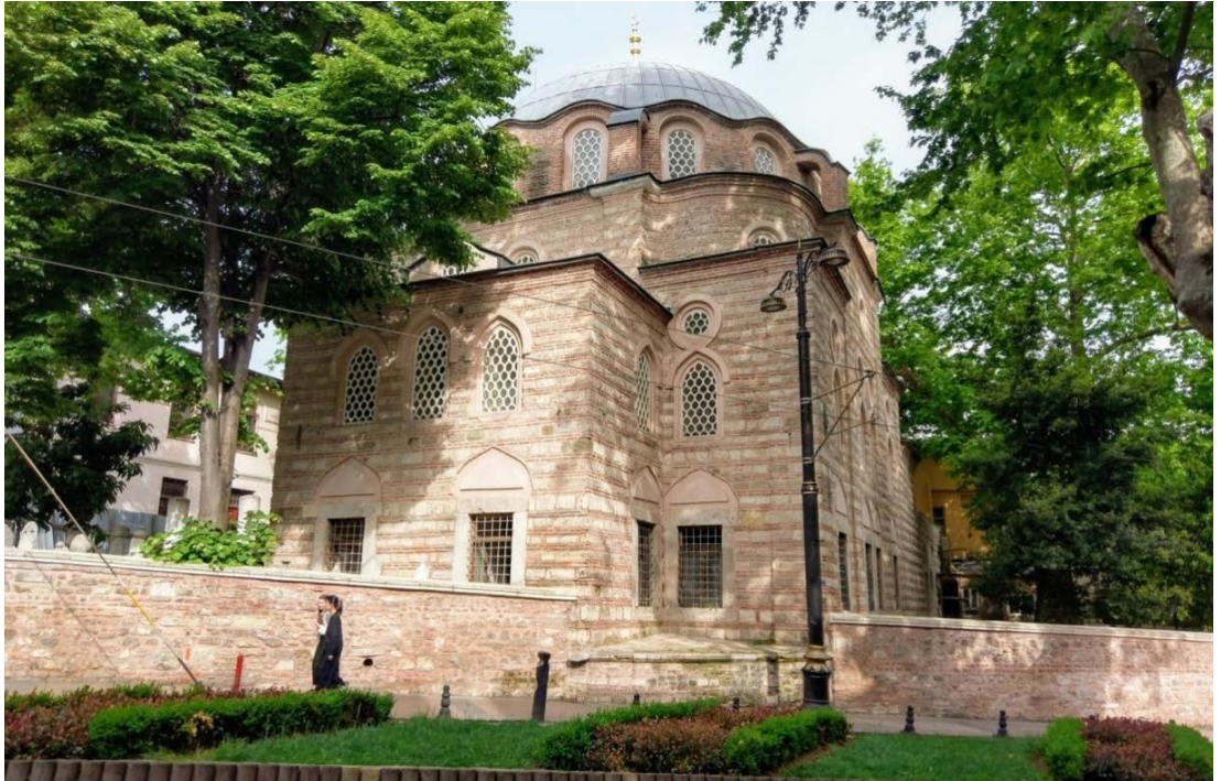
Şekil 2.15: Zeynep Sultan Camii, taş, tuğla almalı örgü kâgir yapı, 2019
