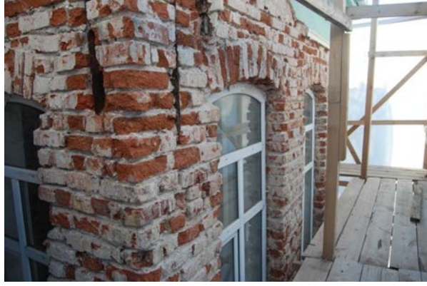
Şekil 4.47: Mahfil katı, çıkmanın basık kemerli pencereleri, raspa sonrası, 2014
