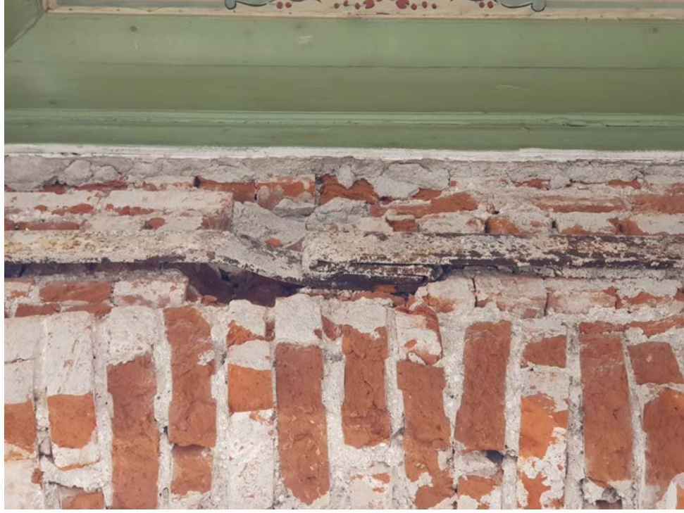
Şekil 5.53: Harim dairesindeki çıkmanın duvar gergi mesnetleme detayı
