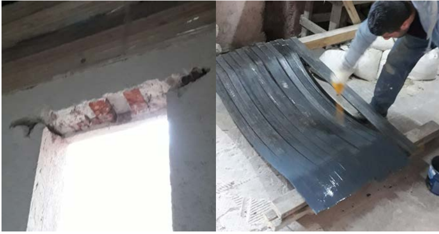
Şekil 5.71: Pencerelelerin metal elemanları Mekânîk temizlik sonrası yerinden çıkarılarak koruyucu antipas sürülmesi
