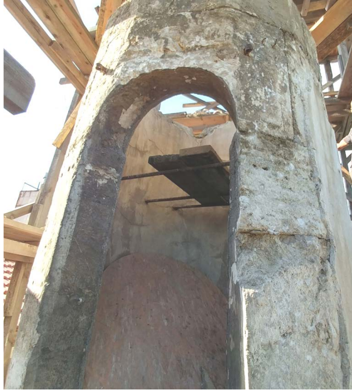
Şekil 5.90: Minarenin şerefekapısının bulunduğu kısımda uygulanan onarım gergileri
