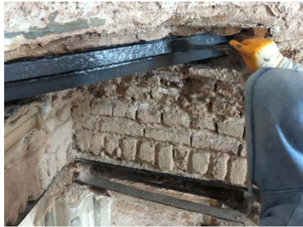
Şekil 5.18: Tromp altı metal elemanların konservasyonu
