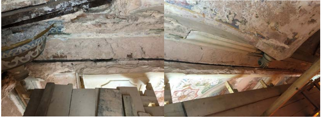
Şekil 5.25:Raspa sonrası silme kuşağı altında ortaya çıkarılan metal aksam,2017
