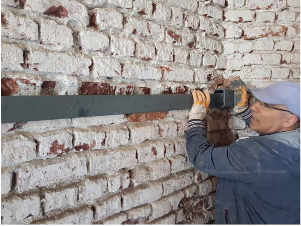
Şekil 5.61: Mahfil katının duvar gergilerinin yerine yerleştirilmesi
