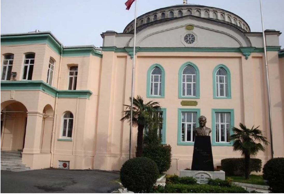
Şekil 4.49: Orhaniye Kışla Cami, güneybatı cephesi, ana Mekân cephe düzeni,2014
