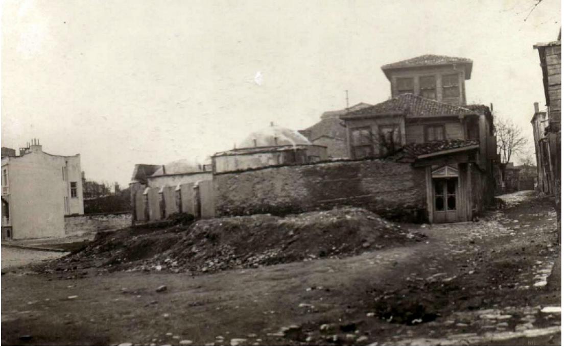
Şekil 4.9: Acemi Oğlanlar Hamamı'nın bir bölümü, Vezneciler, 1940
