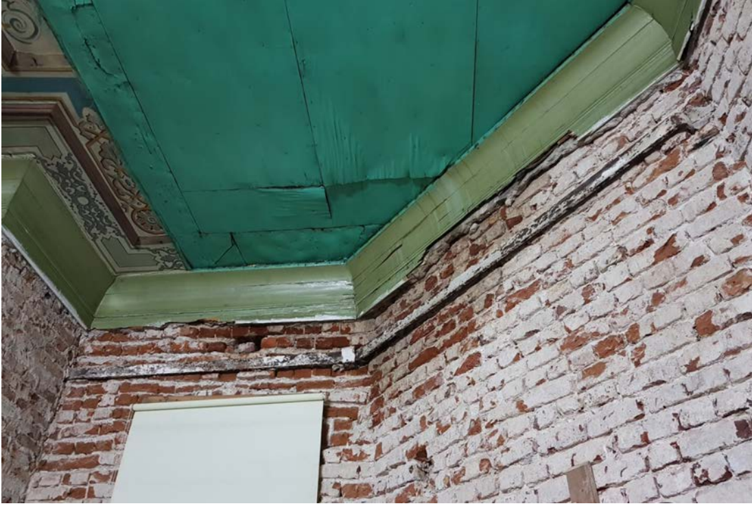
Şekil 5.51: Harim dairesinin çıkmasında ortaya çıkarılan köşe duvar gergileri
