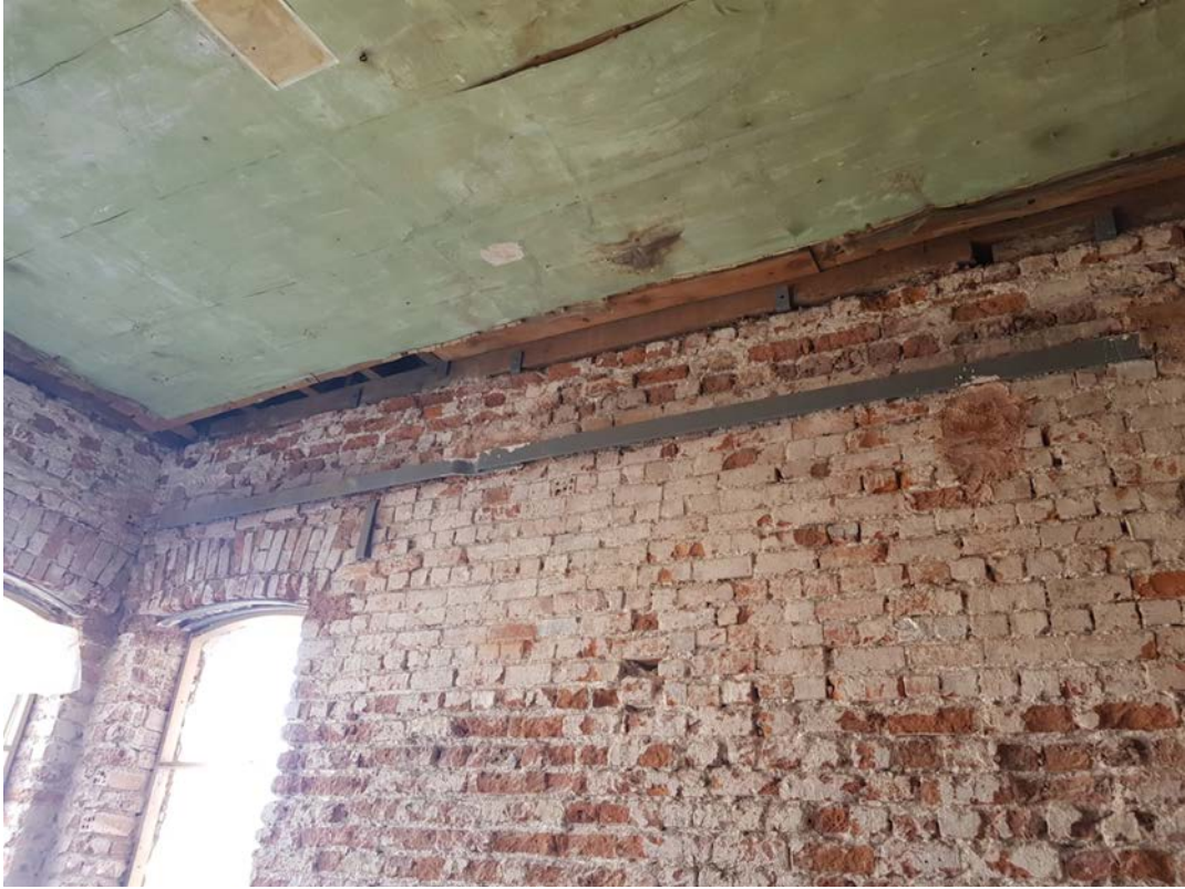
Şekil 5.64: Hünkâr dairesi duvar gergileri
