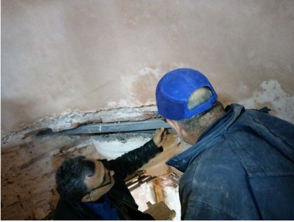
Şekil 5.19: Orhaniye Kışla Cami, tromp altı metal aksamının konservasyon sonrası kontrolleri, 2018
