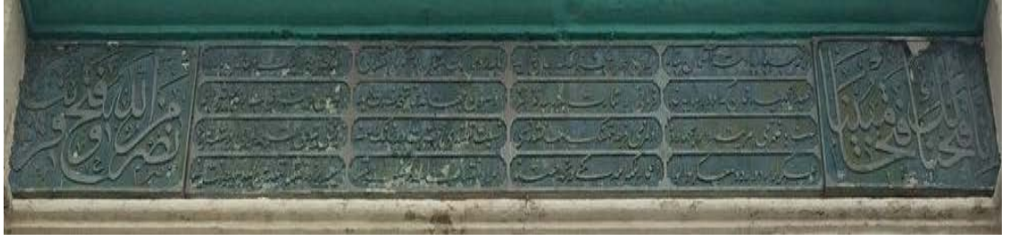
Şekil 4.34:Orhaniye Kışla-i Hümayunu avlu giriş kapısı üzerindeki kitabe
