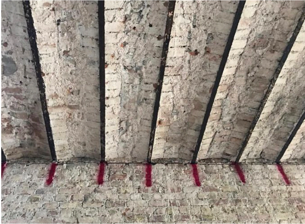
Şekil 3.51: Sıvadan arındırılmış, volta döşeme (Seda Özen Bilgili,2018)
