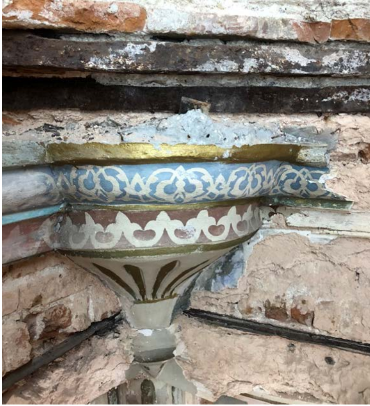
Şekil 5.15: Orhaniye Kışla Cami, tromplarının altında raspa sonrası açığa çıkan metal aksam ve orta aksta yer alan sarkıt, 2017
