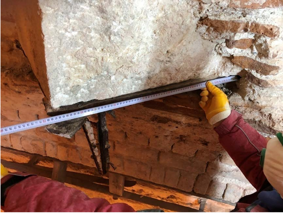
Şekil 5.4:Orhaniye Kışla Cami, harim tromp kemerlerinin oturduğu taş ve altındaki demir aksamın ölçüleri
