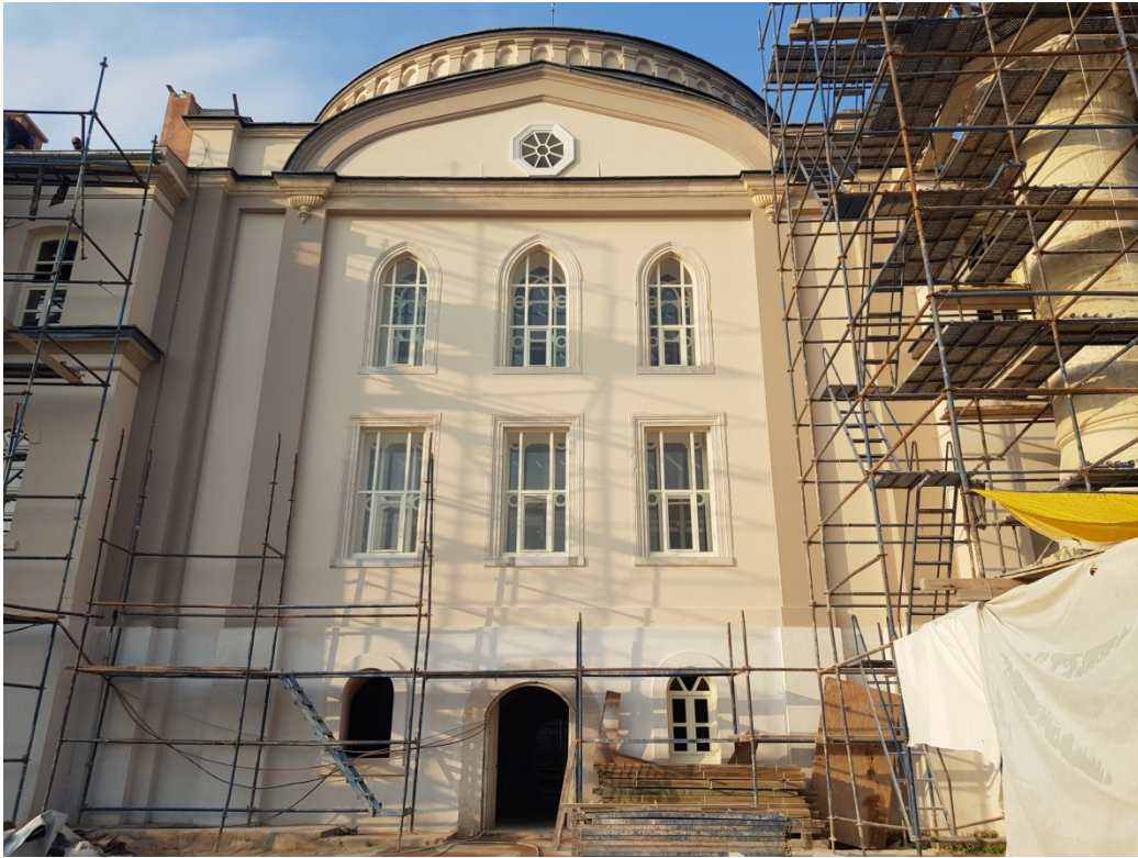
Şekil 5.47:Caminin kuzey cephesi restorasyon sırasında,2019
