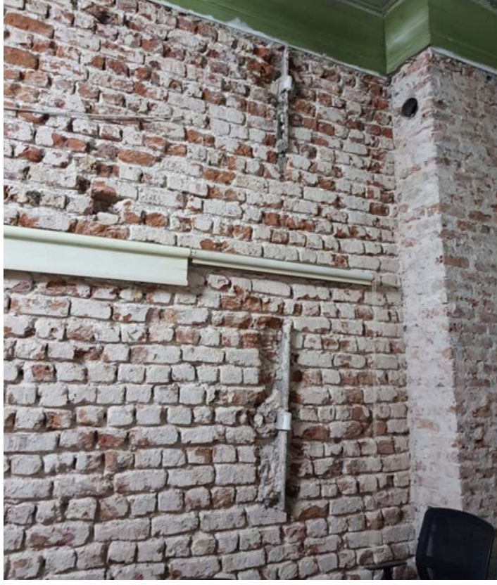
Şekil 5.55: Raspa sonrası açığa çıkarılan yarı gizli kılıçlama
