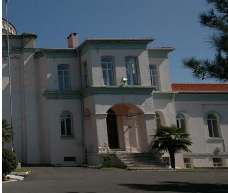
Şekil 4.55:Orhaniye Kışla Camii, Hünkâr dairesi, güneybatı cephesi, 2008
