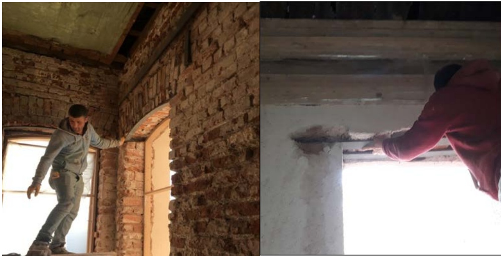
Şekil 5.72: Pencere kemer altı metal lentoları yerine yerleştirilmesi
