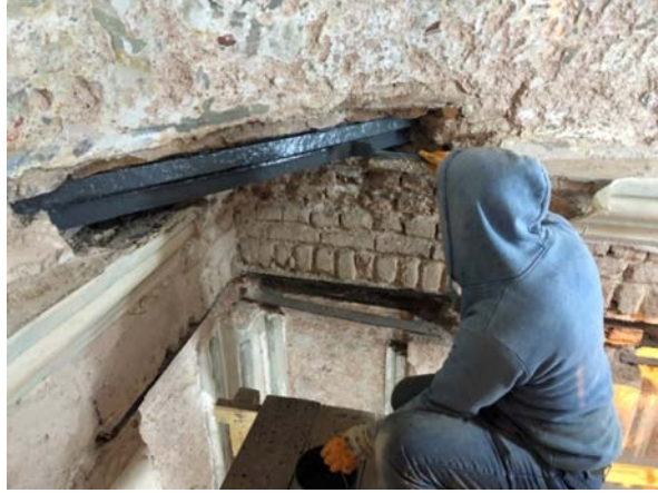
Şekil 5.17: Tromp altında yer alan metal elamanlara mekanik temizlik sonrası koruyucu antipas sürölmesi
