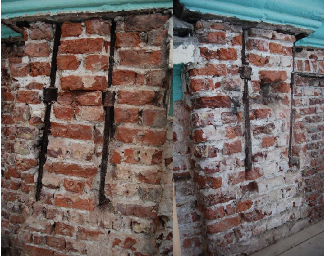
Şekil 5.41: Caminin harim dış cephesinde üst kotta yer alan yarı gizli kılıç mesnetleme
