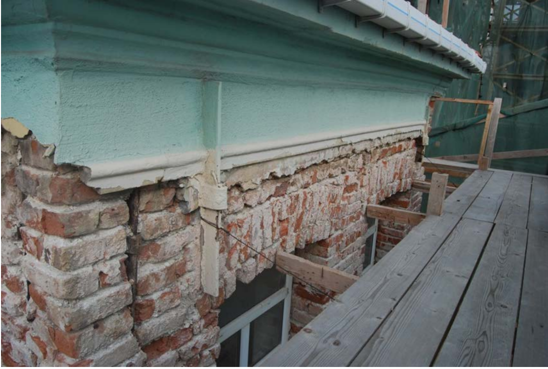
Şekil 5.66:Çıkmaların cephelerinde yer alan açık ve yarı gizli kılıçlı mesnetleme
