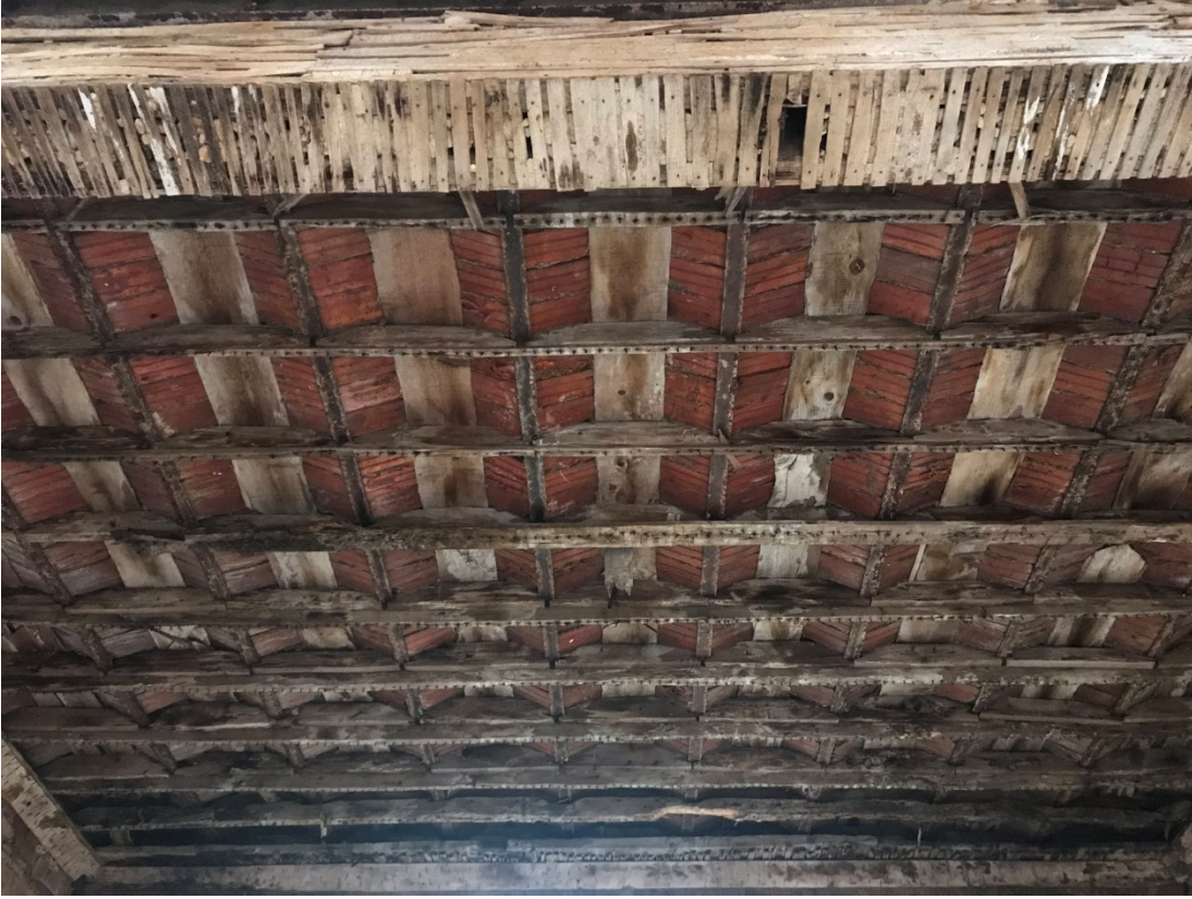
Şekil 3.52: Volta döşemede ahşap kirişler (Seda Özen Bilgili, 2018)
