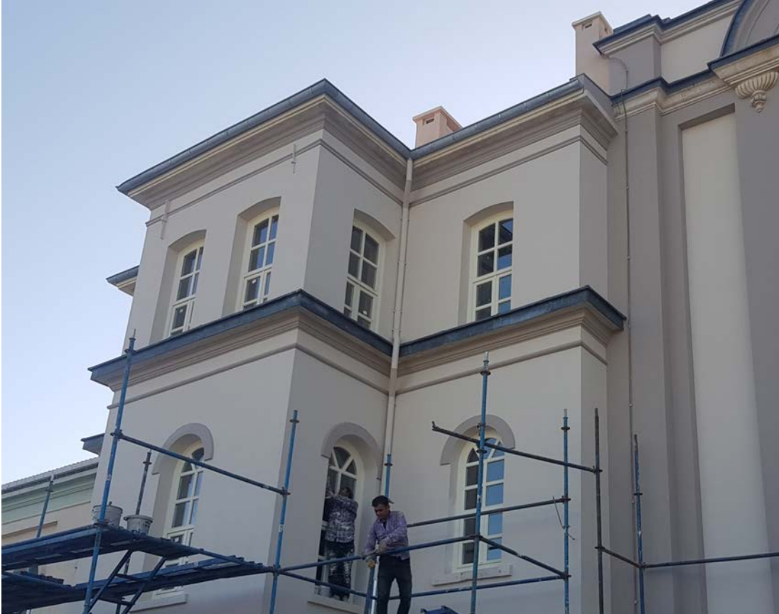
Şekil 5.67:Hünkâr dairesi dış cephesi, restorasyon sırasında, 2019
