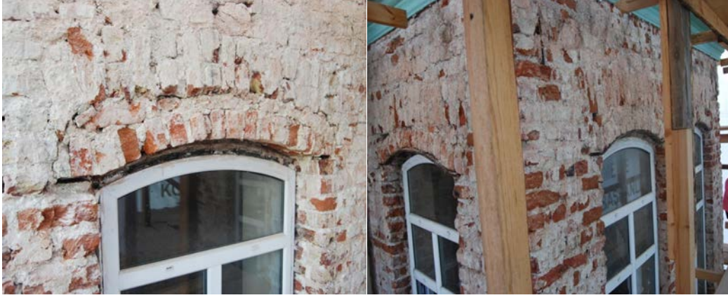
Şekil 5.70: Pencere kemer altlarında yer alan yatay demir hatıllar
