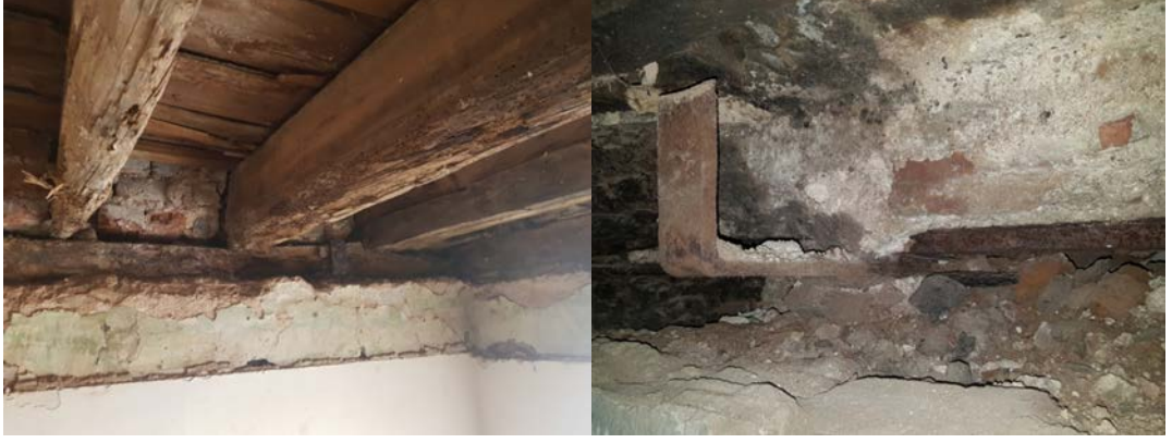
Şekil 5.82: Ahşap döşeme kirişlerinde metal kenetler
