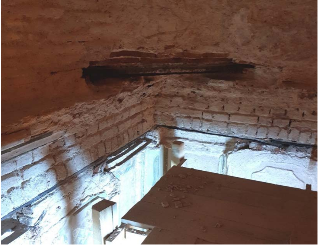
Şekil 5.33: Silme kuşağı altında ortaya çıkarılan demir kuşaklama ve tromp altı metal aksamlar, restorasyon sırasında, 2015
