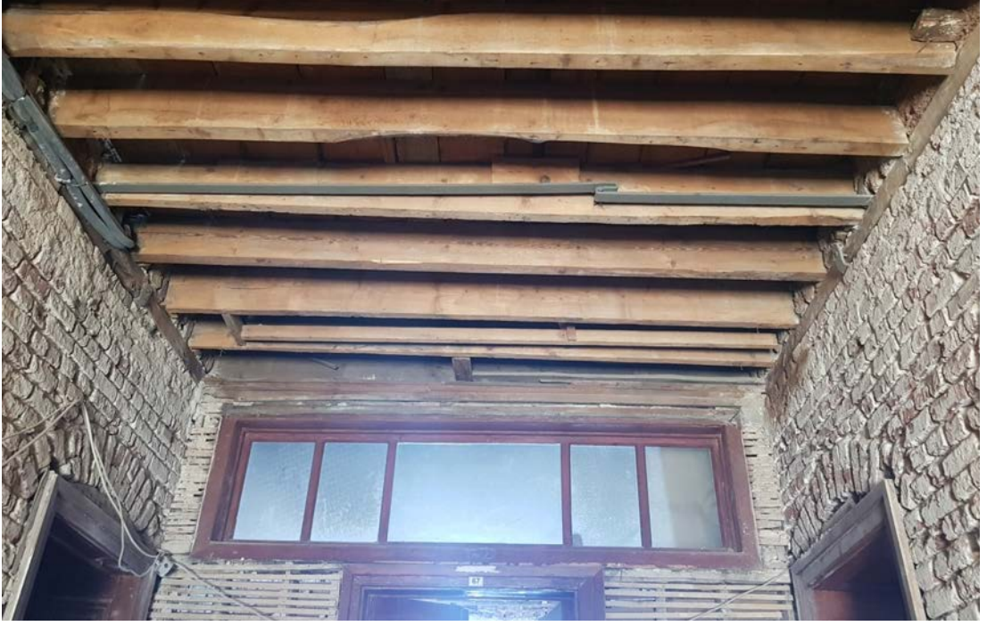
Şekil 5.57: Ahşap döşeme kirişinin altında zemin kat duvarlarını birbirine bağlayan dövme demir gergi
