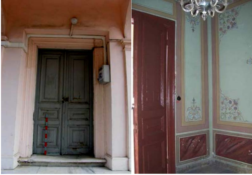
Şekil 4.45: Orhaniye Kışla Cami, güneybatı cephesi, ana giriş cümle kapısı ve giriş sahanlığı, 2008
