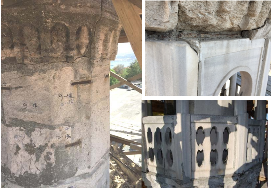
Şekil 5.95:Minarede taşları bağlamak için kullanılan kenetler
