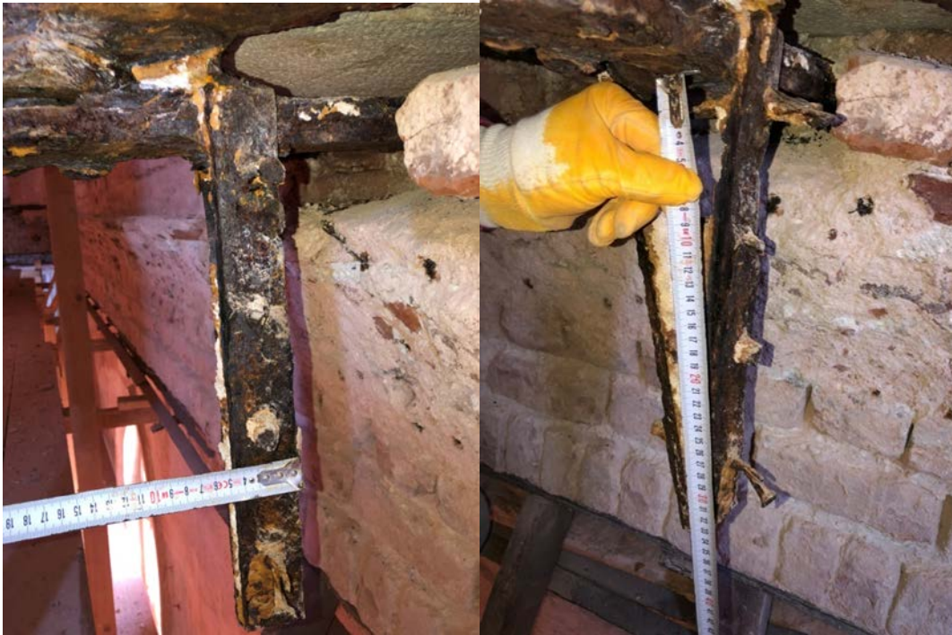
Şekil 5.5: Harim tromp kemerlerinin oturduğu taş ve altındaki demir sarkıtın ölçüleri
