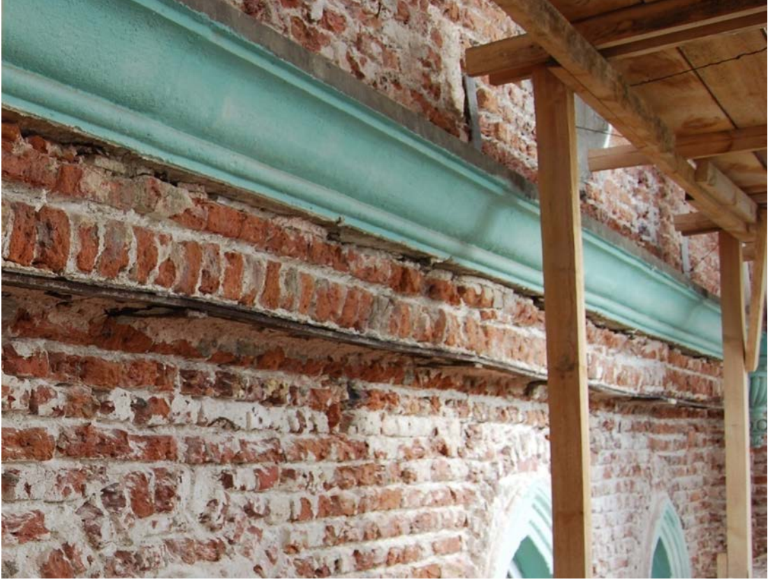
Şekil 5.29:Çift taraflı konsol teşkil eden demir lamalar, dış cephe,2014
