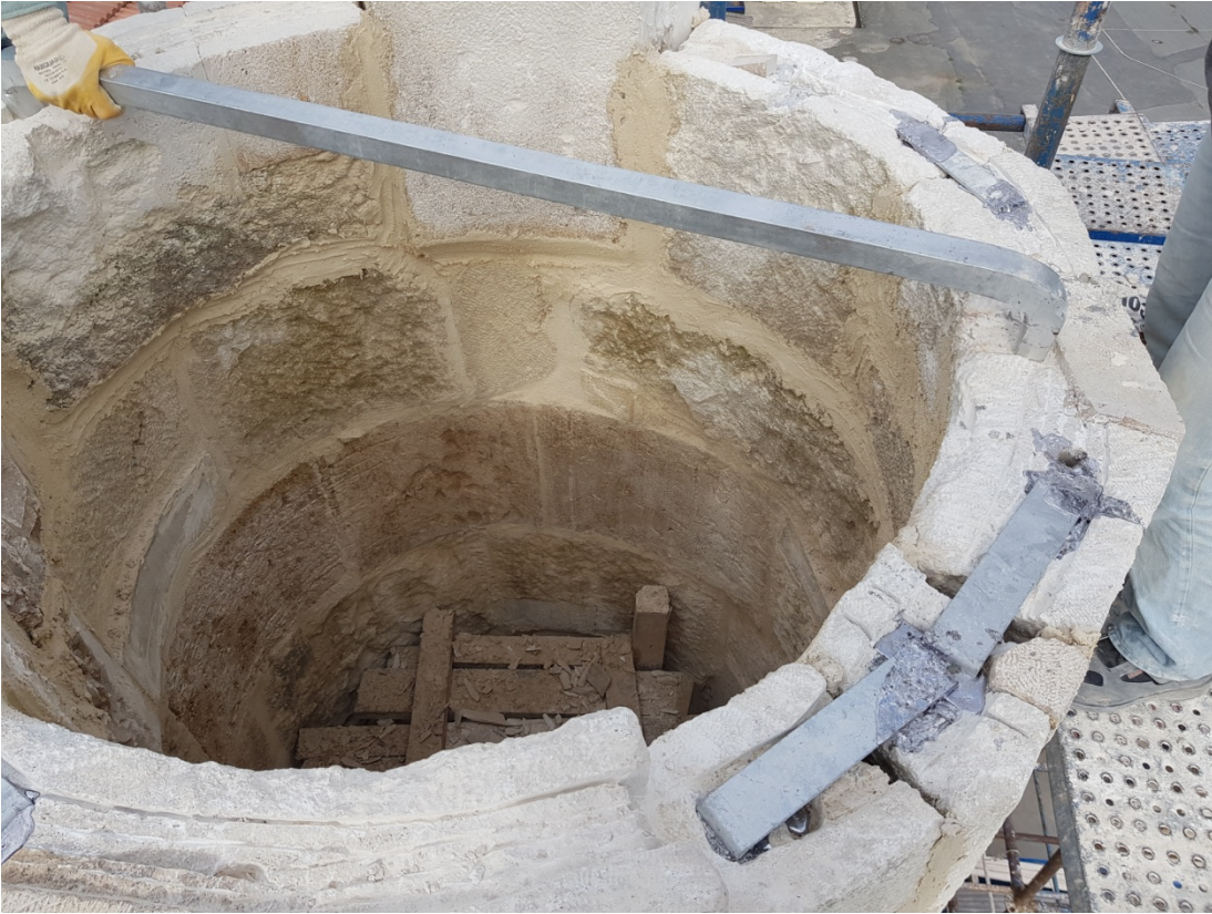
Şekil 5.97: Minarenin silindir gövdesinin çapı boyunca duvarlara mesnetlenen kenet veya bir nevi gergi, restorasyon sırasında
