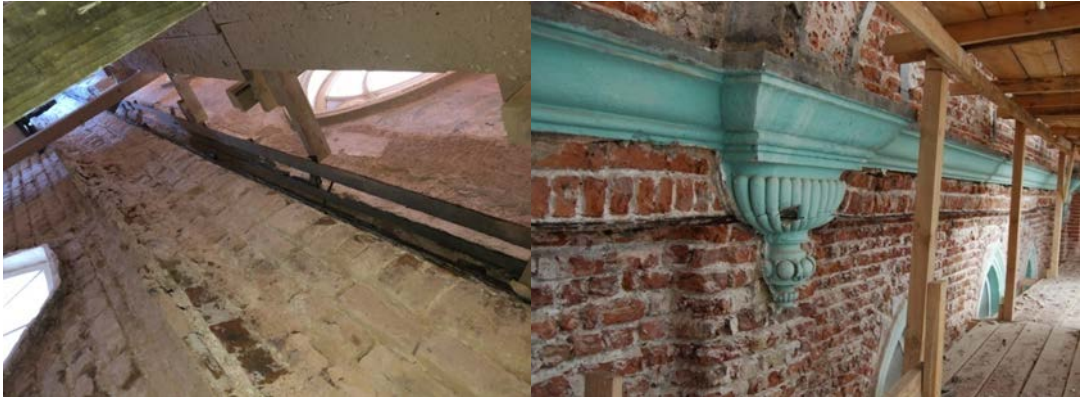
Şekil 5.26:Raspa sonrası iç ve dış cephede ortaya çıkarılan demir kuşaklama, 2017
