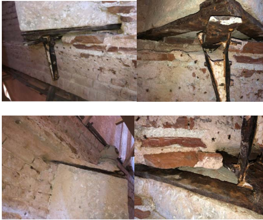
Şekil 5.3:Orhaniye Kışla Cami, harim tromp kemerlerinin oturduğu taş ve altındaki demir aksam
