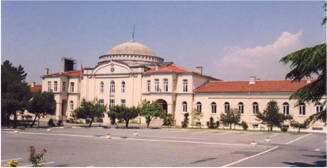
Şekil 4.43: Orhaniye Kışla Cami, güney cephesi, 2001
