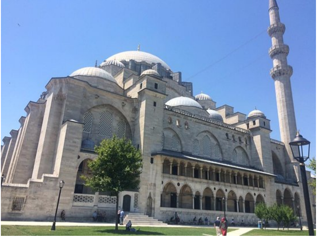
Şekil 2.14: Süleymaniye Camii, kesme taş örgü yığma kâgir yapı, 2019
