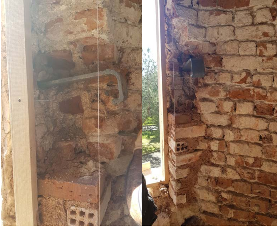
Şekil 5.59: Mahfil katında kullanılan duvar gergilerini mesnetleyen demir kenetler
