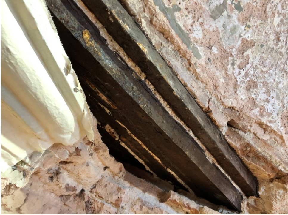
Şekil 5.13: Orhaniye Kışla Cami, trompların altındaki metal aksam düzenlemesi, alttan görünüm, 2017
