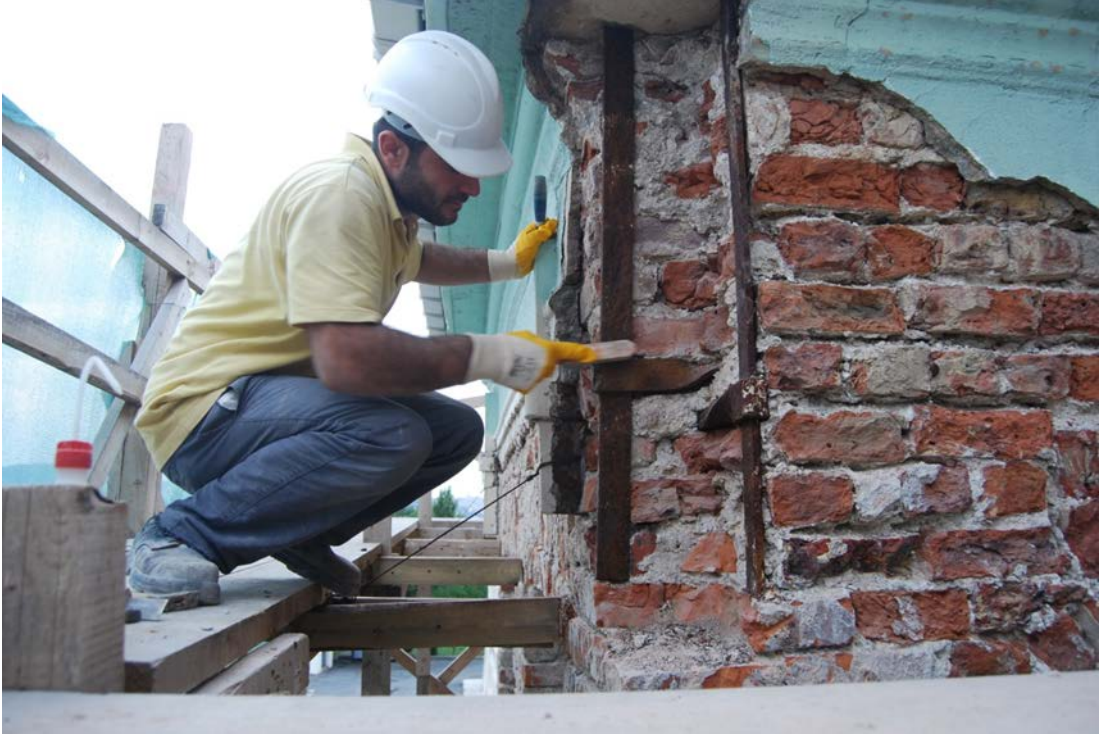
Şekil 5.45:Cephelerdeki korozyona uğrayan metal elemanların Mekânîk temizliğinin yapılması
