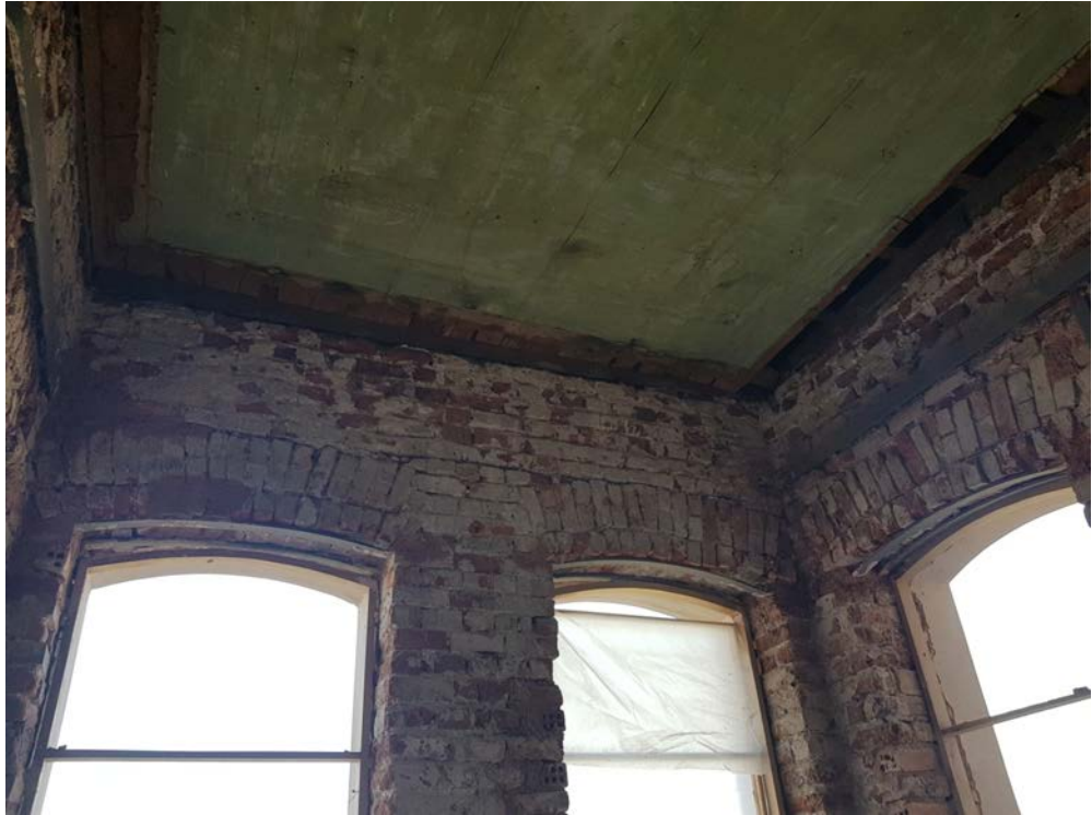
Şekil 5.74: Hünkâr dairesi pencere lento, konservasyon sonrası, 2019
