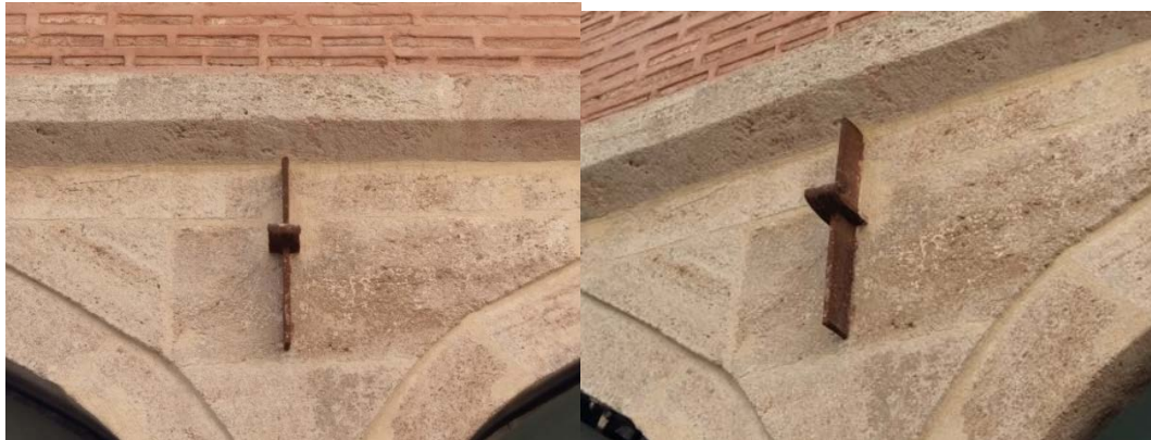
Şekil 3.12: Topkapı Sarayı, matbah-ı amire binaları açık kılıçlama sistemi, 2019
