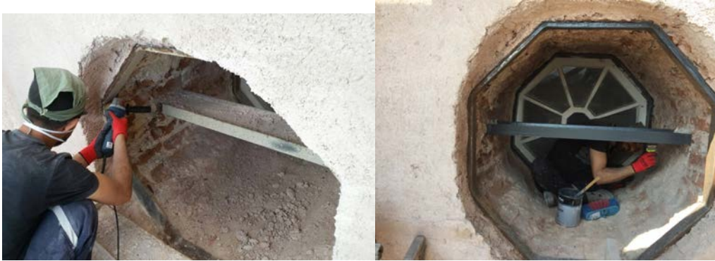
Şekil 5.77: Caminin harim mahalinde üst kotta yer alan altıgen tepe pencerenin metal dışlıklarının konservasyonu
