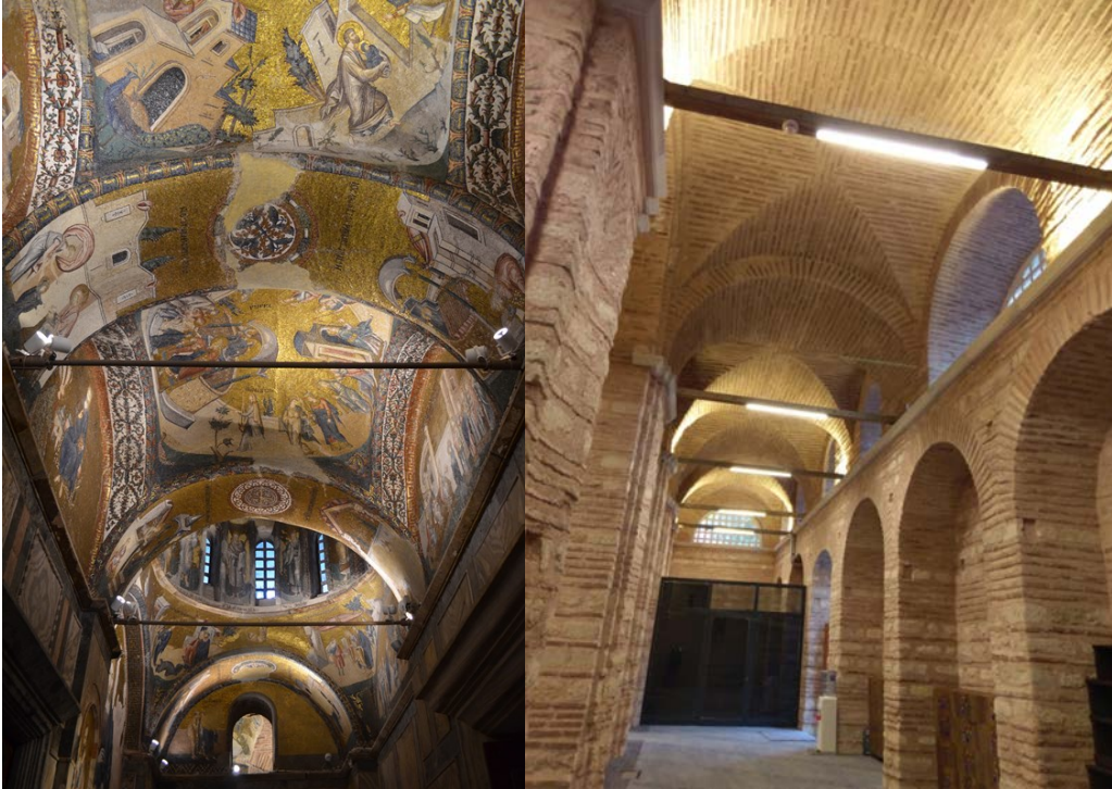
Şekil 3.43: Kariye Camii ve Fenari İsa Camii tonozlarının açıklık gergileri
