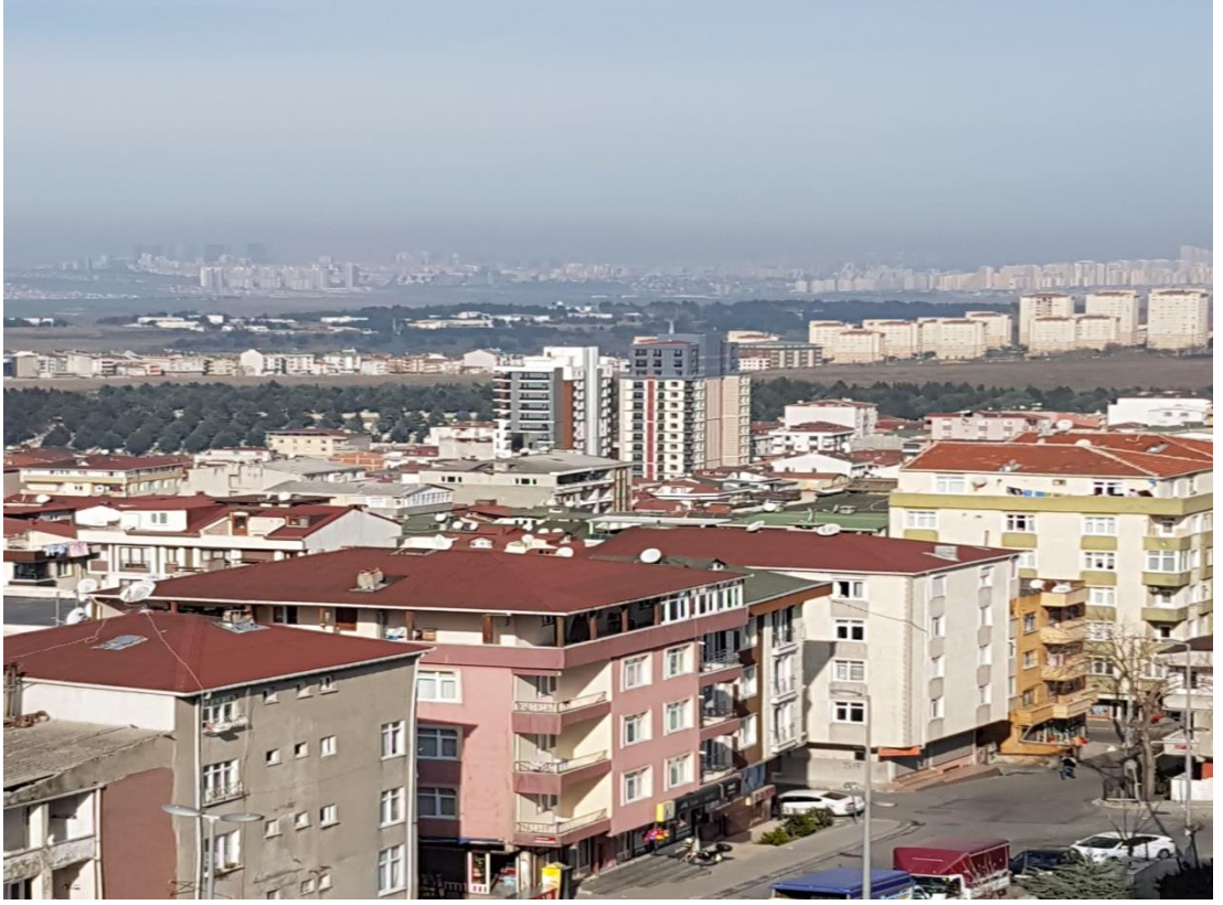
Şekil 4.23: Kanarya Mahallesindeki Kentsel Dönüşümle Yapılan Yeni Yapı Örneği (Tez yazarı tarafından oluşturulmuştur (2019))
