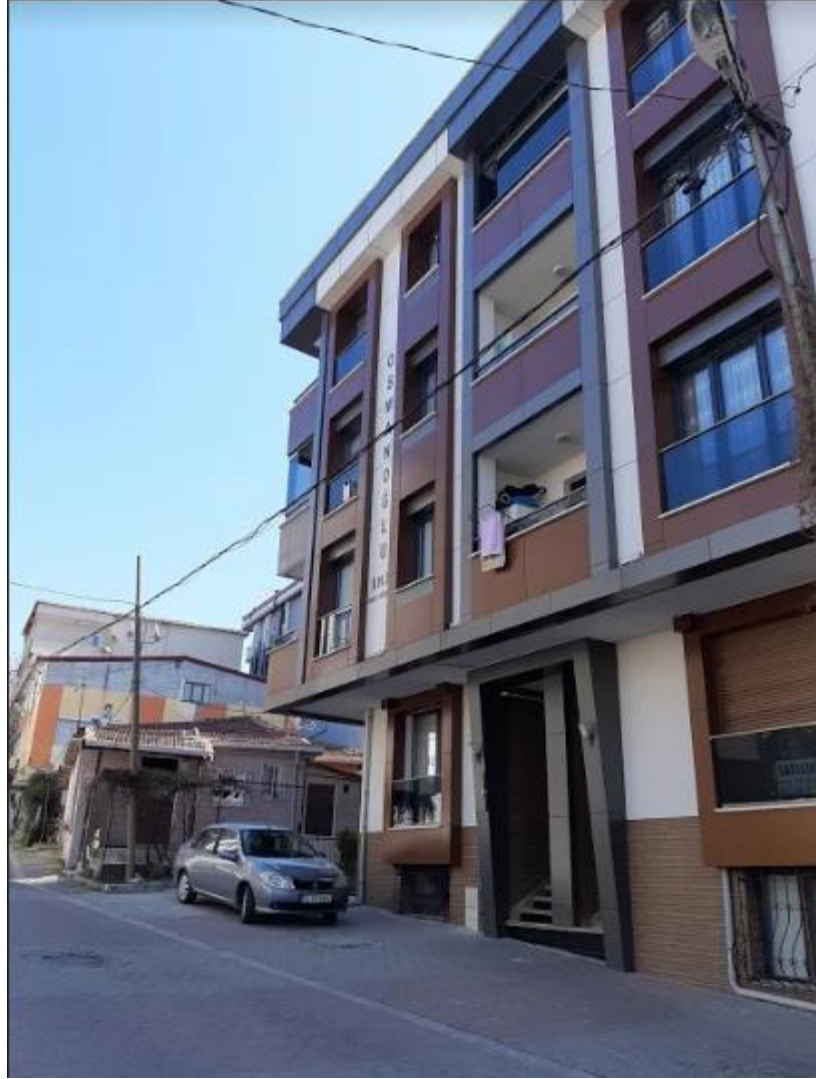
Şekil 4.17: Kanarya Mahallesi'ndeki Kentsel Dönüşümle Yapılan Yeni Yapı Örneği (Tez yazarı tarafından oluşturulmuştur (2019))
