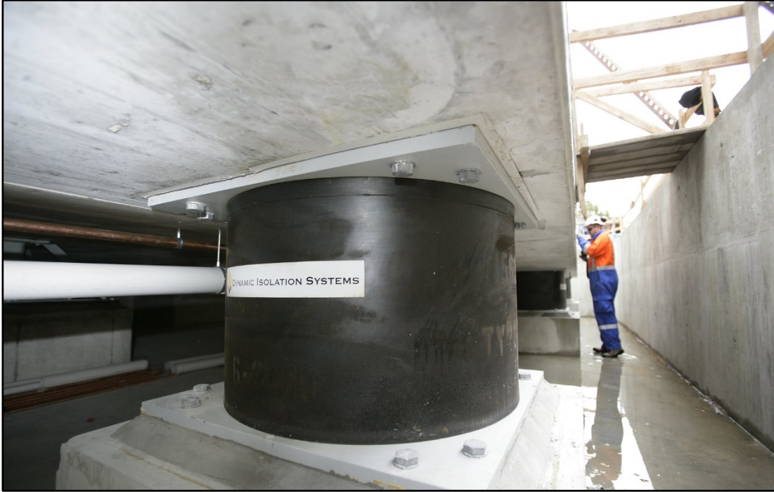
Şekil 1.2 : Tabakalı Kauçuk Mesnetler (LRB)
