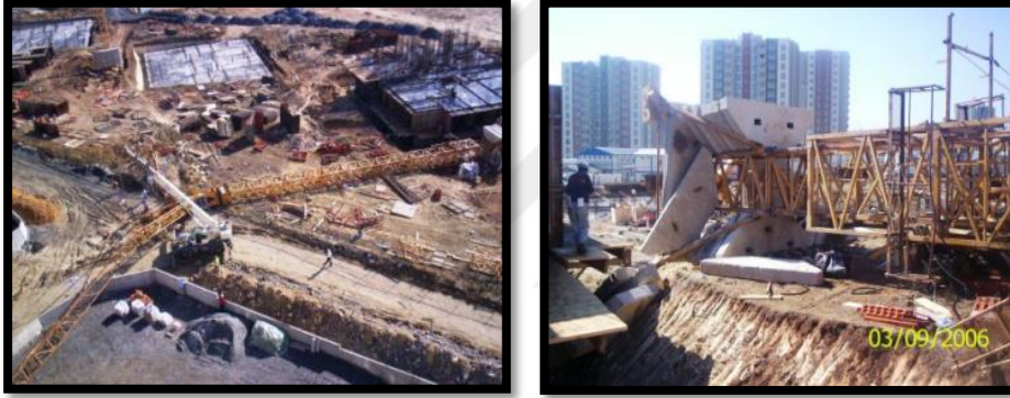
Şekil 2.1: İşçi kampının yanına düşen vinç. [Soyak İnşaat Fotoğraf Arşivi]
