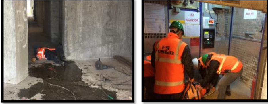
Şekil 3.4: Elektrik çarpması iş kazası. [Eroğlu Holding, Skyland İstanbul İnşaat Arşivi]
