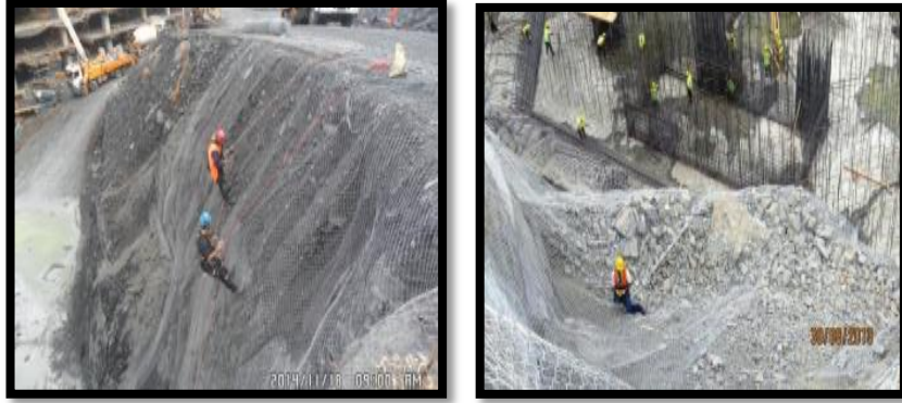
Şekil 3.8: Şantiye alanı toprak kaymasını önleyici file gerilmesi. [Eroğlu Holding, Skyland İstanbul İnşaat Arşivi]
