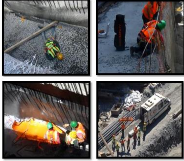
Şekil 4.2: İp merdiven ve konik kurtarma sedyesi ile yüksekten düşme/ sınırlı alandan kurtarma. [Eroğlu Holding, Skyland İstanbul İnşaat Arşivi]
