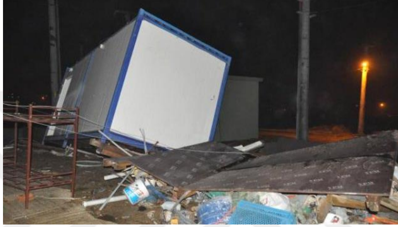
Şekil 3.6: Fırtına nedeniyle yıkılan işçi konteynerleri.
