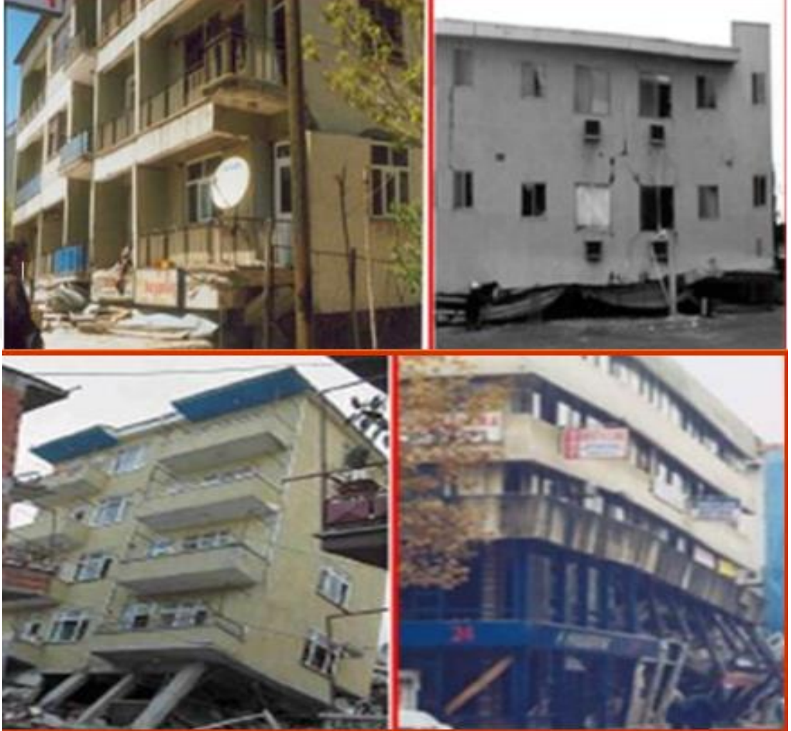
Şekil 2.12: 2004 Sumatra depremi, yumuşak kat nedeniyle yapıların yıkılması
