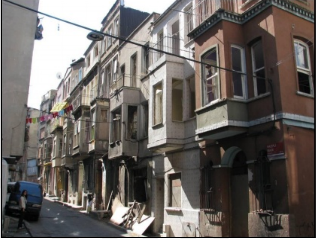
Şekil 4.19. 362 No' lu Ada Günümüz Görünümü. (İstanbul Yenileme Alanları KVKBKM Arşivi-2012).
