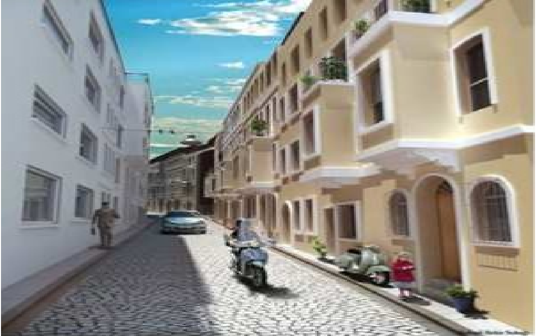
Şekil 4.20. 362 No'lu Adanın Proje Sonrası Görünümü. ( http://www.tarlabası.yenileniyor.com/foto_galeri/default.aspx?SectionId=1320 . 11.05.2015).
