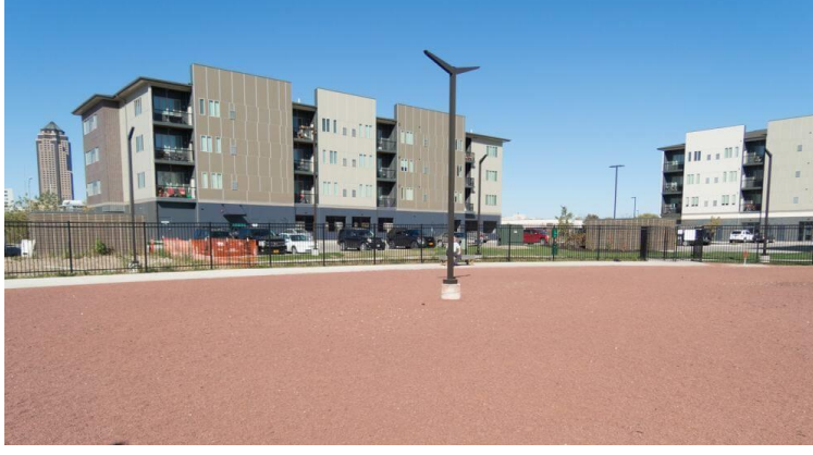
Şekil 43. Kırmızı Sedir Granit Yüzey Malzemesi, Cityville Köpek Parkı, Iowa, ABD Kaynak: (www.kafkagranite.com, 2023)
