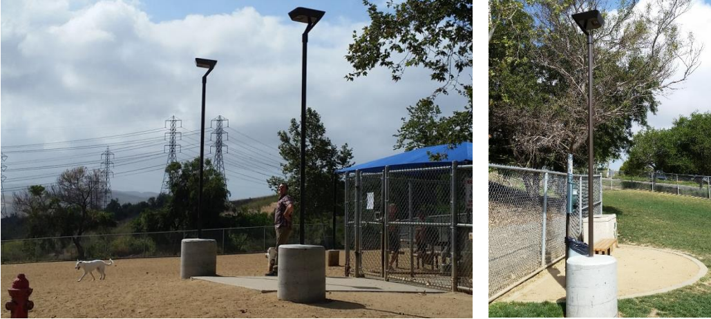
Şekil 63. Solar Aydınlatma Elemanları, Baron Von Willard Anıt Parkı, Kaliforniya, ABD
