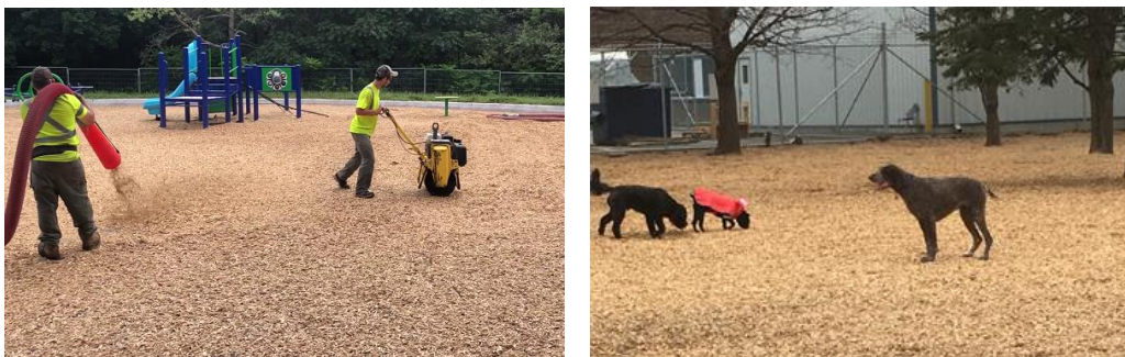
Şekil 38. EWF Zemin Kaplama Uygulaması, Kanada
