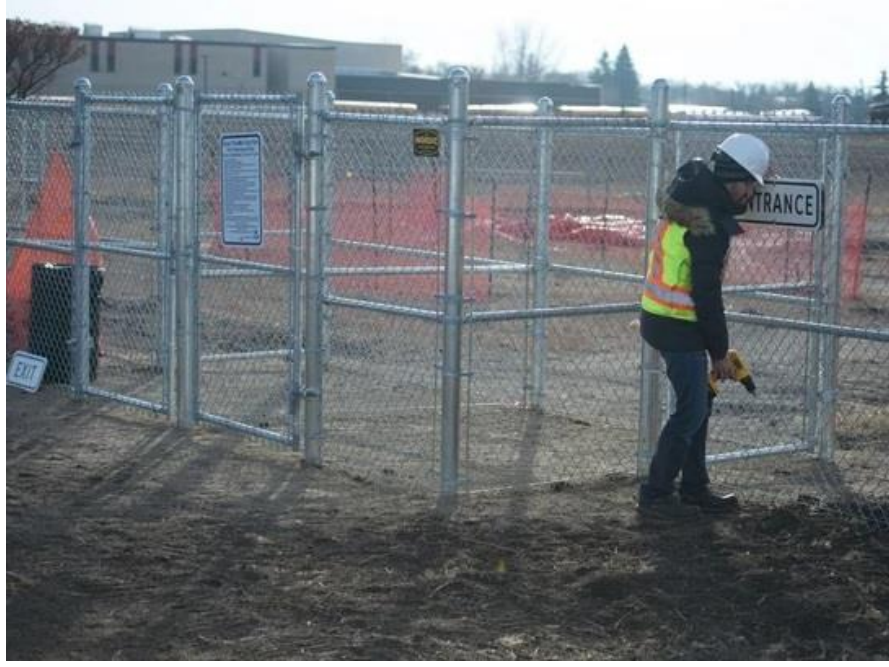
Şekil 29. Çit Yapım Aşaması, Mount Pleasant Köpek Parkı, Regina, Kanada Kaynak: ( https://leaderpost.com , 2023)
