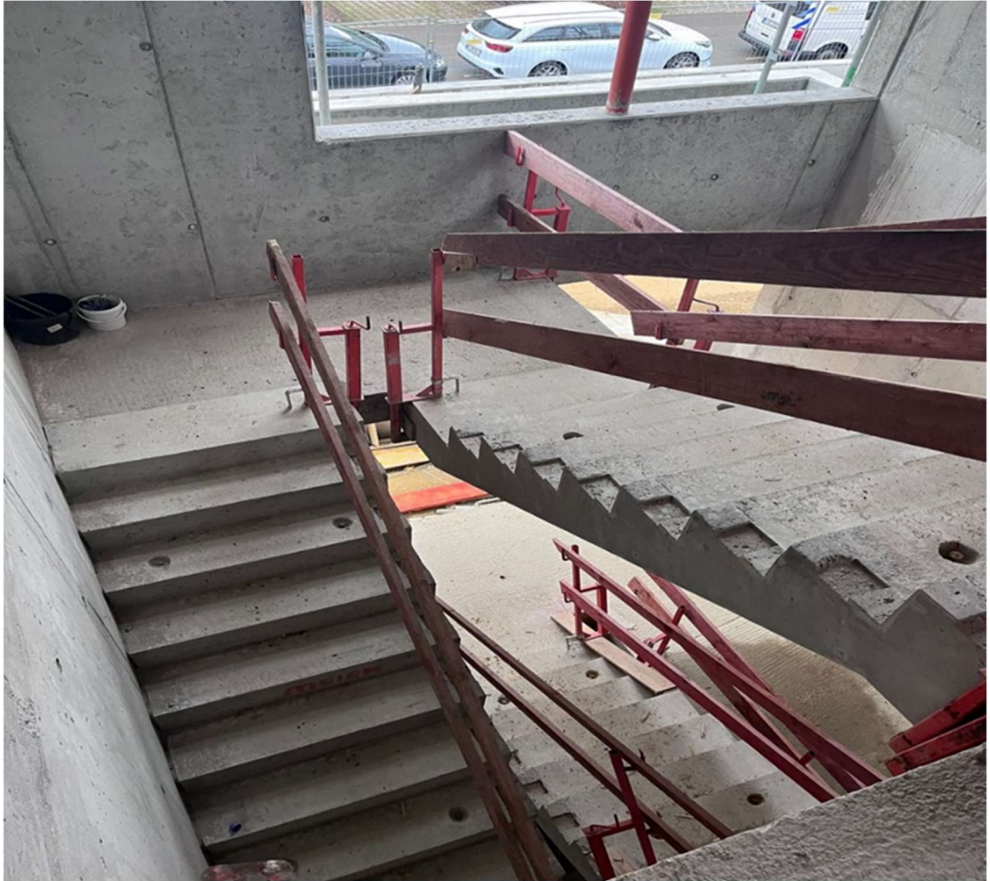
Şekil 35 Hazır beton elemanlarının şantiyede montajı (Cenik, 2023).
