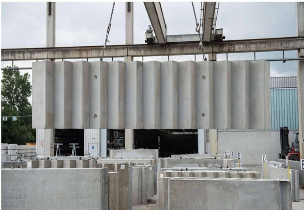
Şekil 8 Prefabrike üretim merdivenin şantiye ortamında montaj aşaması (bedo-fertigteile.de, 2023).
