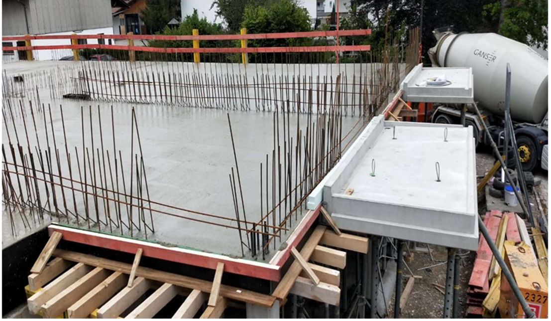
Şekil 22 Hazır Betonarme Balkon Döşemesi (Cenik, 2022).
