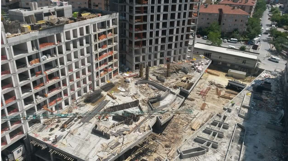
Şekil 3 Standart betonarme yapı şantiye örneği (Cenik, 2014).
