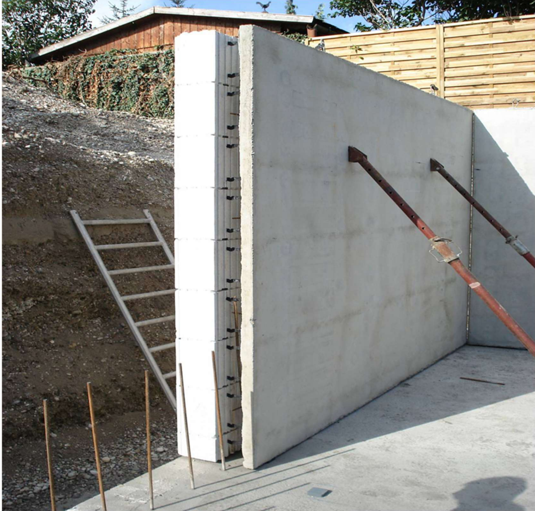
Şekil 10 Tek kanatlı dolu duvar panelleri (bedo-fertigteile.de, 2023).
