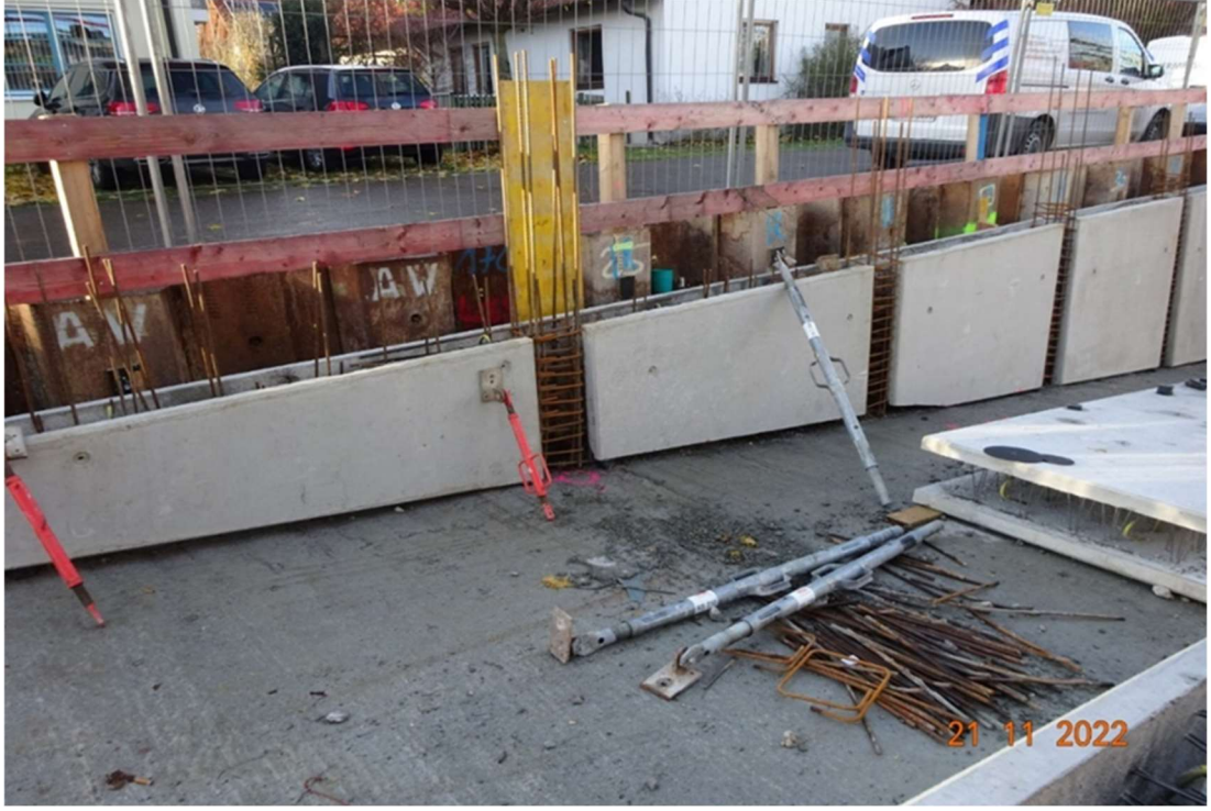
Şekil 34 Hazır beton panellerin farklı ölçülerde montajı (Cenik, 2022).
