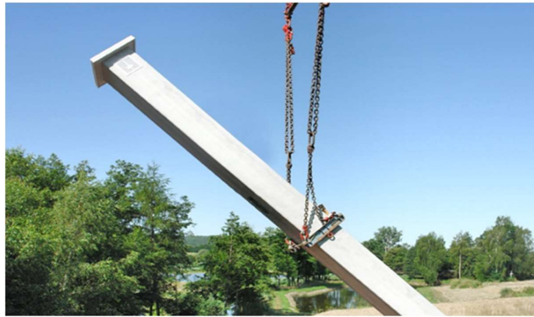
Şekil 23 Prefabrike Betonarme Baca (Cenik, 2022).
