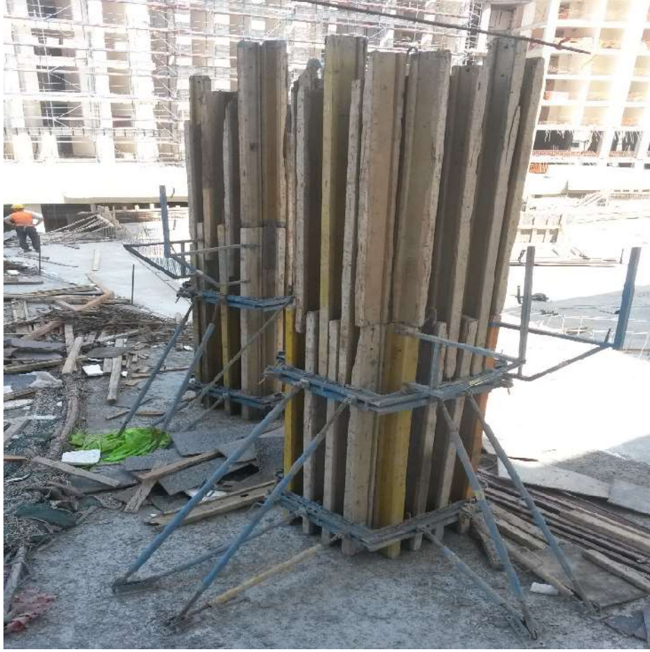
Şekil 4 Birden fazla kullanılan kolon kalıp örneği (Cenik, 2014).
