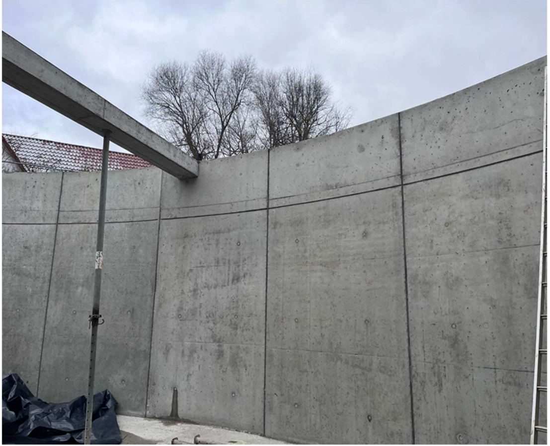
Şekil 29 Hazır beton panellerin montajı sonrası görünümü (Cenik, 2022).
