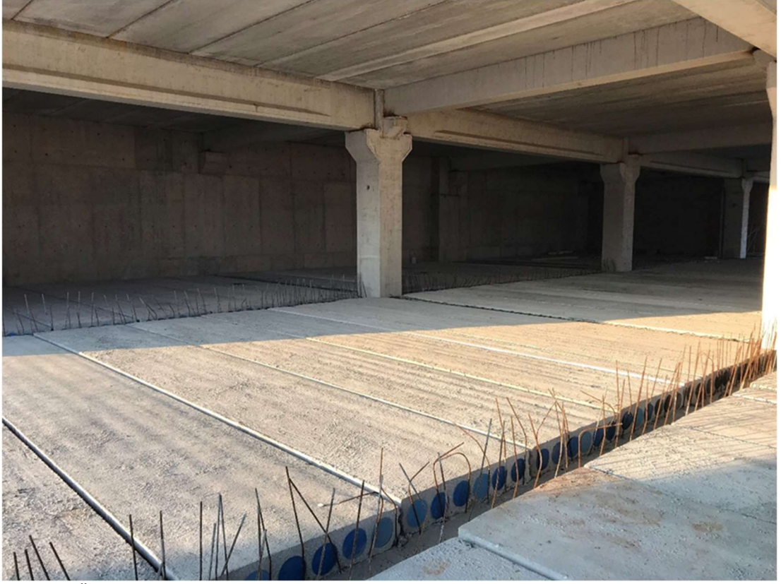
Şekil 18 Ön Gerdirmeli Boşluklu Döşeme (Prefab.org.tr, 2023).
