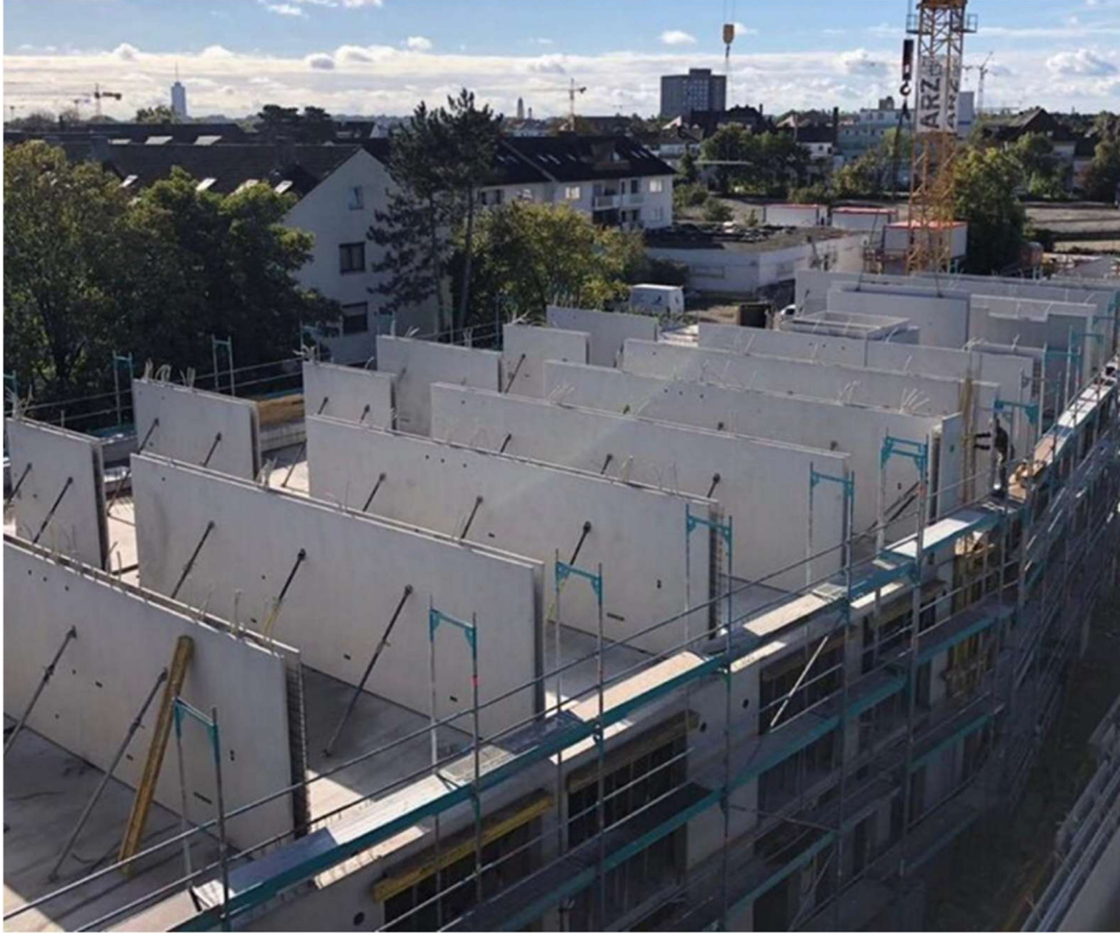
Şekil 15 İçi boşluklu Çift kanatlı betonarme bölücü duvar panelleri (Cenik, 2019).
