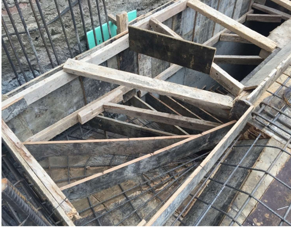
Şekil 32 Standart betonarme kalıp yöntemi ile merdiven kalıp uygulaması (Cenik, 2016).
