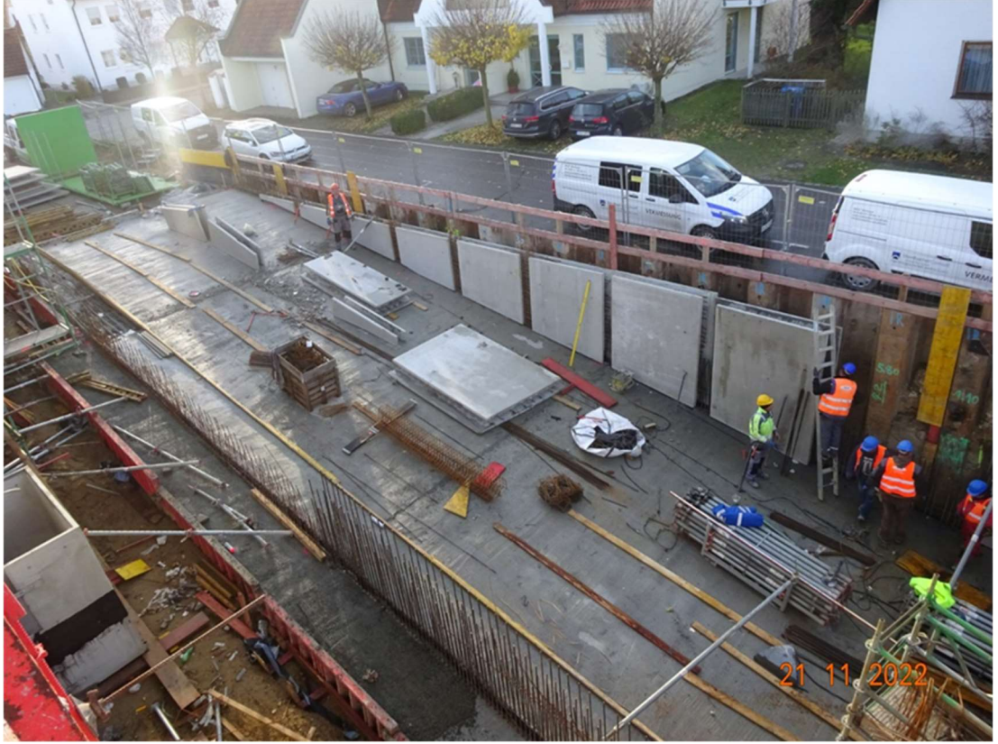
Şekil 30 Hazır beton panellerin nakliye sonrası anında montajı (Cenik, 2022).
