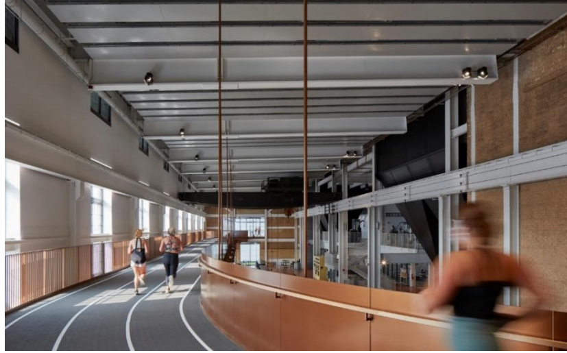
Şekil 39. Beloit College The Powerhouse Çağdaş Ek, Asma Çelik Köprü Üst Kat (Kaynak: https://architizer.com , 2023)
