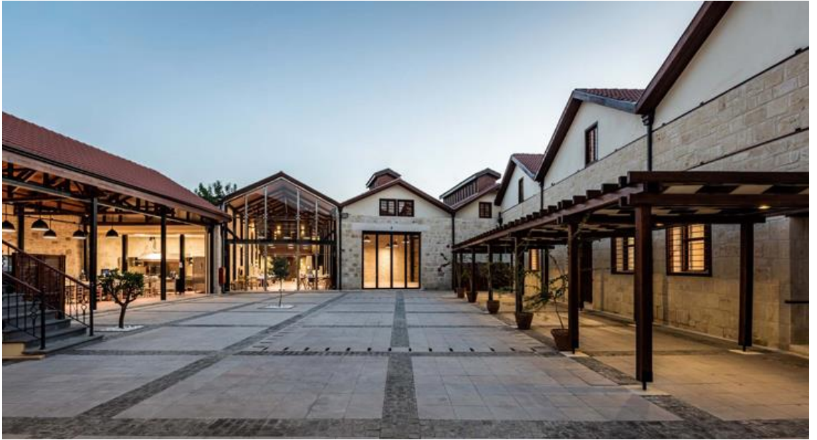
Şekil 86. Gözlükule Kazısı Araştırma Merkezi İç Avlu (Kaynak: https://www.arkitera.com , 2023)
