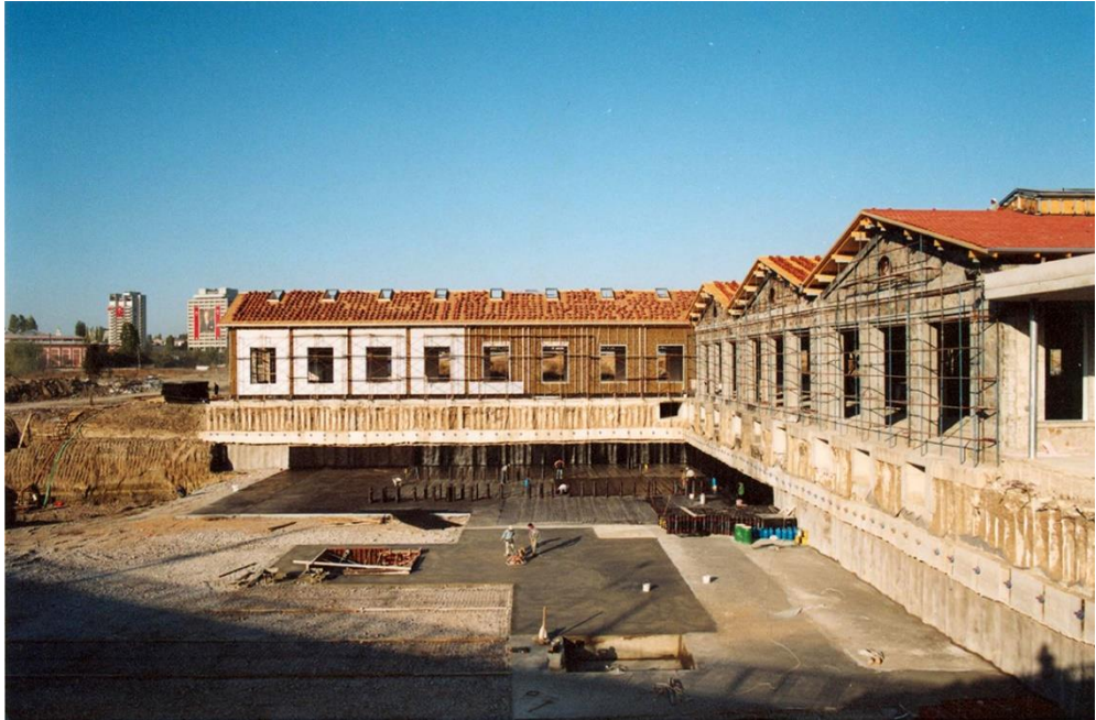
Şekil 95.Cer Modern İnşaat Süreci (Kaynak: https://www.santiye.com.tr , 2023)
