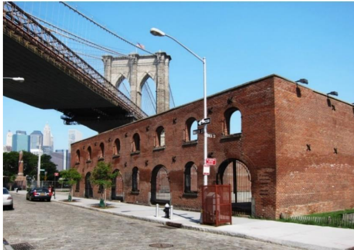
Şekil 51.Yeniden İşlevlendirme Öncesi Mevcut Yapı (Kaynak: https://www.archdaily.com , 2023)
