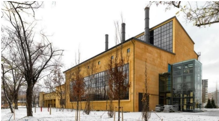
Şekil 72. Abdullah Gül Üniversitesi Yeniden İşlevlendirme Sonrası Dış Cephesi (Kaynak: https://emrearolat.com , 2023)
