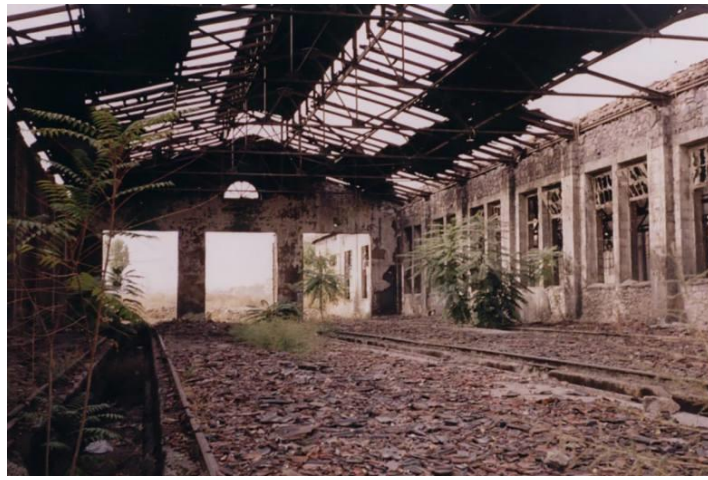
Şekil 92. Yeniden İşlevlendirme Öncesi Cer Atölyeleri (Kaynak: https://www.santiye.com.tr , 2023)
