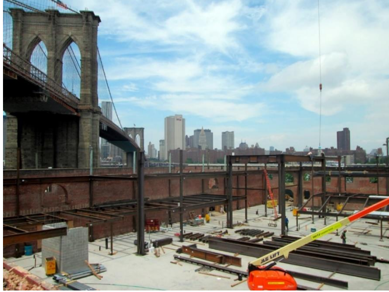
Şekil 52. Yeniden İşlevlendirme Çelik Taşıyıcı Sistem Uygulaması (Kaynak: https://www.archdaily.com/ , 2023)
