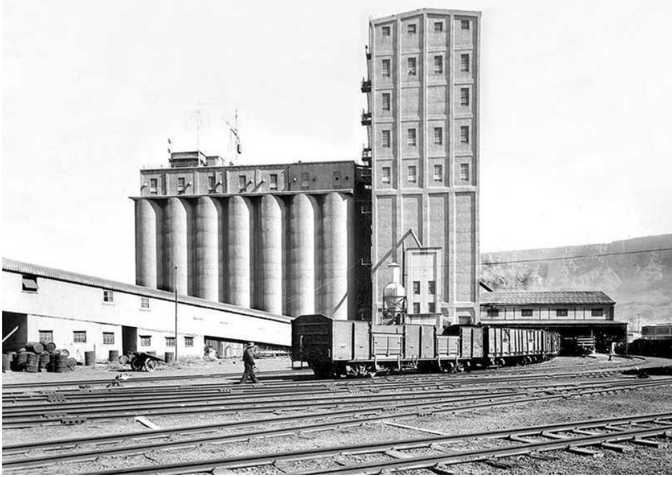
Şekil 43.V&A Tahıl Silosu Özgün İşlev Dış Cephesi (Kaynak: https://arkipedia.net , 2023)
