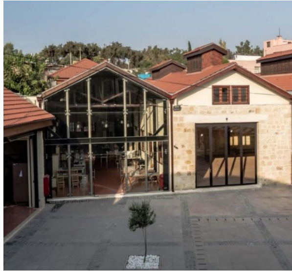
Şekil 89.Tarsus Çirçir Fabrikası Yenileme Sonrası Dış Cephe Çelik ve Çatı Uygulaması (Kaynak: https://www.naturadergi.com , 2023)
