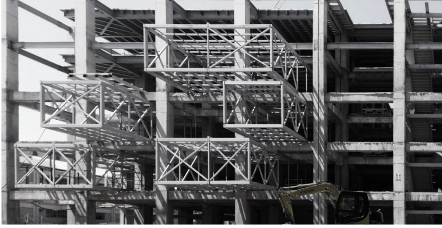
Şekil 102.İstanbul Resim ve Heykel Müzesi İnşaat Aşaması (Kaynak: https://emrearolat.com , 2023)
