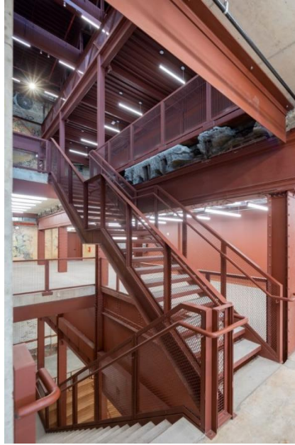
Şekil 63. Powerhouse Sanat Üretim Merkezi Sirkülasyon Eki Merdivenler (Kaynak: https://www.archdaily.com , 2023)
