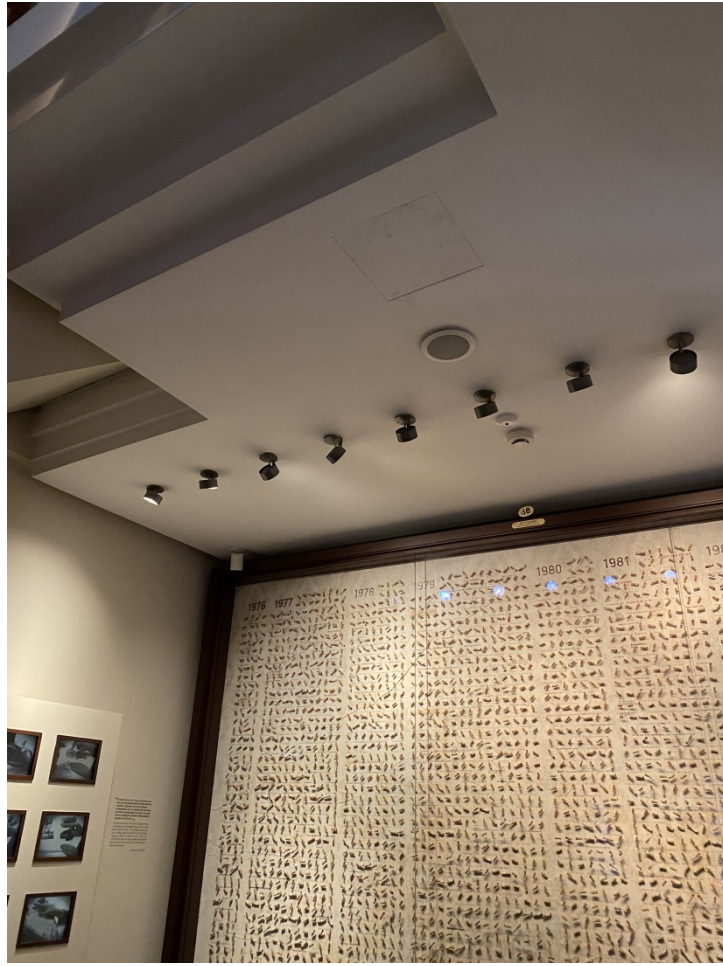
Şekil 20. Müzenin Aydınlatma Sisteminden Görünüm
