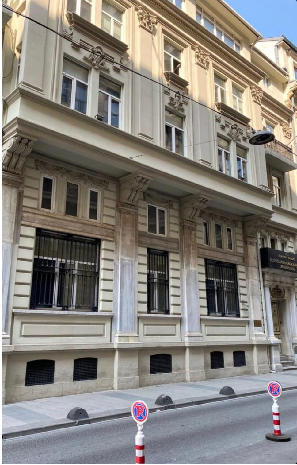
Şekil 4. Pera Bölgesi Yapılarından Görünüm -2-
