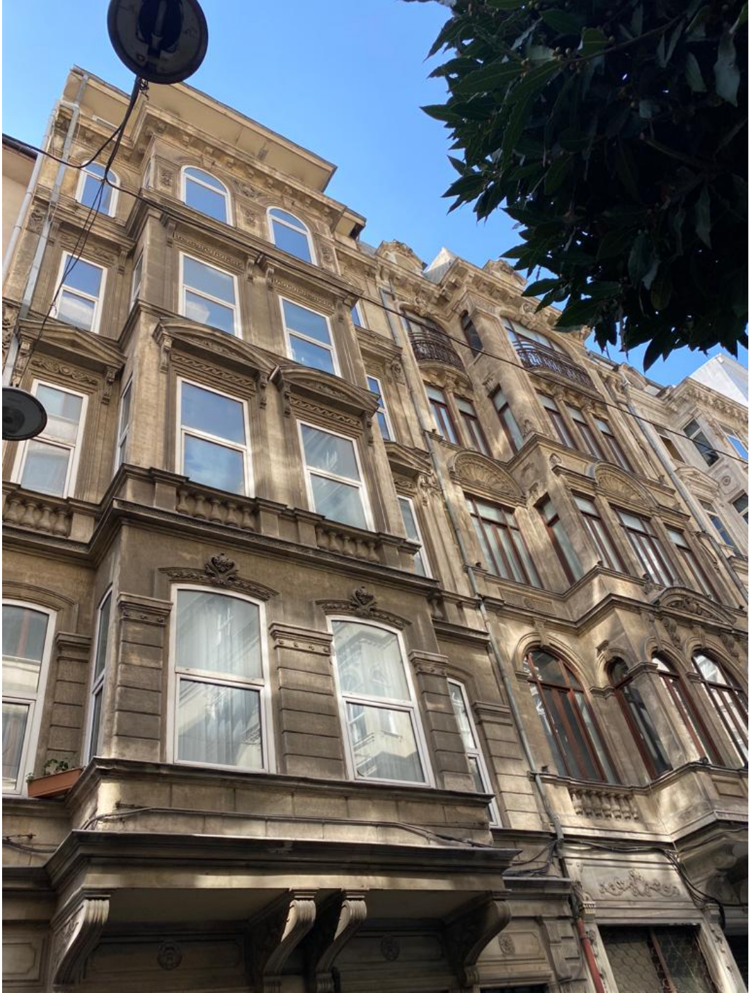
Şekil 5. Pera Bölgesi Yapılarından Görünüm -3-
