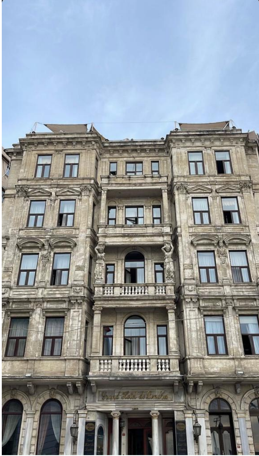
Şekil 3. Pera Bölgesi Yapılarından Görünüm -1-
