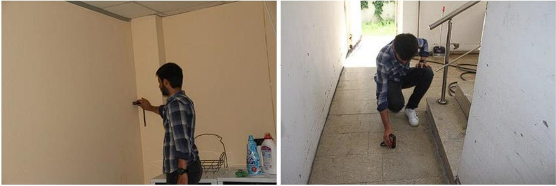
Şekil 51. Yerinde yapılan boyut kontrolleri
