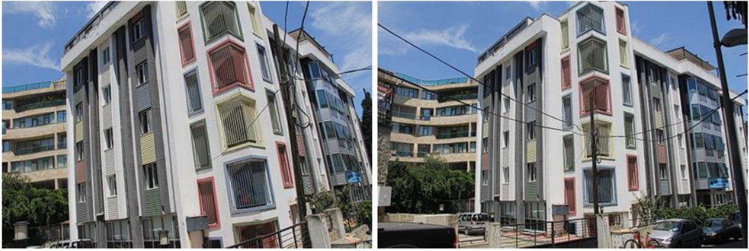
Şekil 1. İnceleme konusu binanın genel görünüşü
