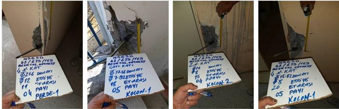
Şekil 40. Paspayı sıyırma işlemleri ile yapılan görsel donatı kontrollerinden örnekler
