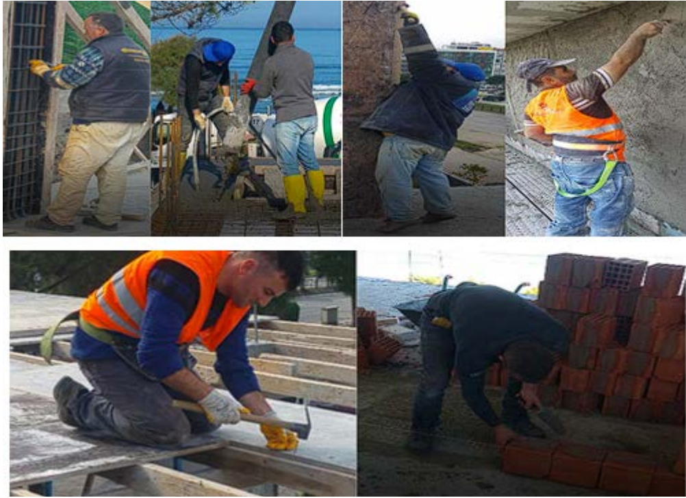
Şekil 51. Alt-Üst,Orta seviye yapılan inşaat işlemler (KILIÇ, 2021, KEE, 2022).
