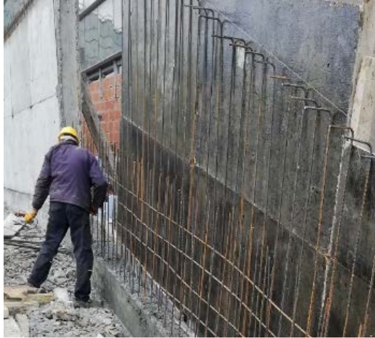
Şekil 76. Kalıp İşçisi – kalıp çakma
