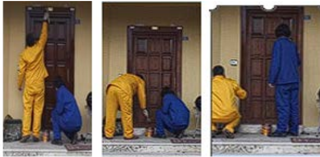
Şekil 42. Kapı boyama işlemi (ZENGİN ve ark., 2020).
