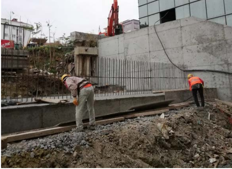
Şekil 72. Kalıp İşçisi - Çömelerek Çalışma
