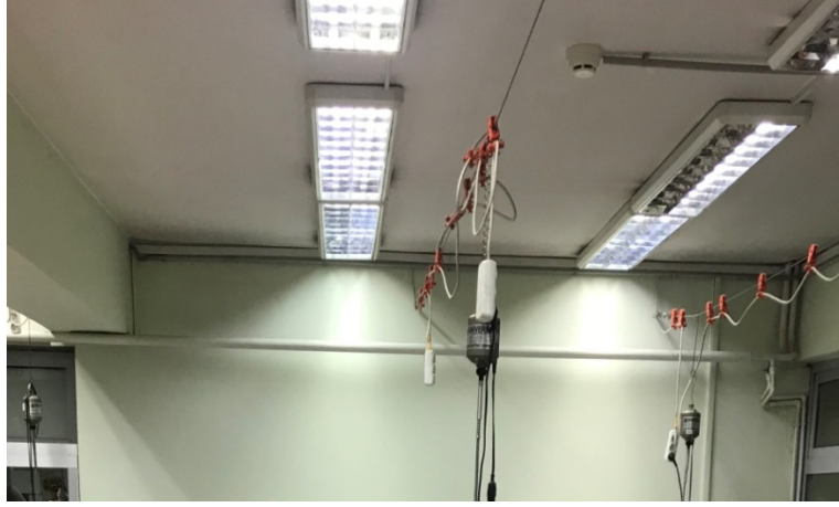
Şekil 33. Olması Gereken Güvenlikli Aydınlatma Lambası
