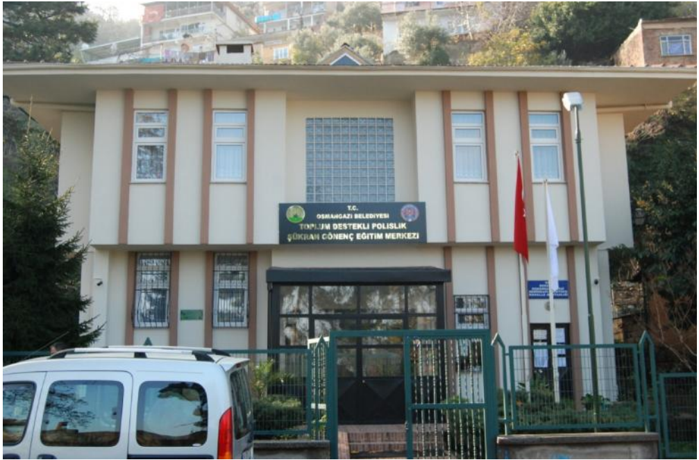
Resim 2 : ÇOGEP Proje Binası
