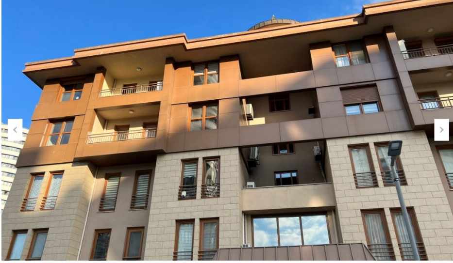
Şekil 66. Yalı Apartman - 1 Ön Cephe Görseli
