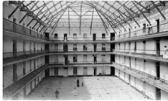
Şekil 17. Guise Sitesi, İç Avludan Bir Görünüm
